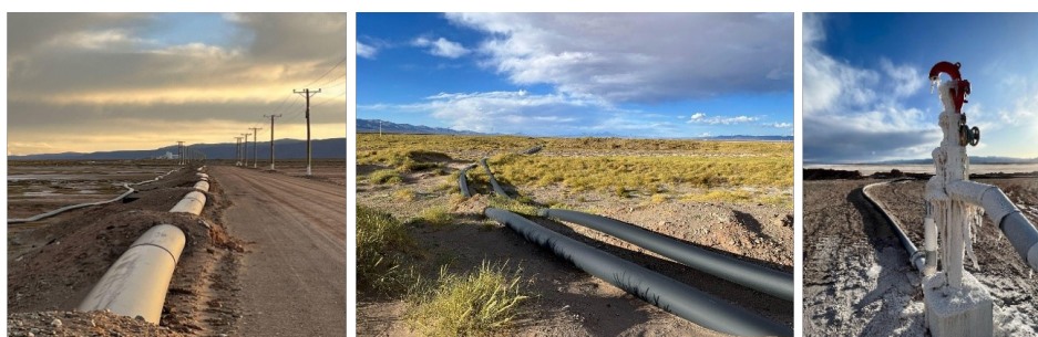
FIGURA 3. Infraestructura extractiva en el salar de Olaroz
