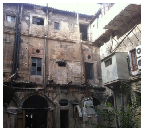
Claustro en estado de ruina
