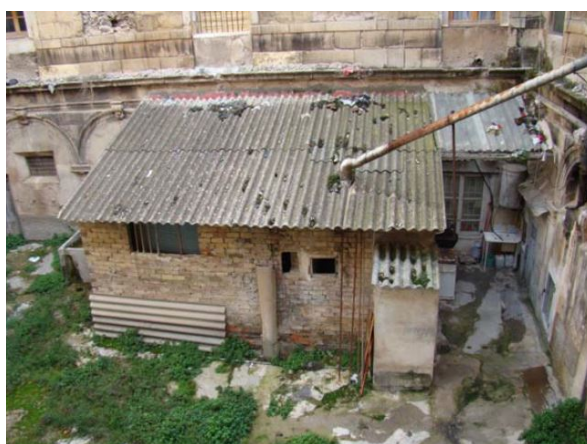
Claustro ocupado por construcciones
