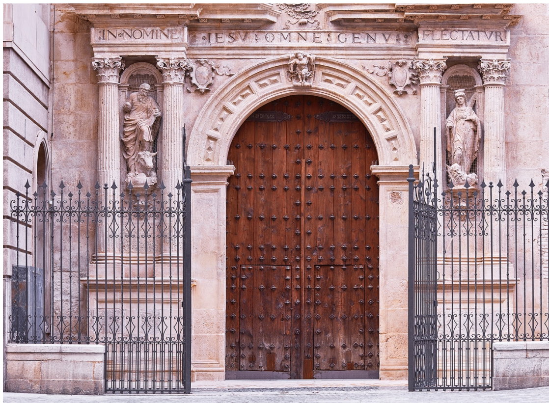
Foto 19 y 20. Terminación 2019. Portada restaurada (foto Pablo Almansa)
