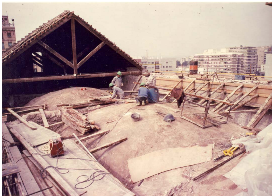
Foto 4 Desmontaje de cubierta 1981 (Archivo D.G. de Patrimonio)
