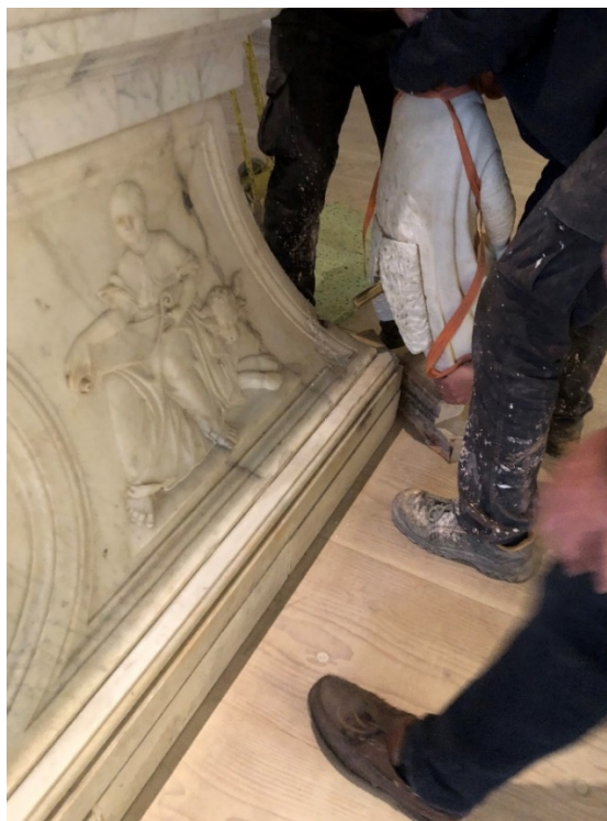
Foto 28. Presentación de los anclajes con el original
