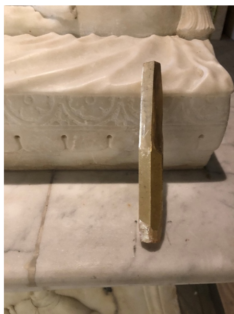
Foto 27. Moldes de los elementos de anclaje
