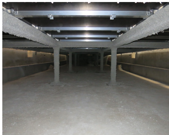
Foto 12 y13 Terminacion proyecto de estructura 2015. Forjado de elementos desmontables
