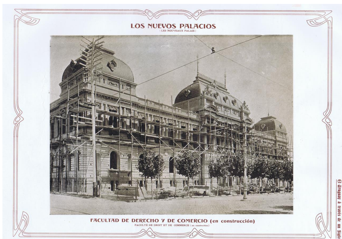
Figura 4. Facultad de Derecho, arquitectos J. Aubriot y S. Geranio, 1910. Fuente: Maeso, 1910.
