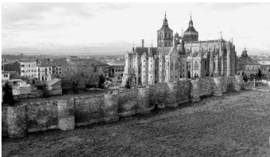
Fig. 4. Asturica Augusta. Vista aérea del exterior del sector oriental del circuito amurallado bajoimperial (fotografía: Archivo Exposición Astures, Fundación Municipal de Cultura, Gijón).
