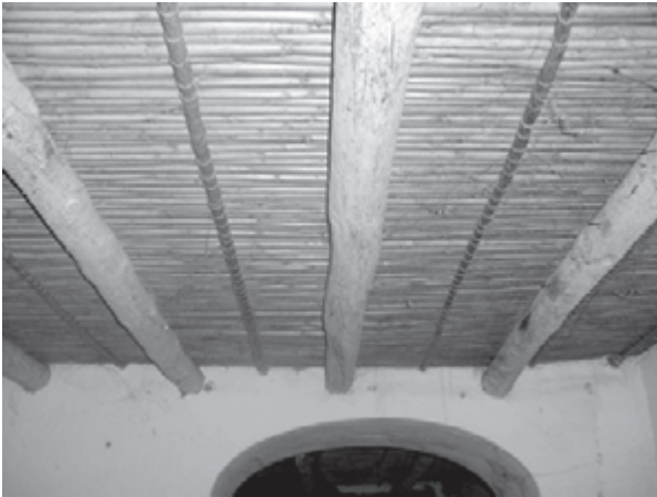
Fig. 3: El cañizo sobre rollizos de madera es el sistema estructural básico en las divisiones horizontales
