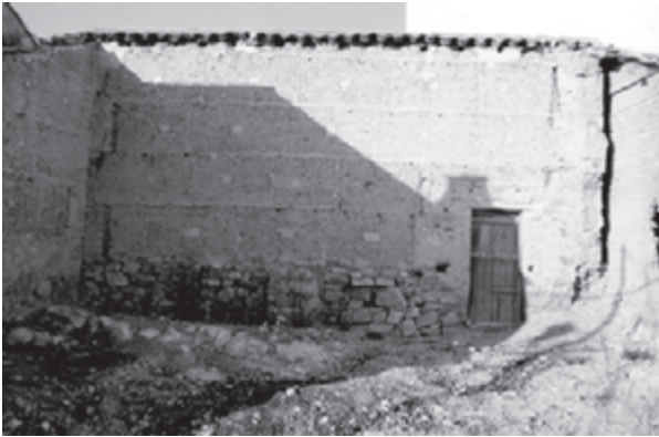
Fig. 2: Las bases constructivas se repiten a ambos lados de la frontera. El adobe y el tapial están presentes en la arquitectura tradicional
