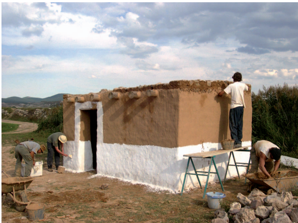
Fig. 4. Pequeña caseta realizada en Segeda Nova según los modos constructivos celtibéricos.
