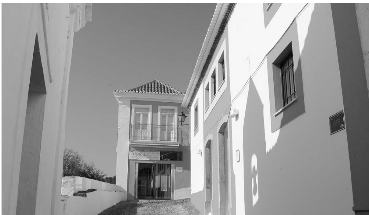
Fig. 11. Museu de Mértola: Arte Islâmica. Fachada principal.
