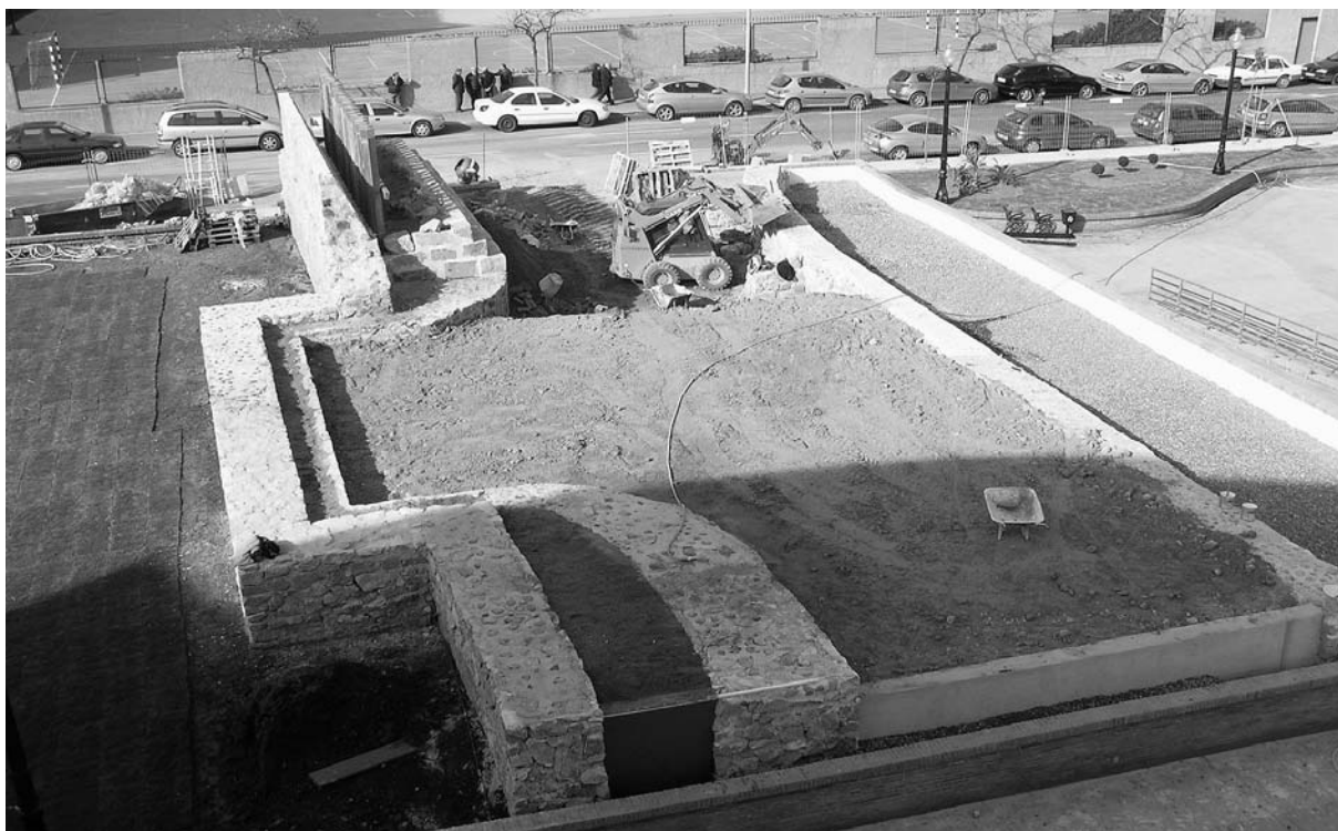
Fig. 2. Vista general del baluarte de la Princesa una vez reubicado sobre la nueva plaza pública (La Línea de la Concepción, Cádiz, 2006).
