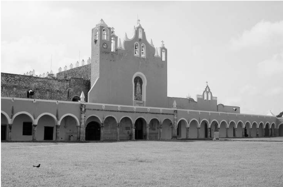
Fig. 3.—Izamal. Convento de San Antonio de Padua.
