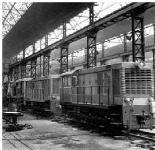
Fig. 8. Locomotoras Diesel Batignolles en la sala de ensamblaje de CAF
