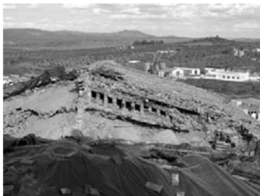
Fig. 4. Bóveda con relleno cerámico. Parroquia de San Blas (Salvatierra de los Barros) (Foto J. D. Carmona)
