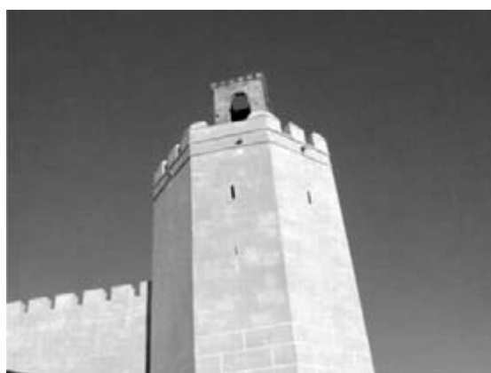
Fig.4. Torre de Espantaperros restaurada 42
