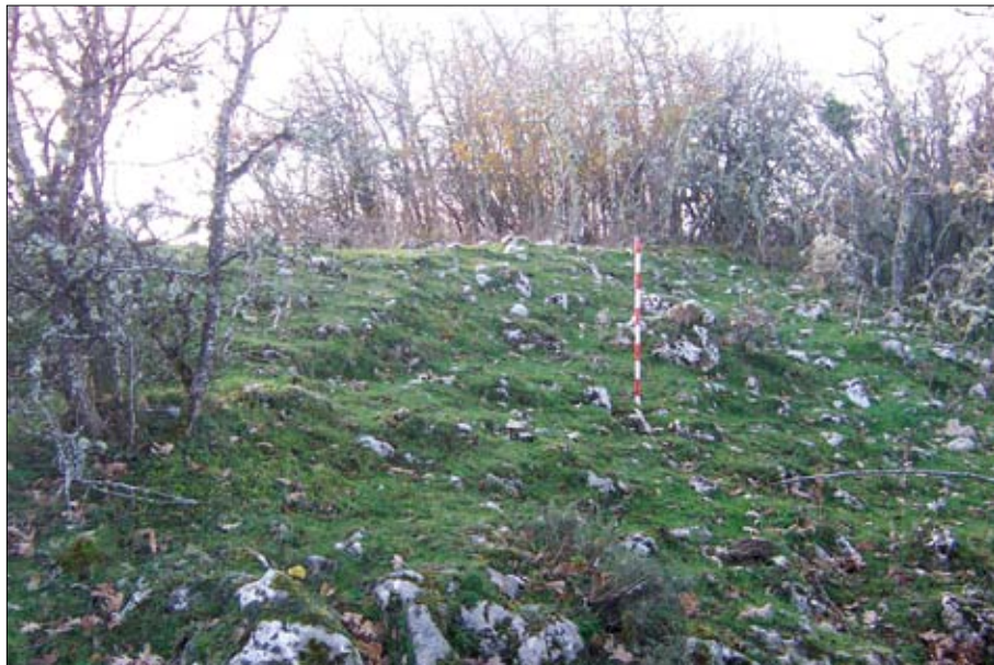
Imagen 1. Detalle de la estructura y derrumbe de la muralla.
