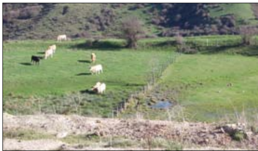
Imagen 2. Vista general del talud desde el oeste.
