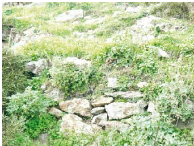
Imagen 1. Aspecto del muro de contención de uno de los aterrazamientos de la cara sur.
