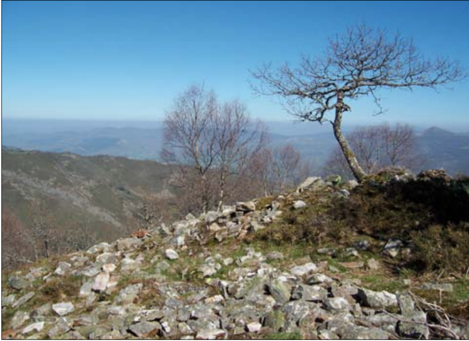
Imagen 2. Derrumbe de muralla en el flanco N.
