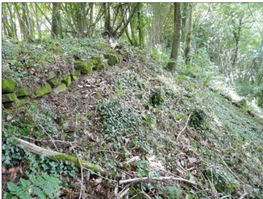
Imagen 2. Cumbre de la muralla y talud de derrumbe a sus pies, en el flanco norte.
