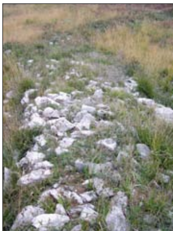
Imagen 1. Detalle de la estructura
