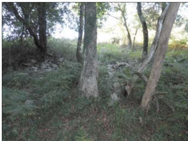
Imagen 2. Derrumbe de muralla de la cara sur.
