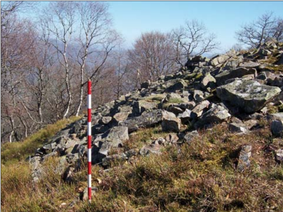
Imagen 3. Detalle del gran derrumbe que ciñe el lado NE.
