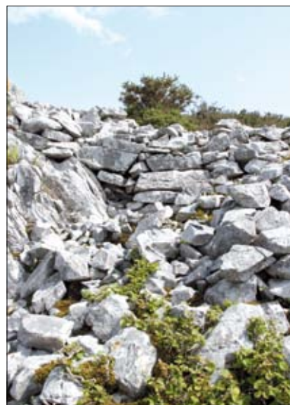
Imagen 4. Lienzo de muralla en el sector NE.
