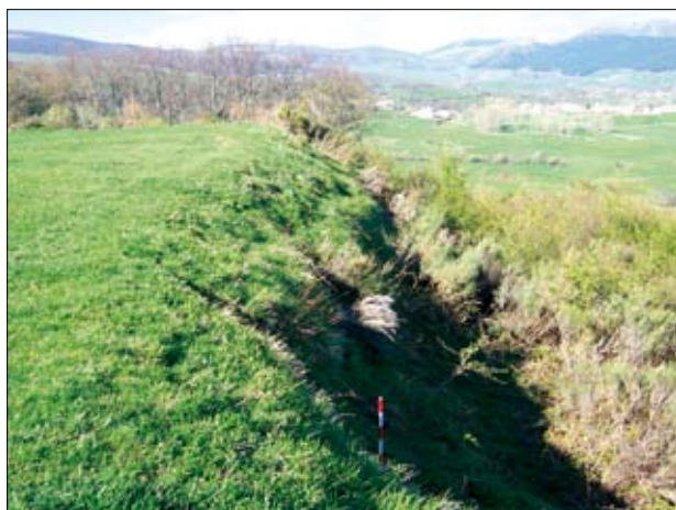
Imagen 1. Aspecto del talud que rodea la cima.
