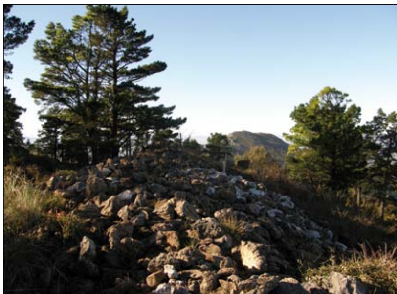
Imagen 10. Derrumbe de muralla de la línea defensiva exterior por el norte.
