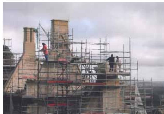
Los "échafaudages": empieza la restauración
