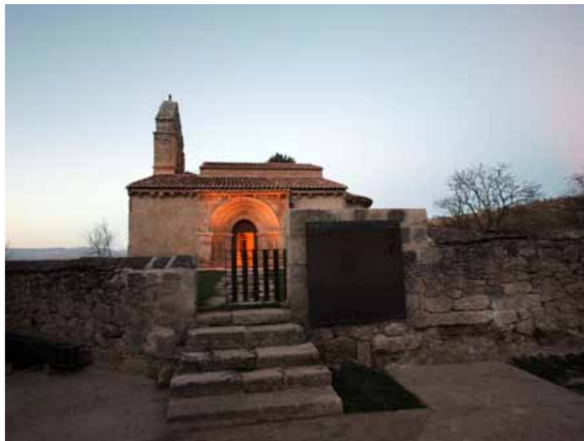
Gama (Palencia). Exterior de la iglesia después de la restauración.
