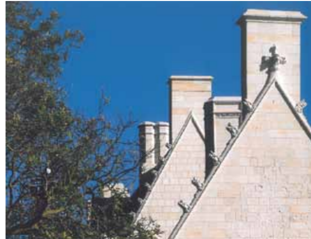
Detalles de la cubierta "crochets de rondelis"
