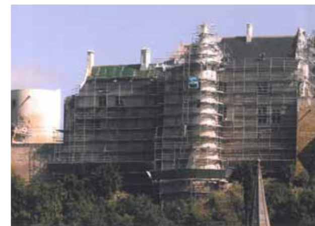
Las fachadas y la cubierta están casi rematados
