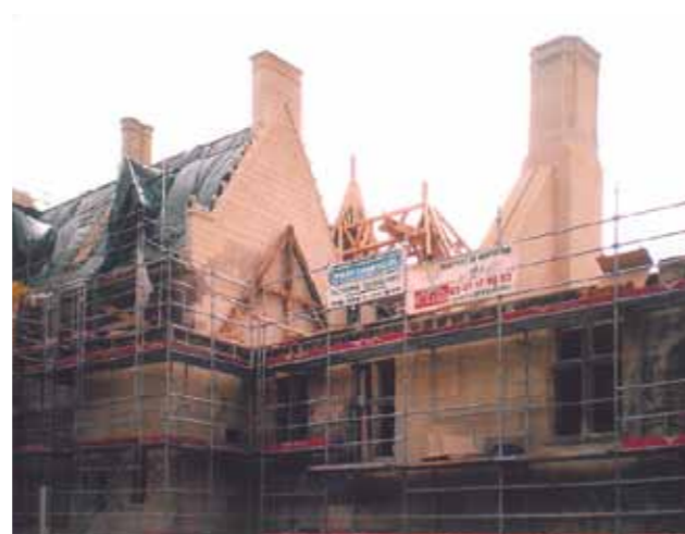
Trabajos en las cubiertas del edificio
