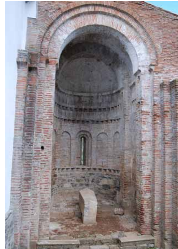
Ábside de la nave Sur del Monasterio de San Salvador en Castro Avelas, junto a Braganza (Portugal). Ejemplo de proporción Cluniacense.
