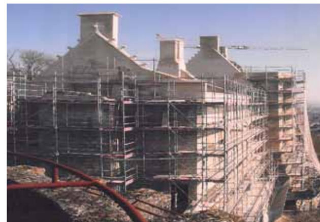
Finalización de la obra de cantería
