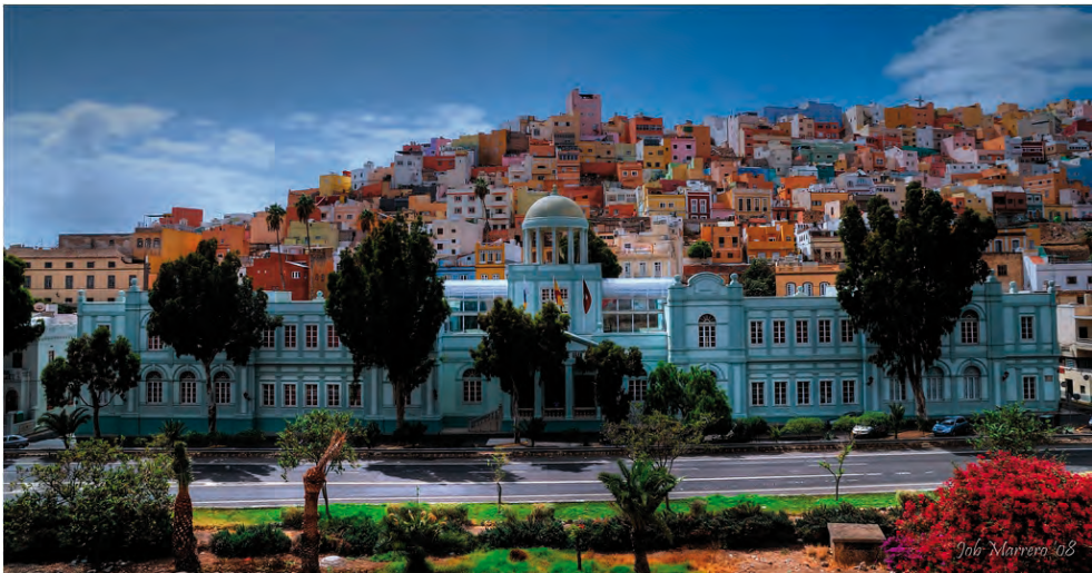
Fig. 13 Rectorado de la Universidad de Las Palmas de Gran Canaria ubicado en el antiguo Hospital Militar
