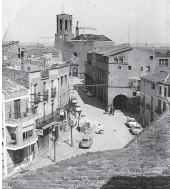
Església en obres, sense teulada, cap al 1970
