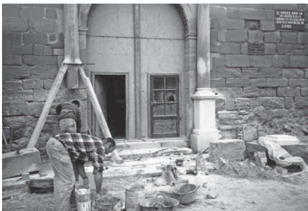
Obres a la portada dutes a terme entre 1995-1996
