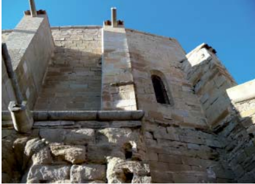
Detall dels contraforts exteriors
