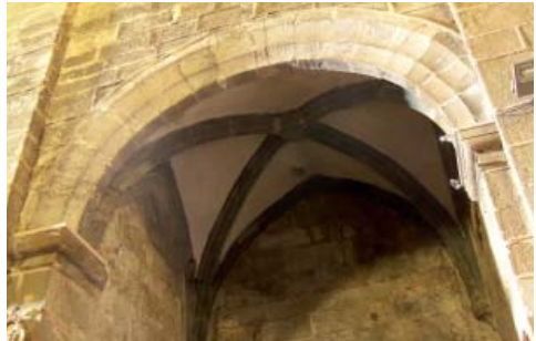
Capella lateral amb volta de creueria maçonada
