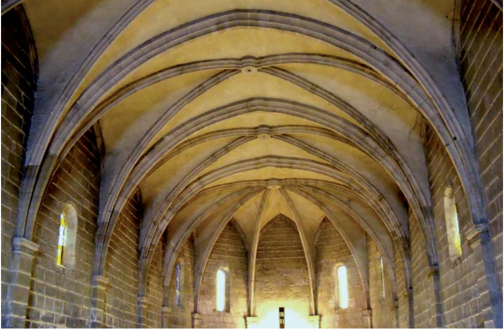
Detall de la volta amb les nervadures imponent a les pilastres
