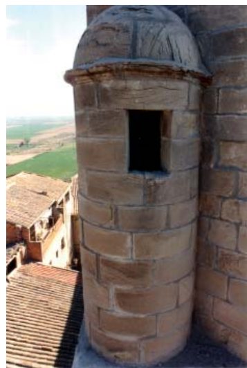
Detall d'un dels comunidors vist des de l'exterior
