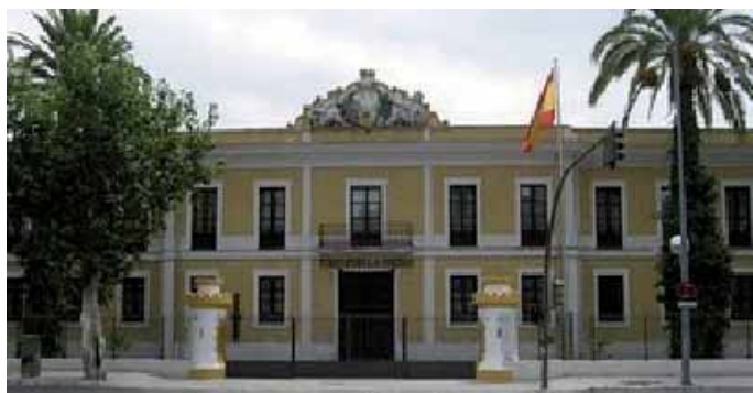
Fig. 2: Cuartel del Batallón de Zapadores Minadores nº 2 de Sevilla en la Avda. de la Borbolla
