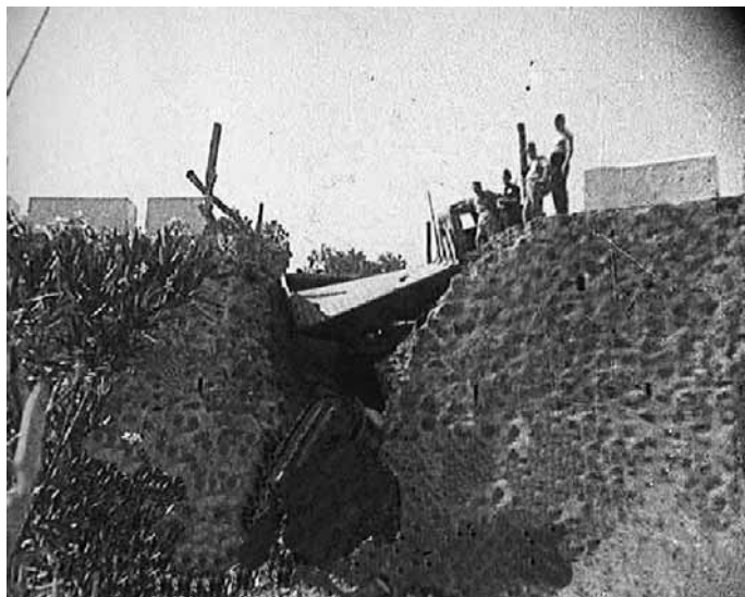
Fig. 1: El Ronquillo (Sevilla). Mañana del 16 de agosto de 1936. Fotograma de René Brut. Detalle de la alcantarilla volada en la carretera de Sevilla a Badajoz
