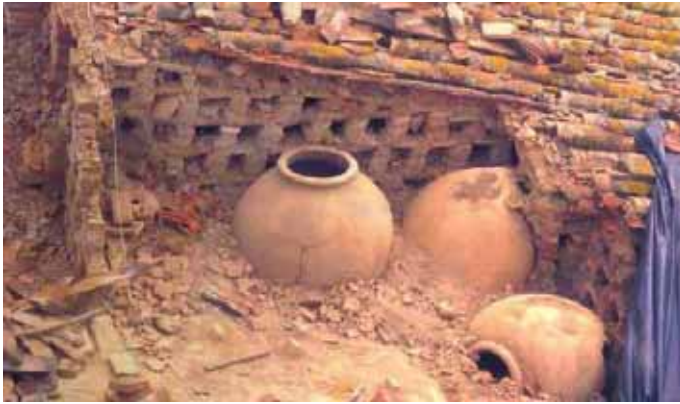
Fig. 4: Bóveda de la Parroquia de San Blas (siglo XVI)
