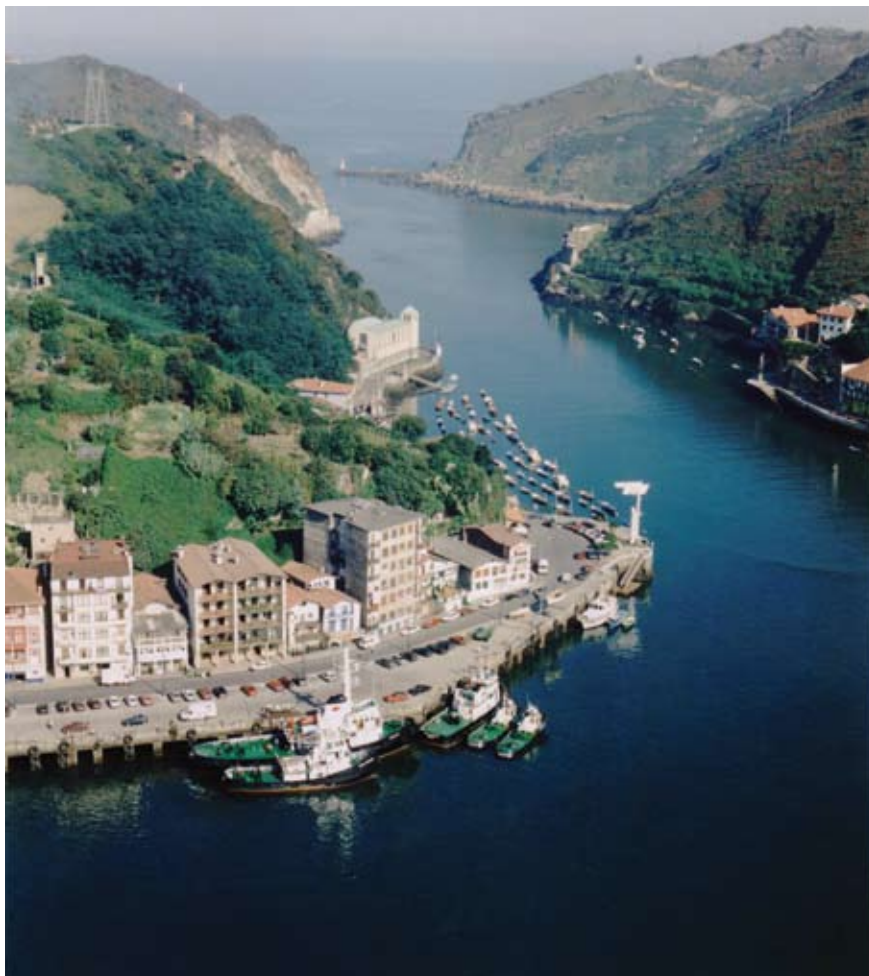
Imagen 39. Vista aérea de los remolcadores atracados al puerto de Pasajes. Años noventa pág.39
