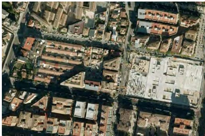
Fig. 19. Colada Real de los neveros, a su paso por el barrio del Zaidín, Granada. Nótese la interrupción de la trama heterogénea del ensanche con el trazado de la cañada. Sin embargo, no posee un tratamiento que la distinga a nivel peatonal como elemento urbanizado (im.google maps)
