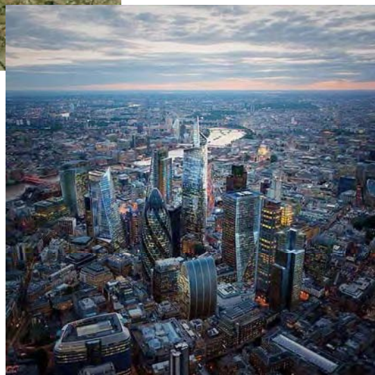
Fig. 9. El CBD londinense para 2015. Ciudad únicamente sustentada mediante la importación absoluta de energía y materia (Floren Román, 2010)
