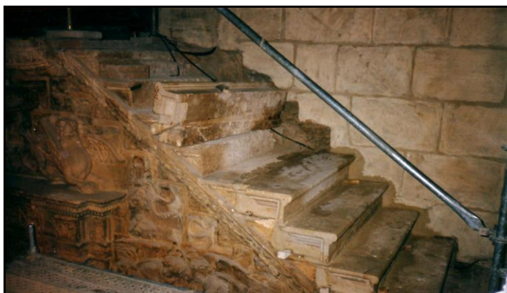
Ilustración 2.- Proceso de sustitución del peldañeado en el tramo superior derecho de la Escalera Dorada. Catedral de Burgos. Fotografía cortesía de CPA.
