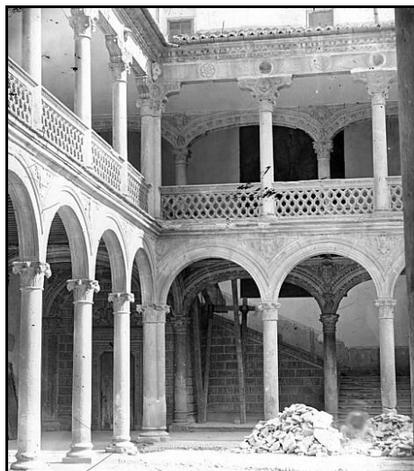
Ilustración 3.- Vista de la escalera inmersa en plena restauración, hacia 1880-1882, en la que se aprecia la inexistencia de su balaustrada. Palacio Arzobispal de Alcalá de Henares, Madrid. AMT. Colección Casiano Alguacil, CA-0515-VI.
