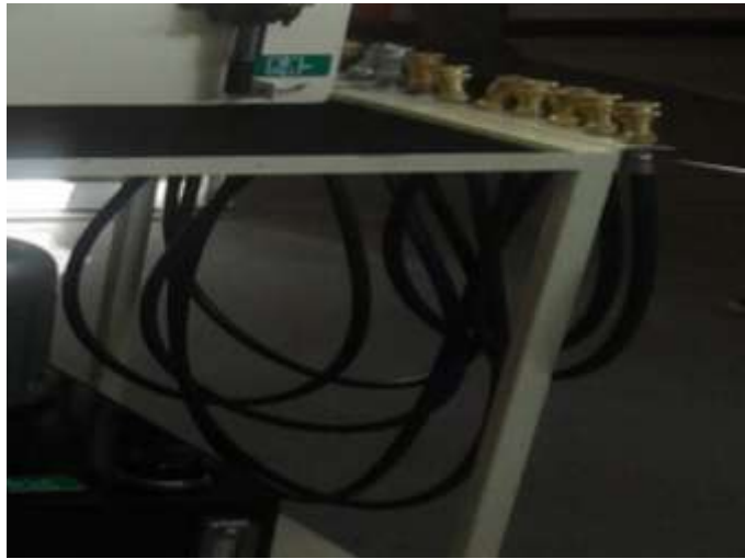
Figura 19.5 Instalación de almacén de mangueras
