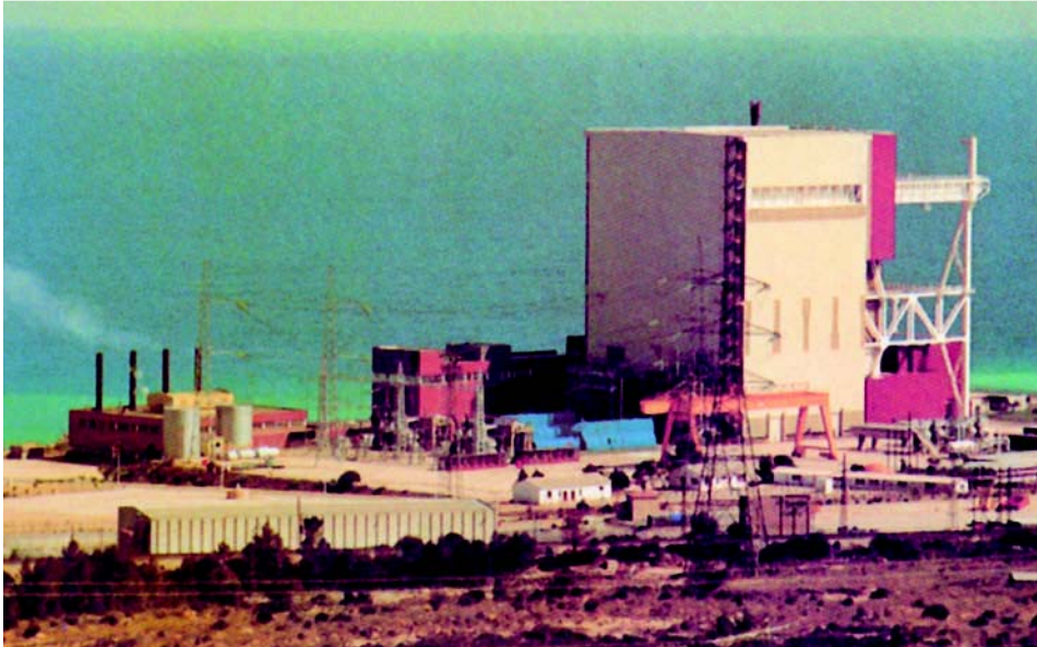
Figura 1.- Central nuclear Vandellós I.
