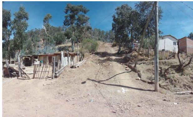
Figura 24.10 Vivienda en la Zona de Lechuguillas
