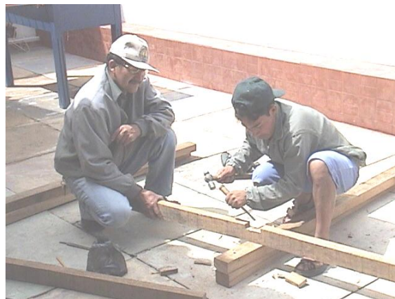
Figura 11.1 Preparación de Armazón de madera (tipo caballete)
