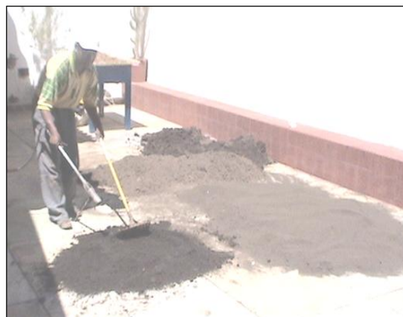
Figura 11.3 Desinfección física del sustrato activo
