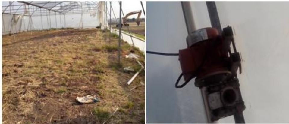
Figura 28.1 Falta de instalación eléctrica y sistema hidráulico incompleto
