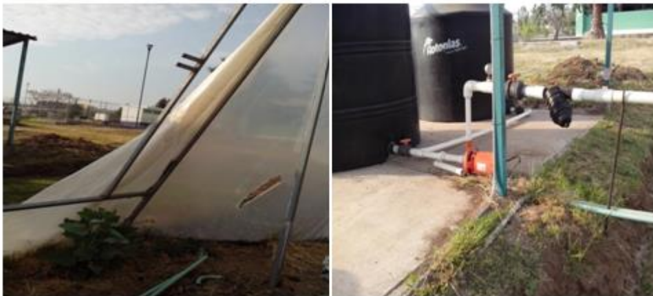
Figura 28.1 Falta de instalación eléctrica y sistema hidráulico incompleto
