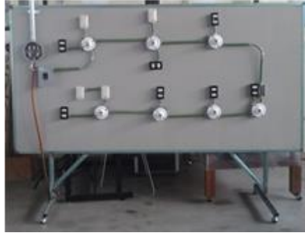
Figura 11.2 Instalación eléctrica construida
