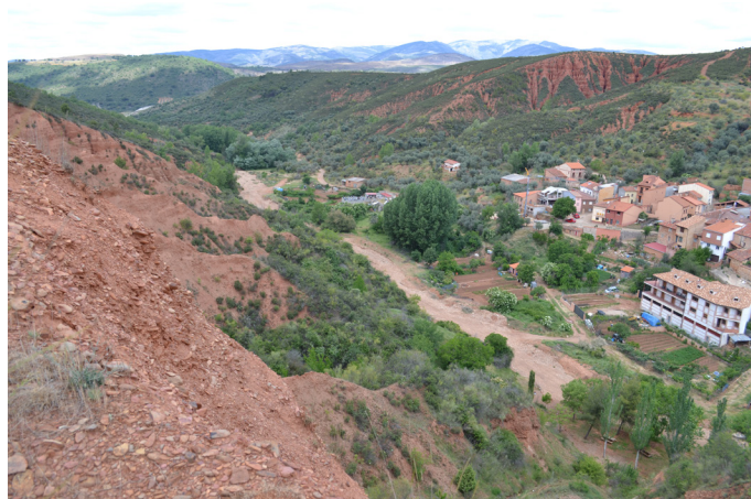
Figure 3. Aspecto del paso del Arroyo del Lugar en Puebla de Valles (Guadalajara).
