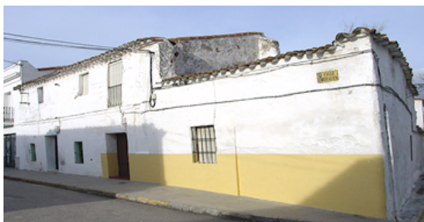
Fig. 2: Llerena. Casas de don Rodrigo de Cárdenas
