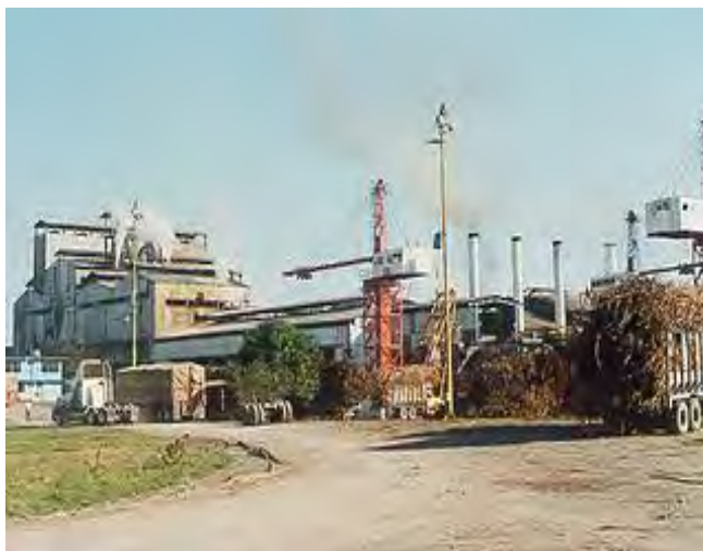
Figura 7. Vista de un patio de caña con operaciones de descarga a mesas y con operación de descarga al piso, al centro una grúa radial
