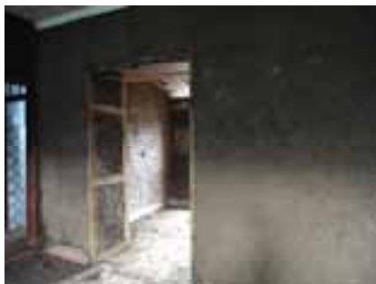
Fig. 11. Revoco en paredes de adobe. refuerzo de cargadores. Foto: Casa Don Domingo Gonzáles, tomada por la autora.
