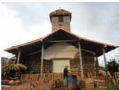
Fig. 19. Fachada principal de la iglesia. Se ha removido el repello de concreto para sustituirlo por revoco de barro. Foto: Iglesia El Carmen de San Miguel tomada por la autora.
