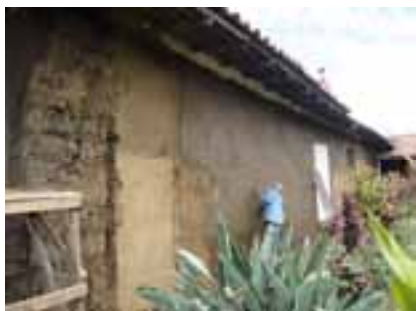
Fig. 21. Revoco de barro en sus diferentes capas y composiciones. Colocado a mano luego del podrido de la tierra y añadido el pasto. Foto: Iglesia El Carmen de San Miguel tomada por la autora.
