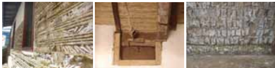
Fig. 4 (izquierda) Típica pared de bahareque con caña de castilla e incrustaciones de teja para ayudar a la compactación del barro de relleno. Foto: Antigua Escuela Moya tomada por la autora
