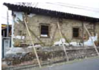
Fig. 15. Proceso de apuntalamiento para la sustitución de piezas dañadas. Foto casona de Tres Ríos tomada por la autora.
