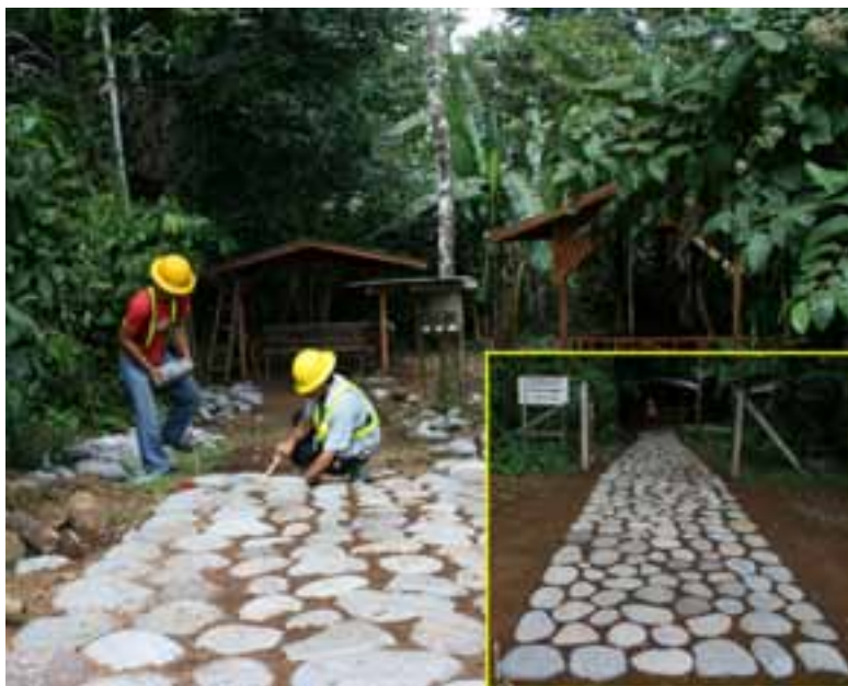
Fig.n° 3 Proceso de elaboración de una calzada En la esquina inferior derecha al finalizar la construcción.
