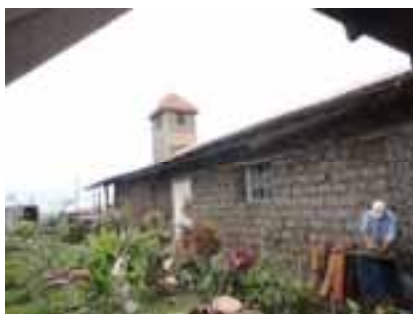
Fig. 19. Fachada principal de la iglesia. Se ha removido el repello de concreto para sustituirlo por revoco de barro. Foto: Iglesia El Carmen de San Miguel tomada por la autora.
