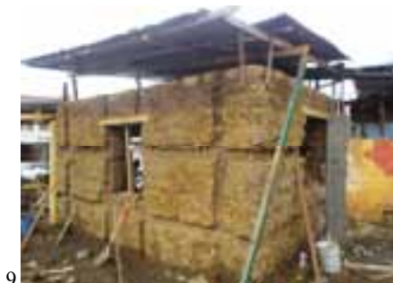
Fig. 9. Interior de modulo de adobe independiente de la Casona. Reforzamiento de paredes, colocación de nuevos adobes en cargadores dañados y cambio de cubierta. Foto: Casa Don Domingo Gonzales, tomada por la autora.
