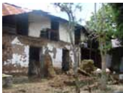
Fig. 17. Fachada interior deteriorada. Nótase que la planta alta en bahareque estaba prácticamente destruida. El adobe se encontraba en excelentes condiciones. Foto: Casa Jenaro leitón tomada por la autora.
