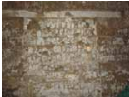
Fig. 21. Revoco de barro en sus diferentes capas y composiciones. Colocado a mano luego del podrido de la tierra y añadido el pasto. Foto: Iglesia El Carmen de San Miguel tomada por la autora.
