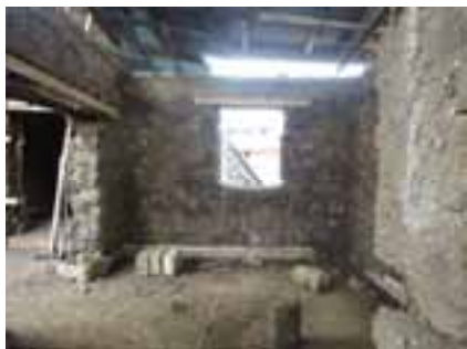
Fig. 9. Interior de modulo de adobe independiente de la Casona. Reforzamiento de paredes, colocación de nuevos adobes en cargadores dañados y cambio de cubierta. Foto: Casa Don Domingo Gonzales, tomada por la autora.
