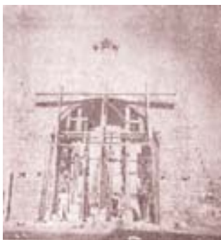
Fig. 1. Lugar donde se encontraba la Puerta de Mar antes de su reconstrucción y el proceso de ésta realizado en la década de los cincuenta del siglo XX. Fuente: Foto del Archivo Cava, s/f y Campeche Nuevo, 1955.
