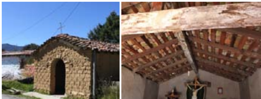
Edificación vernácula, vistas exterior e interior, el Punto Ixtepeji, Sierra Norte de Oaxaca, utilizada actualmente como capilla. Fuente: Autor/2011.
