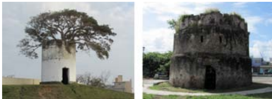
Fig. 6. En la ruta por Orizaba es posible localizar diversos ejemplos de la arquitectura militar que hasta el momento no han sido debidamente estudiados, como el torreón de Tejería y el fortín de Paso del Macho, construido entre 1836 y 1838. Fotos: Sergio Vargas, 2012.
