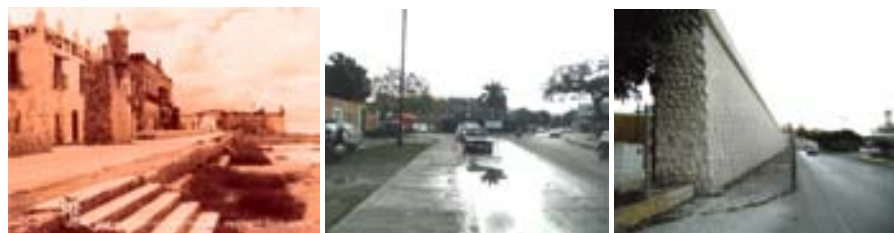
Fig. 7. Antes y después de la reconstrucción de lienzos de muralla en Campeche. Fuente: Foto del archivo fotográfico de la autora, 2013.
