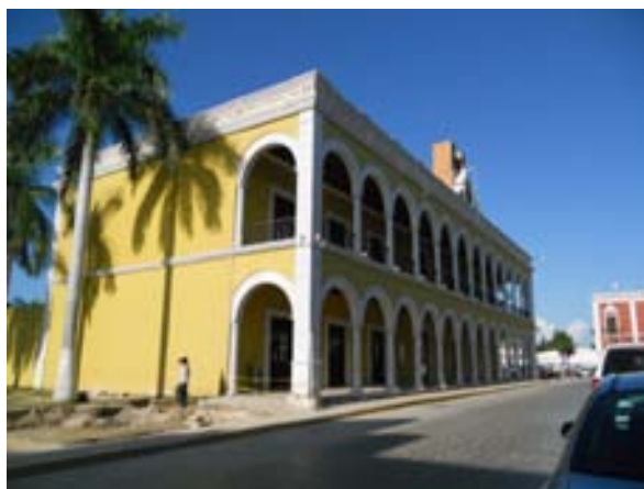
Fig. 4. Reconstrucción del antiguo Palacio de los Poderes, actualmente Biblioteca Campeche, con la obra de reconstrucción en proceso de la Aduana y las Atarazanas en cada uno de sus costados. Fuente: Foto del archivo fotográfico de la autora, 2013.
