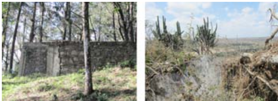
Fig. 11. Restos de la fortificación del Cerro del Borrego en Orizaba, y del polvorín de Fernando VII, en Puente Nacional. Fotos: Sergio Vargas, 2012.
