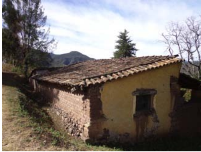
Edificación vernácula abandonada, comunidad de Santa María Yahuiuche, Sierra Norte de Oaxaca. Fuente PASC/2012.
