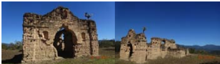
Vestigio de templo construido con adobe, comunidad de Santa María Ixtepeji. Autor. 2013.
