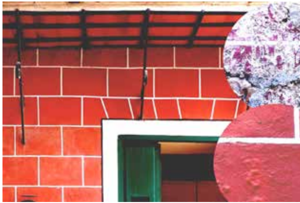
Fig.6: Restauración del color original con la intención de recuperar la imagen cromática primigenia, cuyos vestigios fueron encontrados al eliminar el revoco (ver detalle derecho superior) en la casa del Conde de Villanueva, en el Centro Histórico de La Habana. (Foto: Autor)
