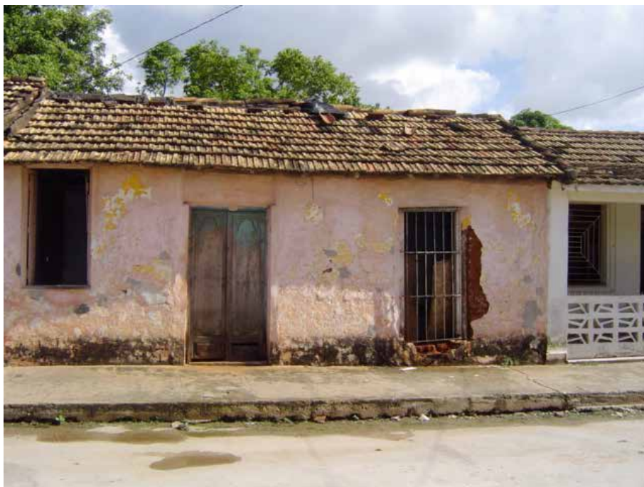
Fig. 2 – Casa de adobe, única evidencia documental de su aplicación en Trinidad Autor. Duznel Zerquera Amador
