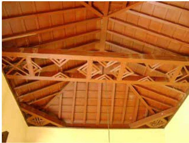
Fig. 4.- Techo de armadura de madera. Foto del Arq. Admel Pérez Oliver, 2014.
