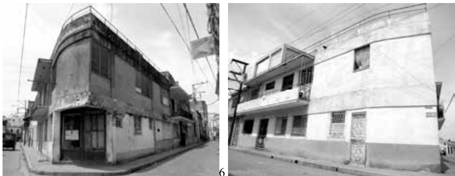
Fig. 6 – Edificio Arango, Popular esquina a Lope-Recio (1955).[Foto: Diango Esquivel Andino, 2011]; Fig. 7 – Edificio Betancourt, Hermanos Agüero esquina a Hospital (1956-1957).[Foto: Diango Esquivel Andino, 2011]
