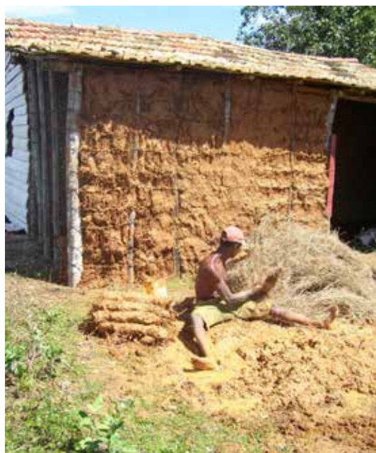
Figura 6 –Construcción de una casa de embarro. San Pedro, 2010. Autor. Duznel Zerquera Amador
