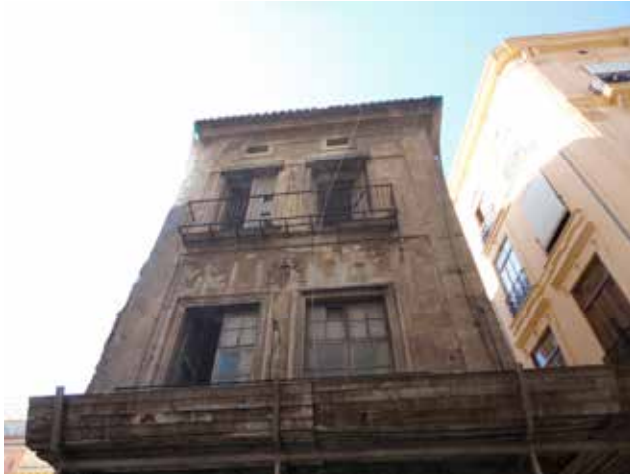
Fig. 1 – Vista fachada de la Casa del Relojero de Valencia, donde se encuentra el escudo protegido [Francisca Ramón Fernández, 2011]
