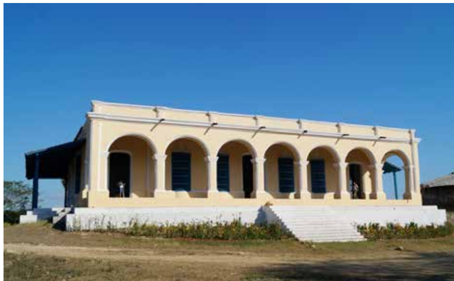
Fig. 3 – Hacienda Guáimaro Valle de los Ingenios, Trinidad, Cuba. Autor. Duznel Zerquera Amador
