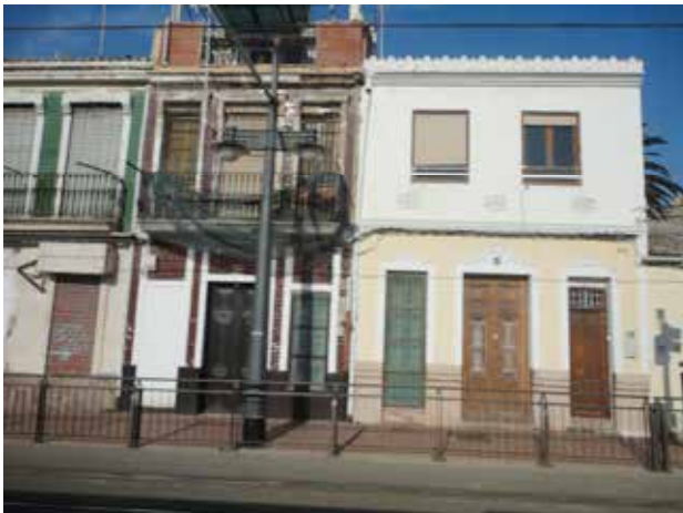
Fig. 5– Barrio de El Cabanyal de Valencia. Detalle de construcción típica [Francisca Ramón Fernández, 2012]
