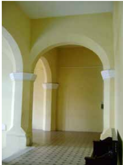
Fig. 2.- Estructura de arcos y columnas. Foto del Arq. Admel Pérez Oliver, 2014
