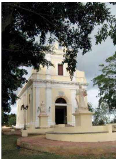
Fig. 1 – Ermita de Monserrat, luego de ser intervenida, enero 10 de 2010.
