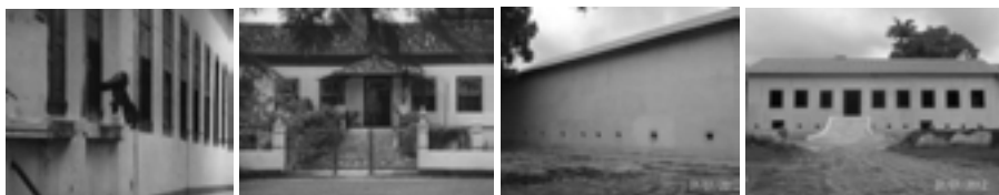
Imágenes de la arquitectura intacta de la Hacienda todavía y imágenes hechas después de las obras, en 2012.
