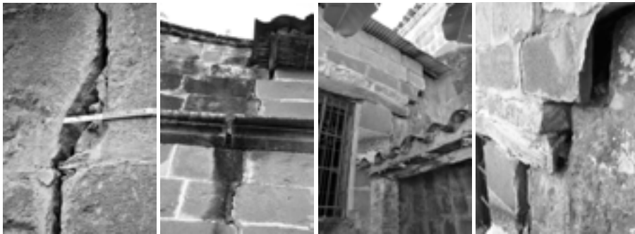
Ampiezza delle fratture di distacco della Cappella laterale. Separazione del folio per inserzione vegetale
