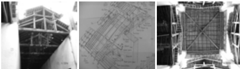
Estructura cubierta Cercha Rey.
