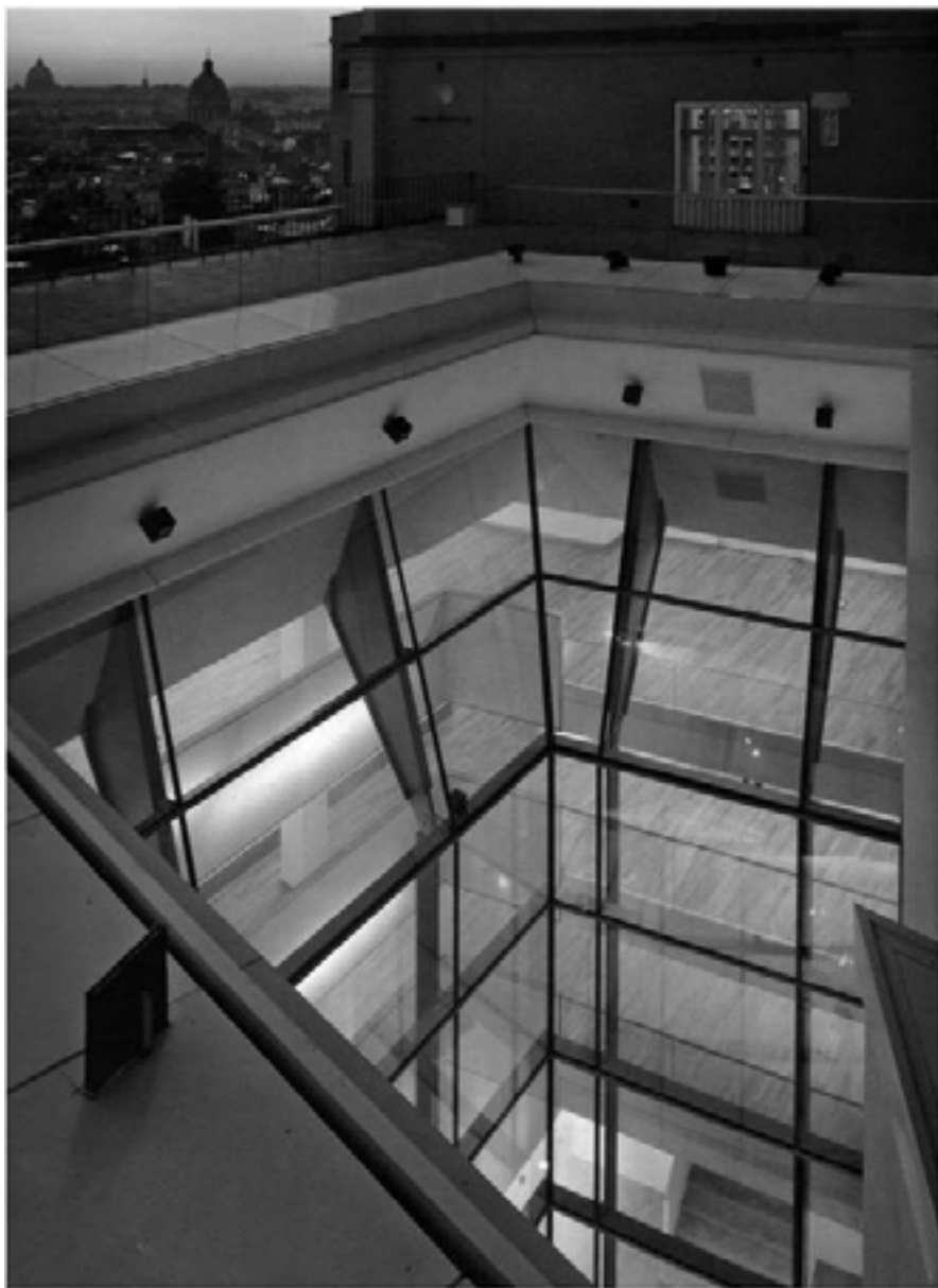
Veduta della terrazza in copertura
