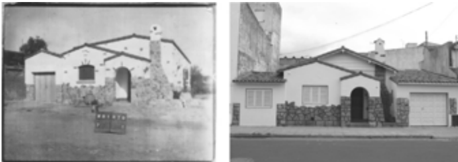
Imagen 5. Chalet “estilo Mar del Plata” ubicado en el barrio La Perla (calle Jujuy al 300) en estado original (finalizado en 1935) y en estado actual. Fuente: Fotografía de la cédula catastral del Archivo de Catastro de la Municipalidad local y fotografía propia.
