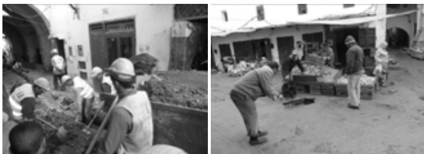
Obras en la Medina de Tetuán. Sustitución de la red de Skundo por tuberías de plástico y problemática generada a la venta en el escenario urbano
