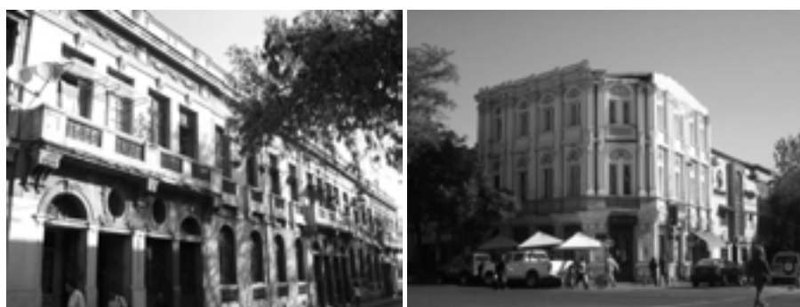
Fig. 10 – Gli edifici plurifamiliari di taglio “accademista”
