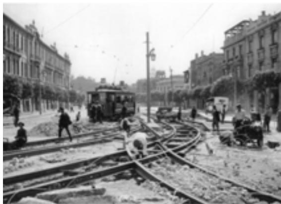
Fig. 3 - Lavori di realizzazione della tramvia urbana.
