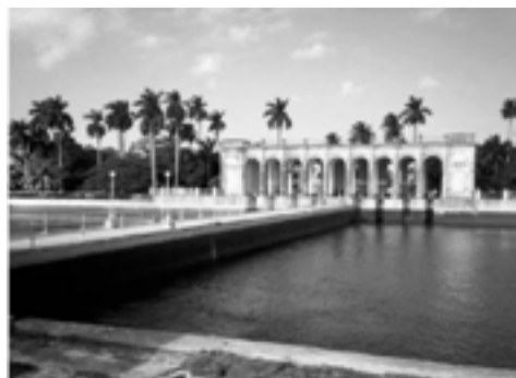
Tanques de Palatino del Acueducto de Albear
