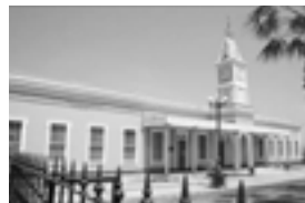
Casa de Administración de Estación de Ferrocarril
