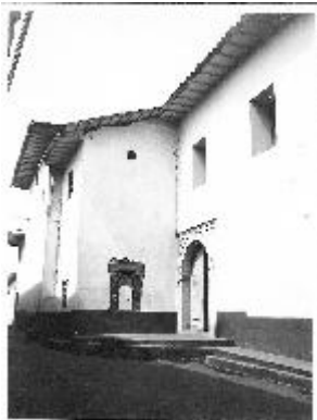
Vista desde la Calle Séptima, junto a la entrada de la Capilla de Los Remedios. Nótese el "apéndice" en dos pisos que se le había adosado
