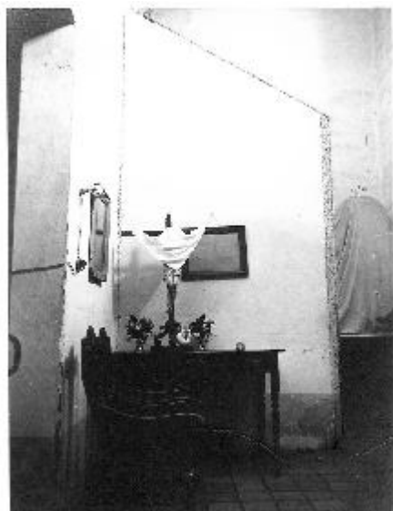
Interior de la sacristía adaptada. Obsérvese el contrafuerte.
