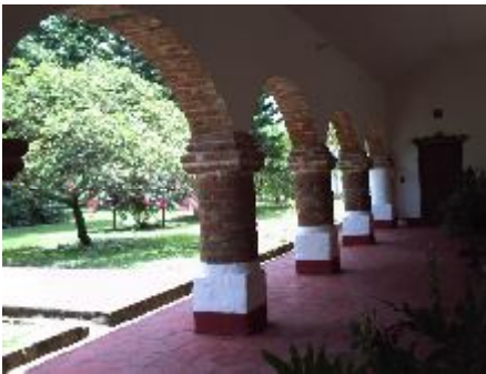
Casa Cural después la restauración. Fachada y arquería interior
