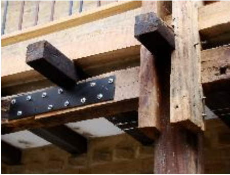
Estructura madera reciclada
