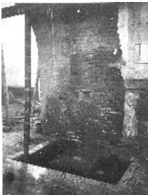
Una de las bases del arco toral encontradas bajo el piso de baldosín Esta corresponde al lado de la Capilla de "San Juan de Letrán"
