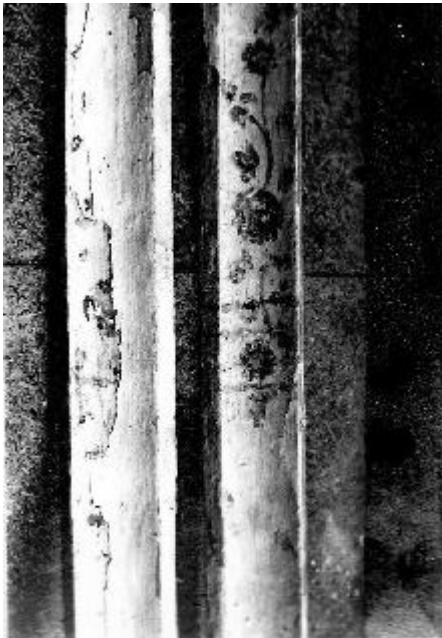
Estado del listón antes y durante el proceso de restauración.
