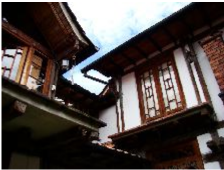
Fachada de uno de los patios
