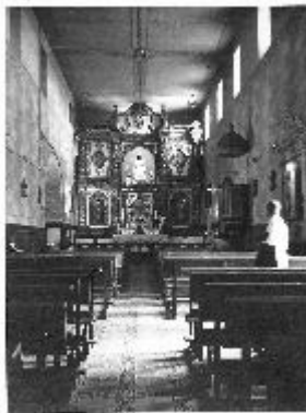
Interior de la Capilla con anterioridad a la restauración. Obsérvese el cielo raso plano
