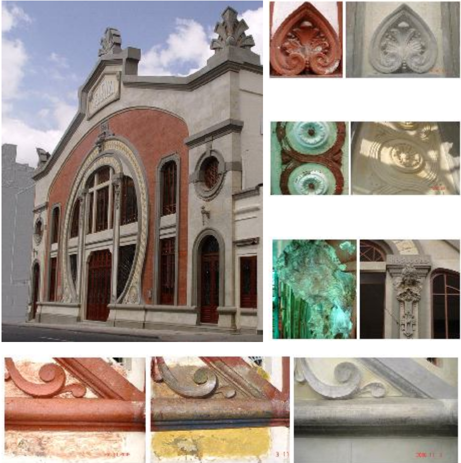
Fachada y detalles ornamentales de la misma, procesos de limpieza y restauración antes y después de 2007. Fuente: Archivo equipo de restauración
