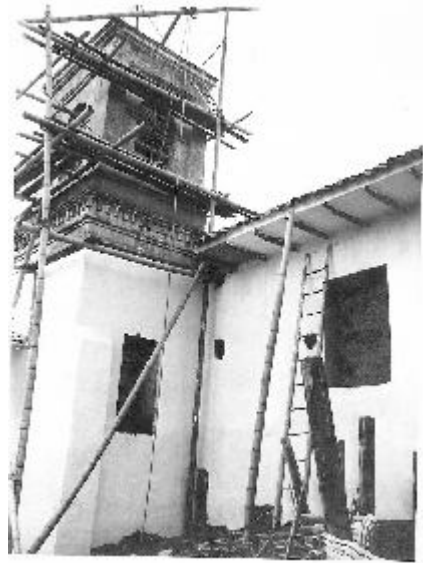
Restauración de la torre. Estudio para determinar la altura del cono.
