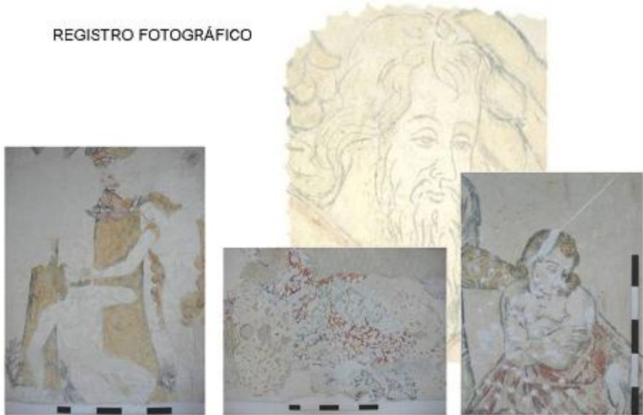
Principales deterioros de la pintura mural
