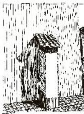
Vista del contrafuerte una vez demolida la sacristía
