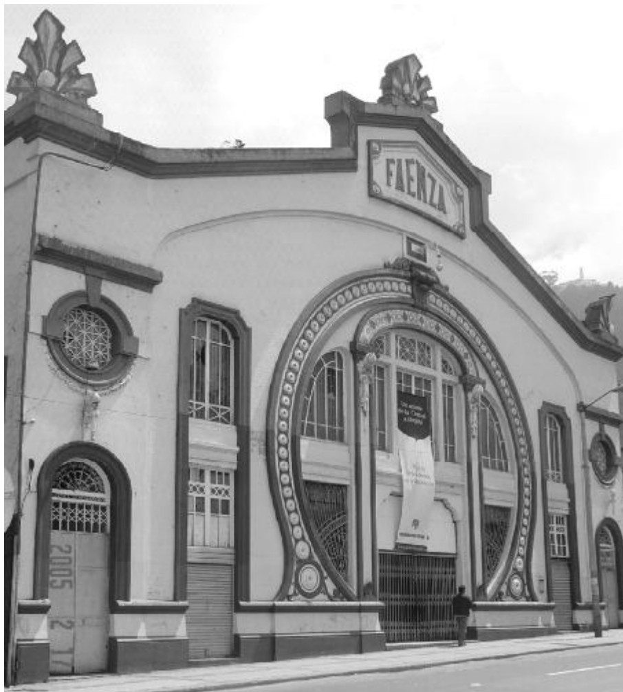
Estado de la fachada en 2005. Fuente: Archivo equipo de restauración
