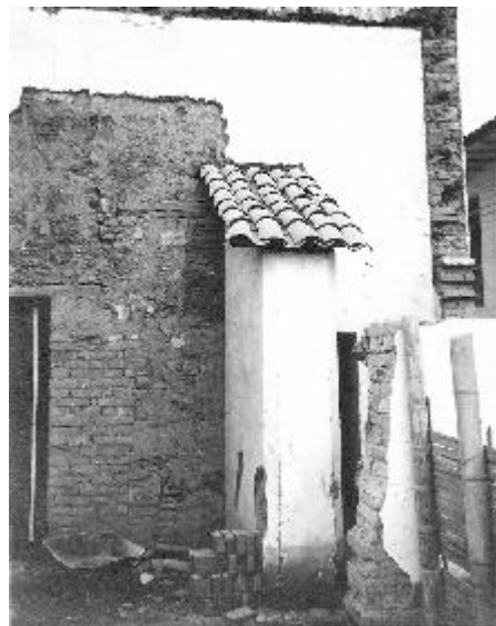
Vista del contrafuerte una vez demolida la sacristía adaptada.
