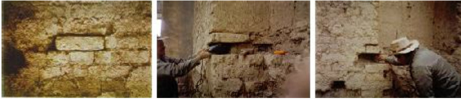
Figura 3. Capilla doctrinera de Tausa Vieja - Proceso de extracción de unidades de adobe.
