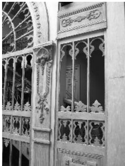
Detalle durante la restauración
