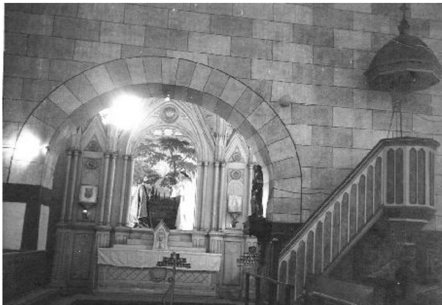
En esta foto puede apreciarse como era el púlpito y comulgatorio antes de ser retirados. Obsérvese también la pintura “imitación bloque piedra” que se había aplicado sobre los muros de tapia pisada.
