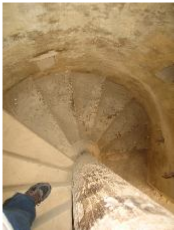
Escalera con columna central en madera y pasos en piedra
