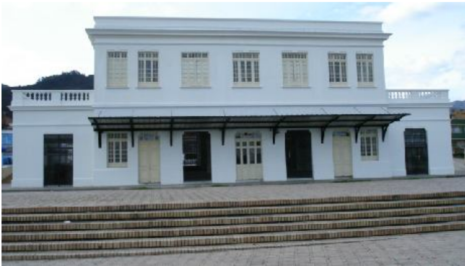
La estación de Zipaquirá después la obra de restauración (Foto: archivo privado)
