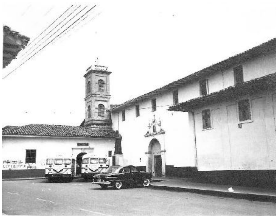
Estado de la iglesia antes de iniciarse la obra Obsérvese que la base de la torre no es visible desde la plazoleta.
