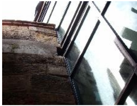
Detalle muro en piedra y edificio nuevo
