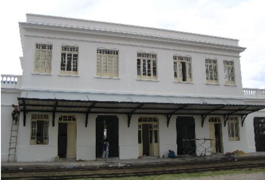
La estación de Zipaquirá durante la obra de restauración (Foto: Gustavo Murillo Saldaña)
