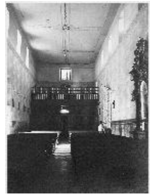
Interior mirando hacia el coro, antes de iniciarse los trabajos de restauración. En esta foto puede apreciarse el cielo raso plano que fue abolido posteriormente.
