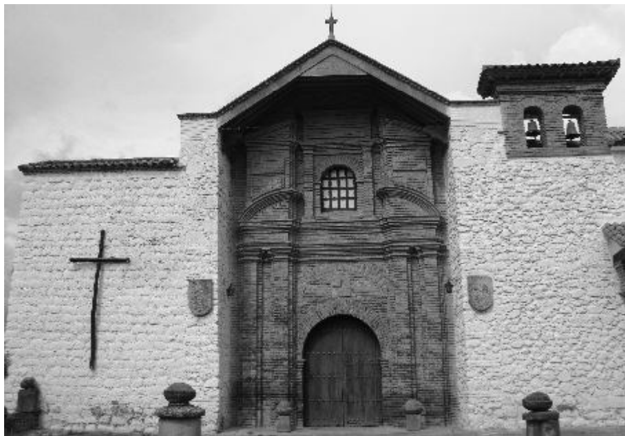
Ecce Homo. Fachada principal. (Foto: Olimpia Niglio, 2010)
