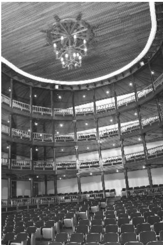
Sistema estructural en tapia y madera (Foto: Leonardo Castro)
