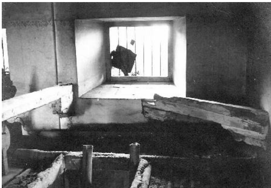
Tensor diagonal. Localizados detrás del altar y que ayudaron a determinar el nivel y sistema constructivo del antiguo techo.
