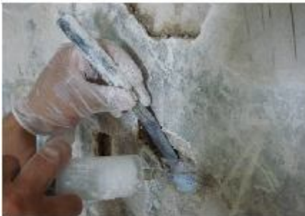
Proceso de consolidación de los estratos pictóricos
