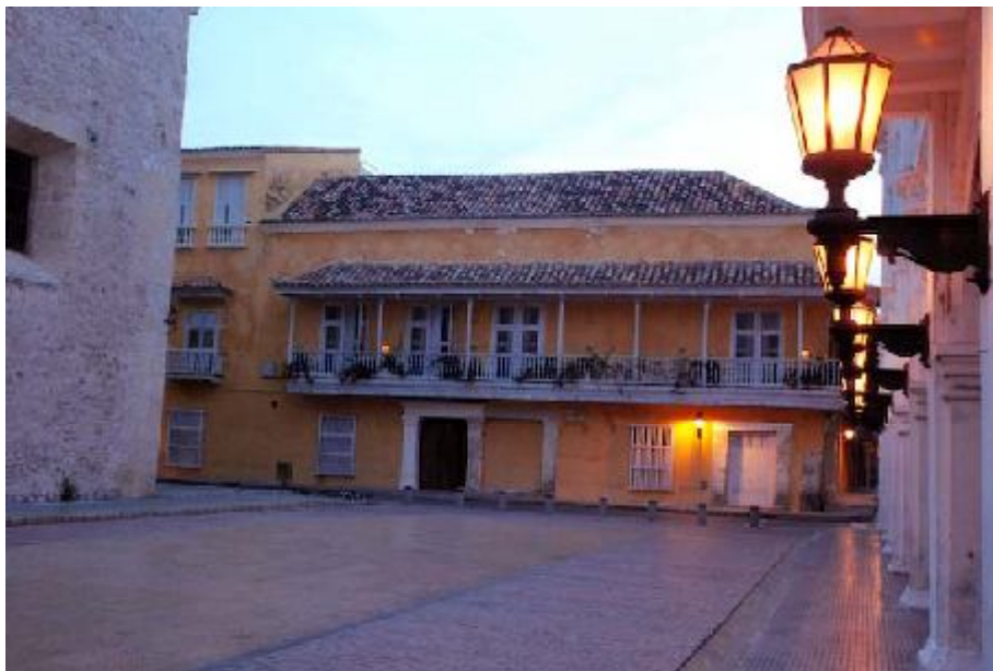
Fachada Casa Pombo
