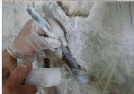
Proceso de consolidación de los estratos pictóricos
