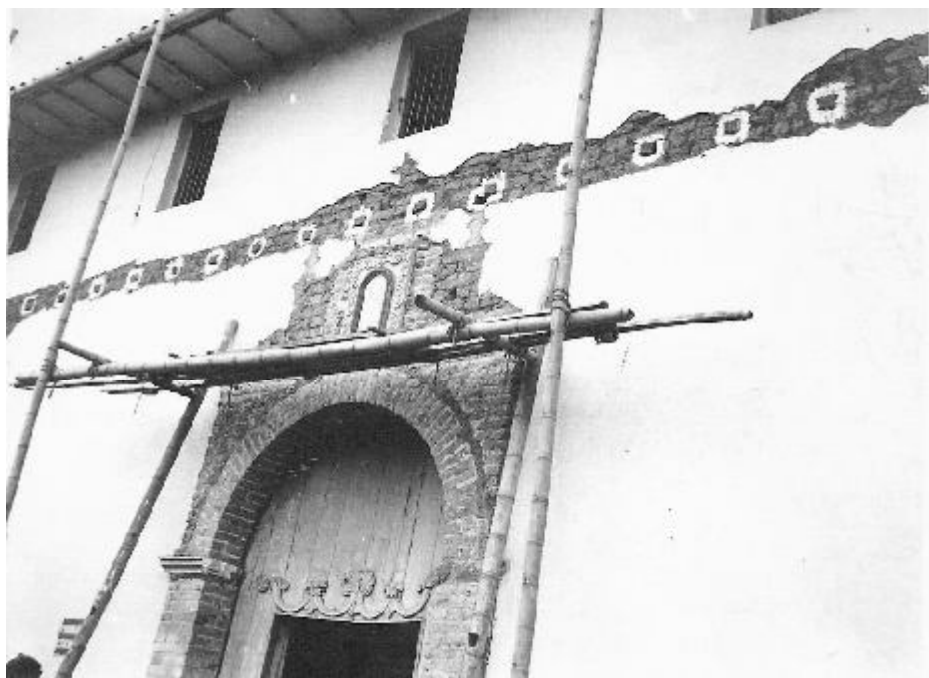
Localización de las “hojadas” que determinan on la altura del techo
