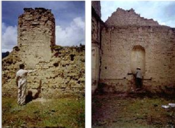
Figura 4. Capilla doctrinera de Tausa Vieja: Planta tipo y registros del estado actual
