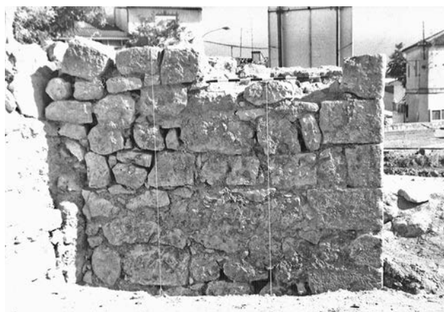
Figura 16. Muestra del aparejo de la muralla de la fase III de la fortaleza.
