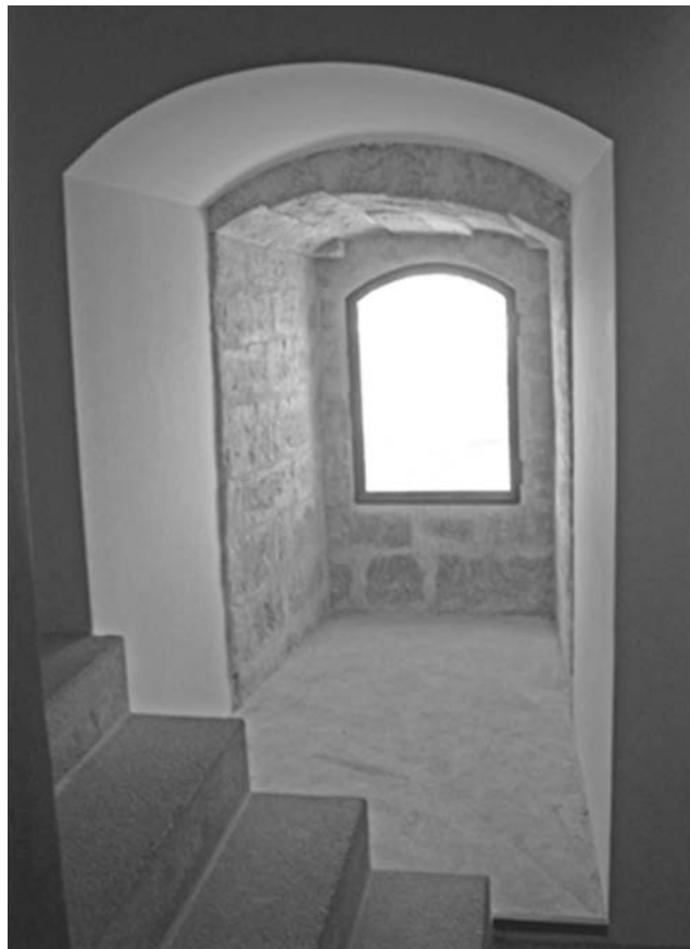
Figura 5. Vista de una de las ventanas de la segunda planta tras la rehabilitación.
