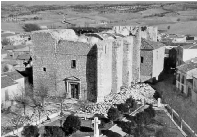
Figura 4. Vista aérea de la Iglesia Parroquial tras su derrumbe a principios de los años 70 del siglo XX.
