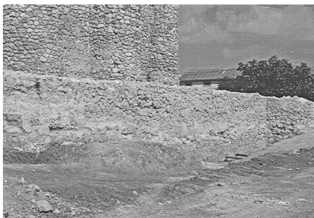
Figura 13. Vista desde el sureste del lienzo este de la barrera. Se trata del lienzo mejor conservado y con mayor altura.
