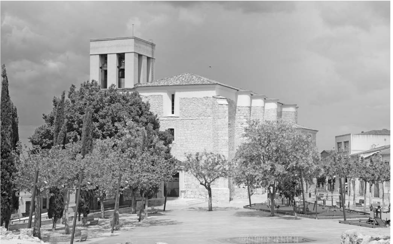
Figura 9. Vista general del estado previo de la Iglesia Parroquial de San Andrés Apóstol.
