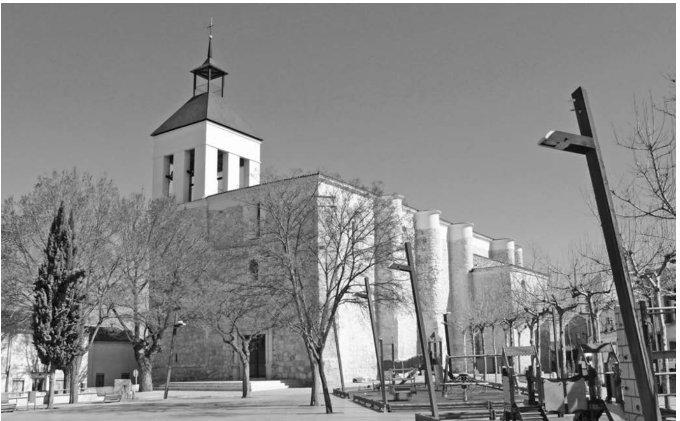
Figura 10. Vista general del estado posterior a la reposición del chapitel de la Iglesia Parroquial de San Andrés Apóstol.
