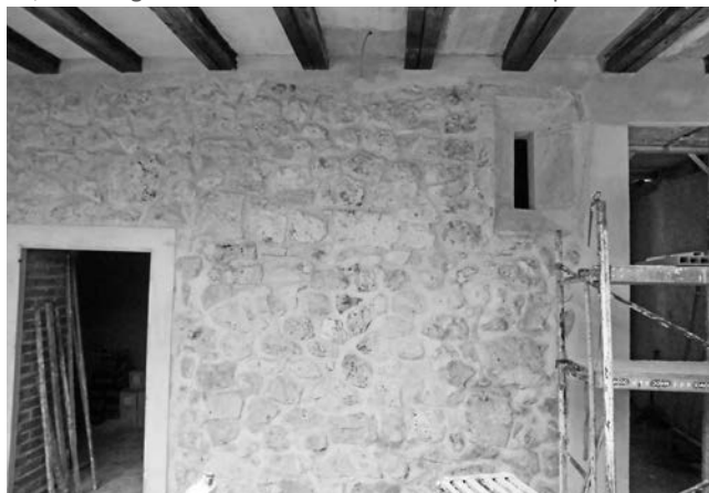
Figura 13. Fachada inferior del patio columnado con la ventana abocinada a la derecha y la puerta original a la izquierda. La puerta de la derecha es reciente.
