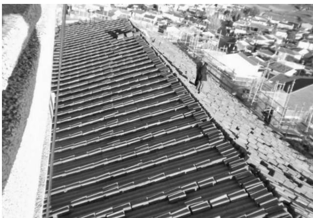
Figura 3. Trabajos de retejado de la cubierta. Vista desde la torre del campanario.
