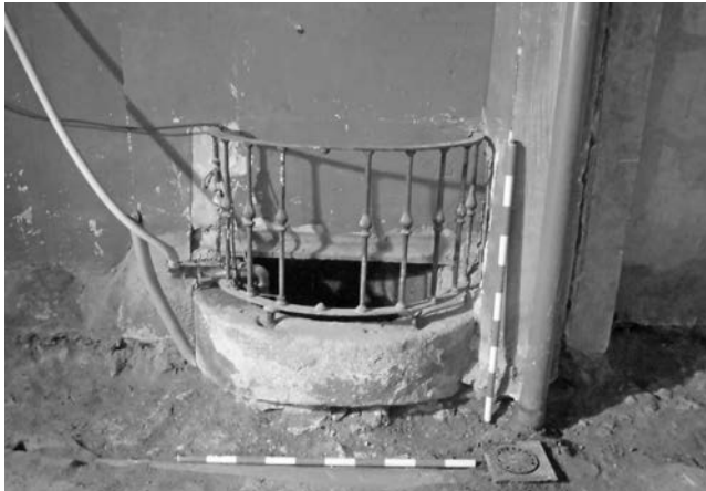
Figura 38. Vista del pozo situado en el segundo patio.
