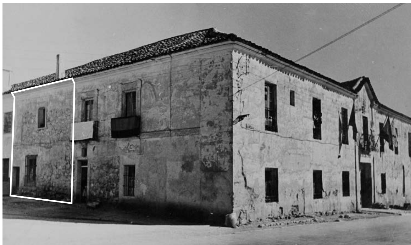
Figura 4. Fotografía de los años 40 con indicación de la parte de la fachada que nos ocupa. Obsérvese que, además de haber perdido buena parte del enlucido que deja ver el muro de piedra, aparece ahora una pequeña puerta que no existía anteriormente. La ventana con reja de la planta baja y la del piso superior (hoy balcón) siguen igual que en los años 20. En el tejado se ve asomar la chimenea.
