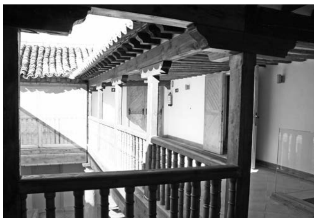
Figura 21. Vista de la galería superior del patio tras su rehabilitación (Fotografías: R. Muñoz y F. Jaro).
