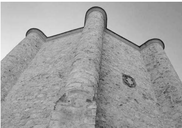
Figura 5. Vista de los imponentes contrafuertes que refuerzan la estructura del ábside.
