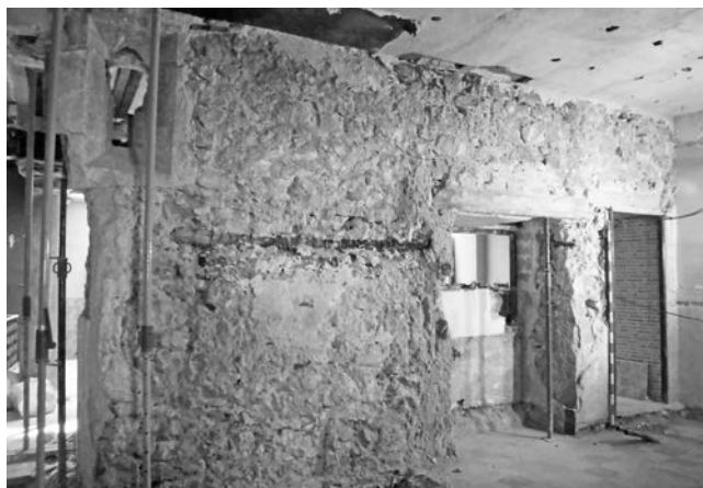
Figura 12. Superficie interior del muro de la fachada que delimita el patio columnado. La puerta del centro, aunque muy modificada, es la original. La ventana abocinada está a la izquierda.
