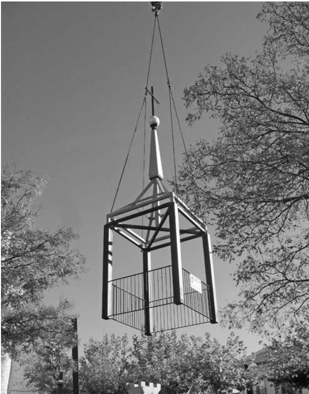
Figura 7. Elevación en una sola pieza de la estructura del cuerpo de campana superior.
