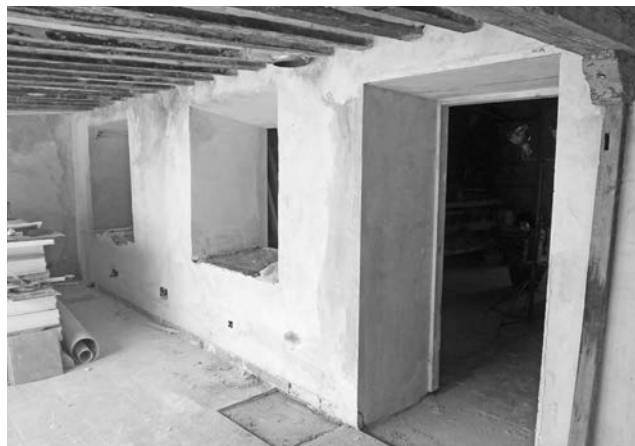
Figura 15. Vista de la fachada del corredor superior del patio columnado. Se encuentra muy alterada por la apertura de ventanas, aunque el hueco de la puerta es original.
