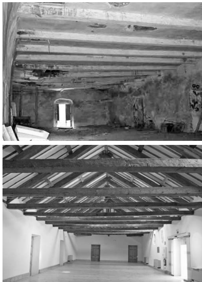
Figura 22. Vistas del estado inicial (Arriba) y final (Abajo) del granero de la Casa de la Tercia (Fotografías: R. Muñoz y F. Jaro).
