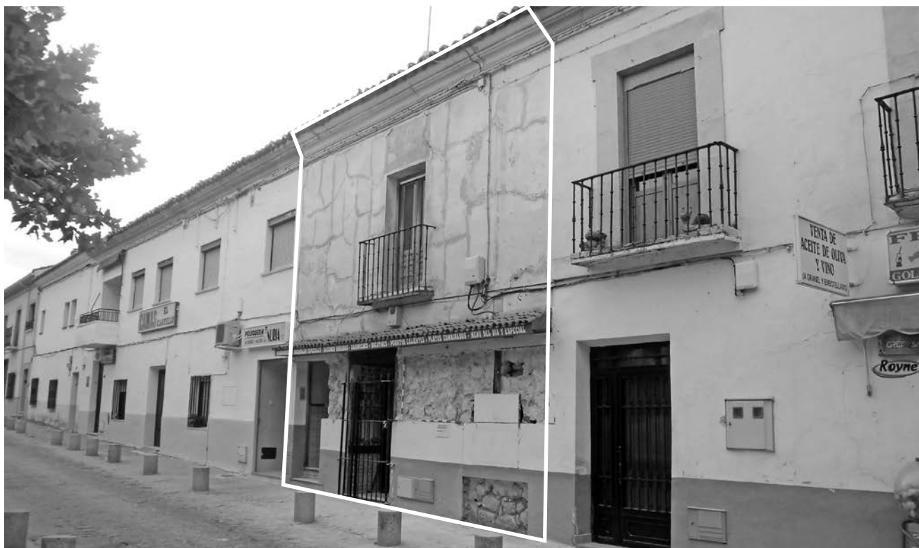
Figura 5. Vista de la fachada en la actualidad. La pequeña puerta de los años 40 del siglo XX se ha convertido en una puerta mayor para dar acceso a la escalera que conduce a la segunda planta. La ventana de la planta baja se ha convertido en una puerta de acceso. La ventana de la planta primera es ahora un balcón con puerta. La fotografía muestra la Cata Muraria 1 realizada en la fase de estudio previo.
