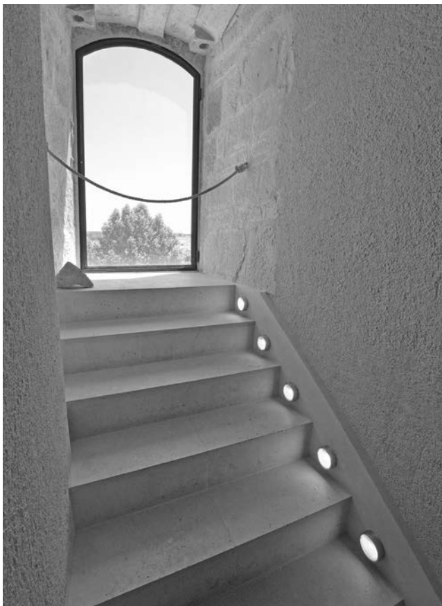
Figura 10. Escalera con ventana al fondo. Destaca la integración de materiales empleados e iluminación con los elementos originales.
