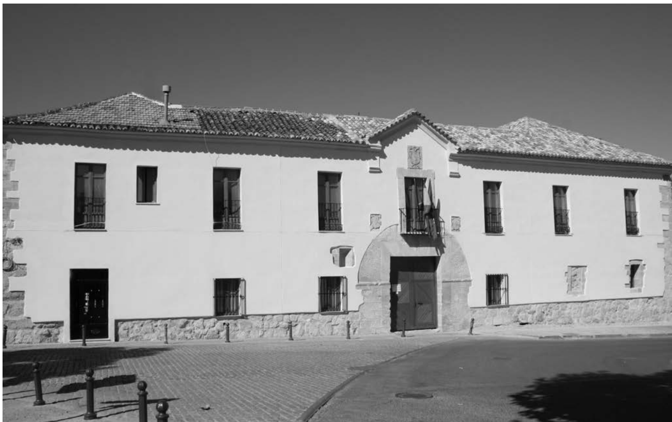
La Casa de la Tercia en la actualidad.
