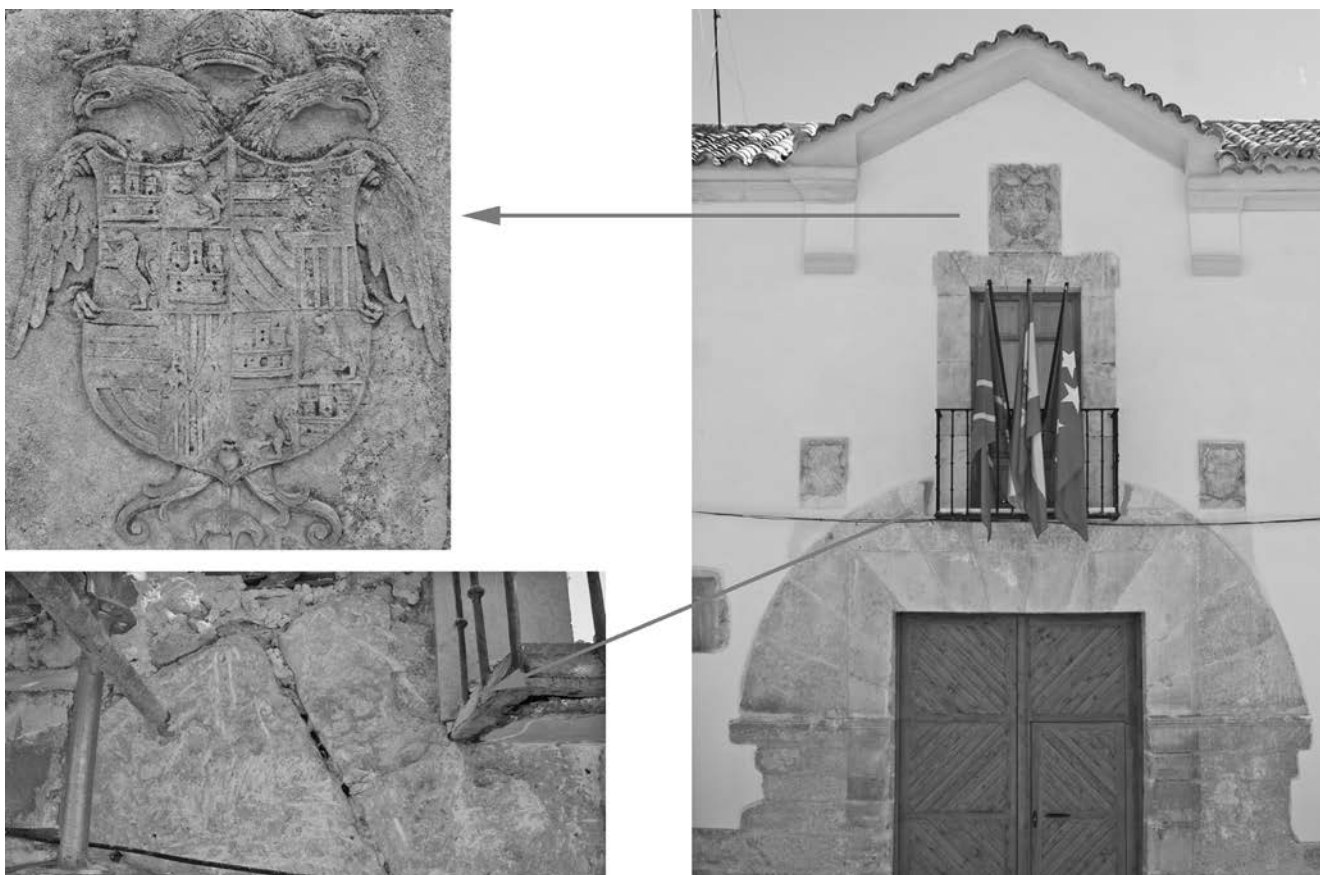
Figura 5. Escudos de armas de los Austrias y de los Zúñiga Avellaneda. Modificación de las dovelas del arco (Fotografías: A. Aldecoa).
