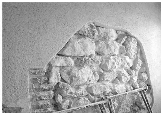
Figura 9. Detalle del tratamiento e integración de paramentos originales en la restauración.
