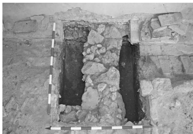
Figura 3. Cimentación de estancia bajo el actual empedrado del primer patio de la casa (Fotografía: A. Aldecoa).
