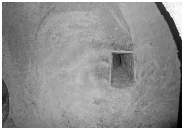
Figura 28. Vista del ventanuco abocinado que conecta el pozo con la cueva a modo de respiradero.
