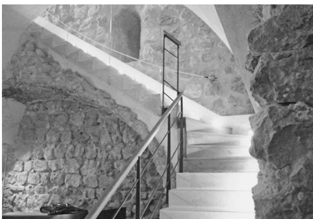
Figura 7. Vista de la escalera de acceso desde la planta baja a la planta primera y su integración con elementos originales.
