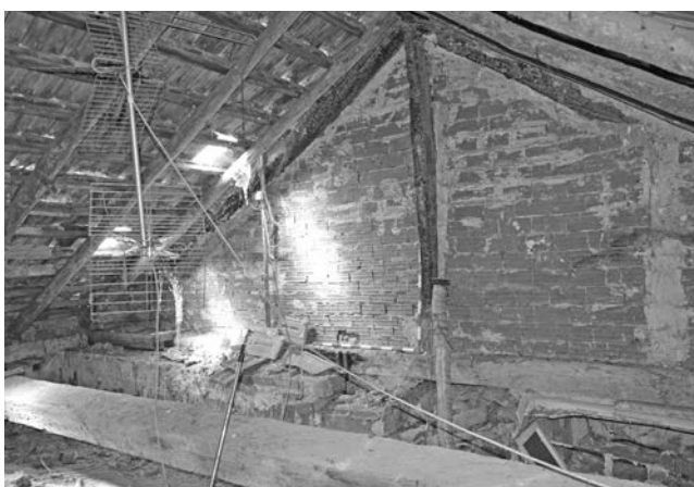
Figura 22. Vista de los restos de los pares y puntales originales quemados.
