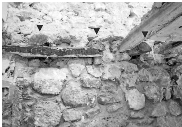
Figura 10. Detalle de los restos del durmiente y las vigas del forjado original de madera.
