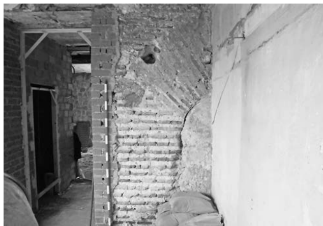
Figura 14. Vista del arco de ladrillo cegado aparecido en la fachada inferior del patio columnado.
