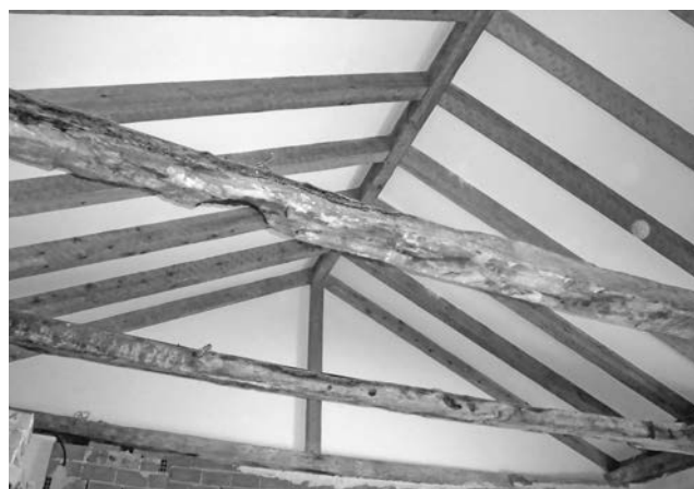
Figura 24. Vista de la estructura de madera reconstruida con los tirantes originales.
