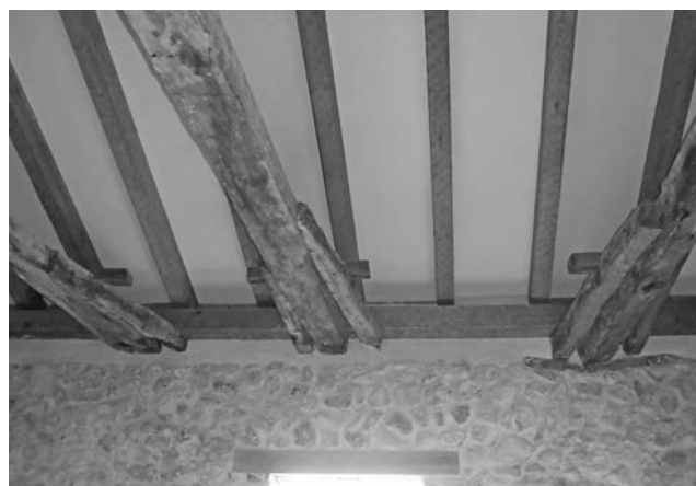
Figura 23. Vista de los tirantes y los refuerzos originales tras la reconstrucción de la cubierta y la eliminación del falso techo.
