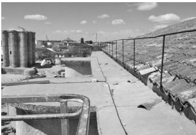
Figura 2. Intervención en los aleros de la cubierta. Desmontaje del remate existente (pasillo perimetral de mantenimiento).
