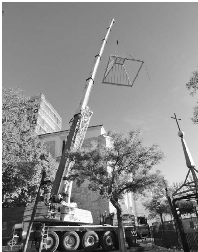
Figura 6. Montaje de la estructura del chapitel. Fotografía Archivo del Dpto. de Arquitectura del Obispado de Alcalá de Henares.
