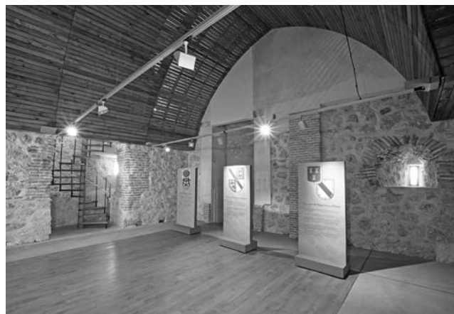
Figura 8. Vista de la planta tercera con la bóveda de madera y la escalera de caracol. Acabado final tras la restauración.
