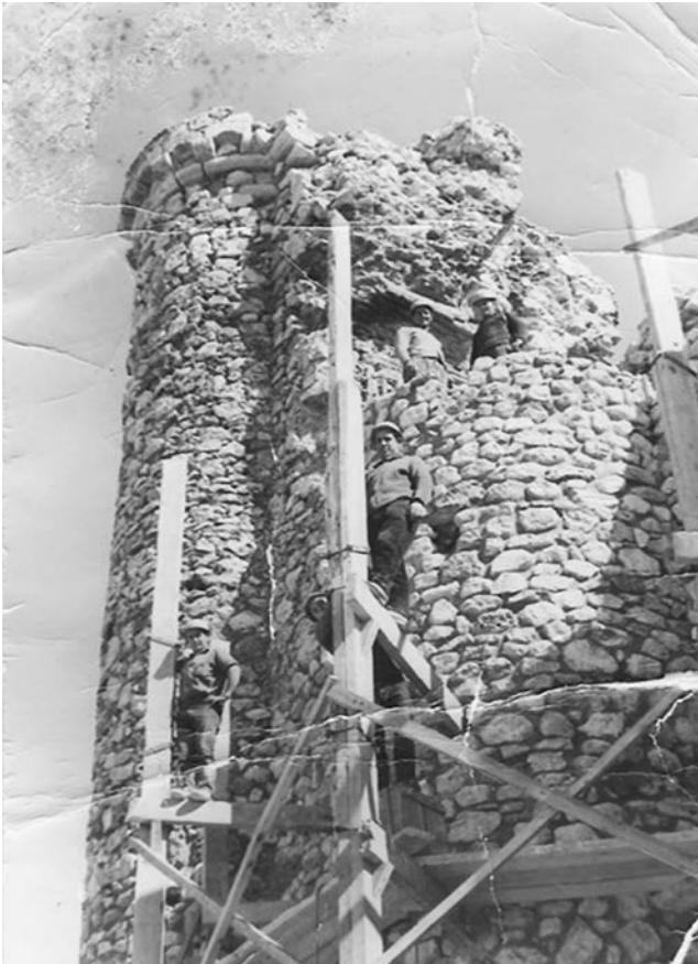
Figura 2. Trabajos de la restauración realizados tras el desplome de dos torreones en los años 60 del siglo XX.
