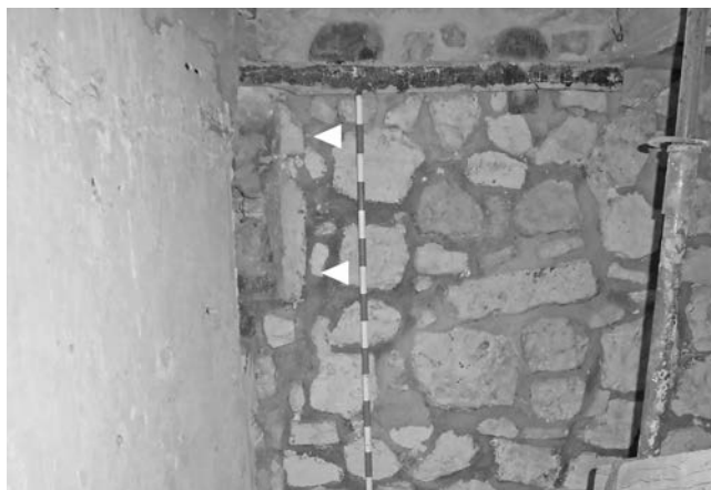
Figura 8. Ventana abocinada en la cara interior del muro de la fachada principal, en la medianería con la propiedad colindante.
