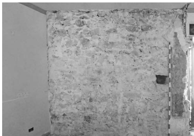
Figura 11. Interior del muro de la fachada en la primera planta a la izquierda de la puerta del balcón. Obsérvese, a la derecha, la huella del tiro de la chimenea y, justo al lado, el mechinal.
