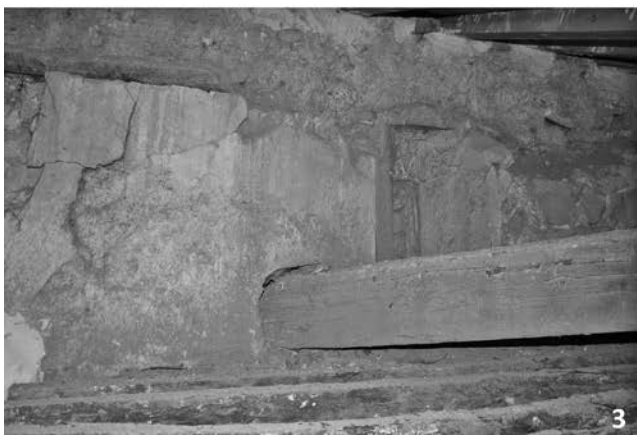
Figura 4. Ventanas abocinadas ocultas tras la construcción del corredor (Figura: A. Aldecoa).
