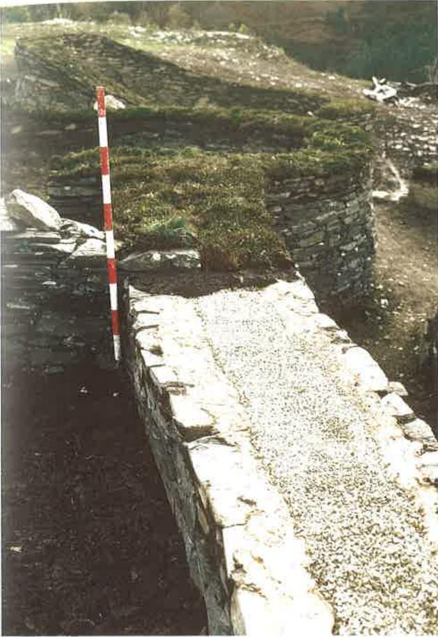
Una vez limpias las testas, se selló toda la superficie con una arcilla impermeabilizadora, una pequeña capa de guijo sirve como canal receptor para conducir las aguas hacia unos pequeños agujeros, practicados a modo de desagüe. Una capa de tierra vegetal con la siembra pertinente o de musgo completan el proceso.
