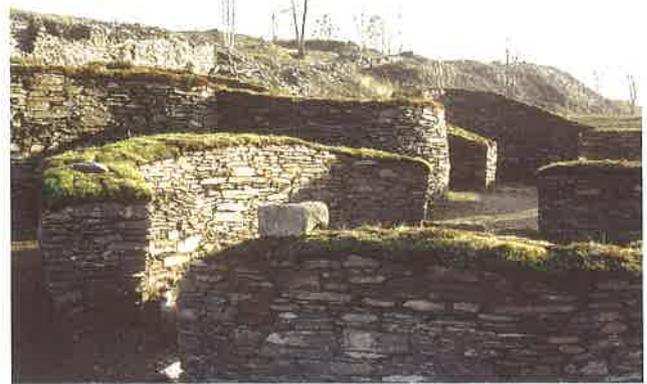
Resueltos los problemas del drenaje general, se procedió a realizar la misma operación en las testas de los muros. Estos micro-drenajes se realizaron para evitar el paso de agua hacia el interior de los muros y así garantizar su estabilidad.
