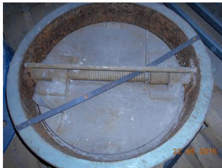
Figura 29. Válvula de retención de cámara partida. Fuente: elaboración propia, 2015
