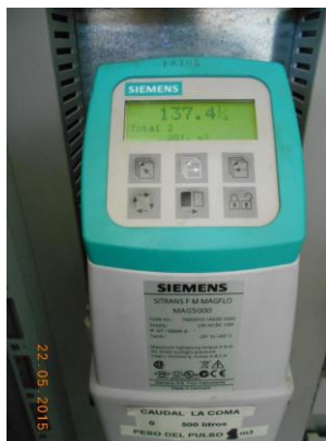
Figura 32. Electrónica de caudalímetro electromagnético. Fuente: elaboración propia, 2015
