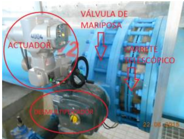
Figura 39. Partes de una válvula de mariposa automatizada. Fuente: elaboración propia, 2015
