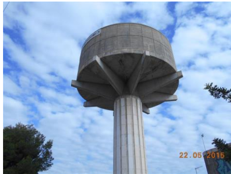
Figura 18. Depósito elevado. Fuente: elaboración propia, 2015
