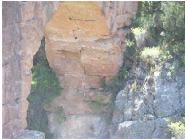
Figura 45. Vista del apoyo del arco sobre roca.
