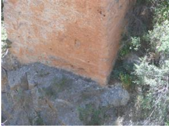
Figura 44. Vista de la cimentación de los pilares sobre roca. Fuente: elaboración propia, 2015
