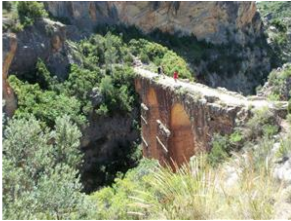
Figura 42. Vista del puente acueducto en la Cueva del Gato.
