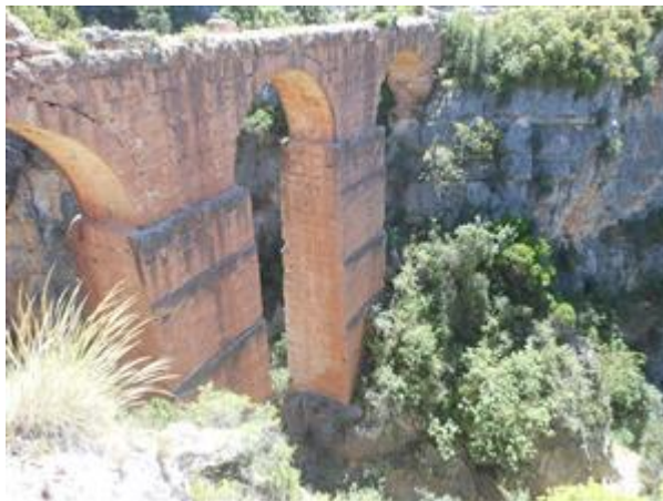
Figura 43. Vista de los dos pilares del puente acueducto.
