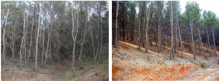
Figura 11.9: Tratamiento selvícola sobre masa de pino carrasco con densidad muy excesiva, sin actuación alguna previa. A la izquierda: estado anterior, con altísima competencia intraespecífica y con un modelo de combustible muy peligroso en caso de incendio. A la izquierda, la masa después del tratamiento (Fotos: I. Pérez-Soba).
