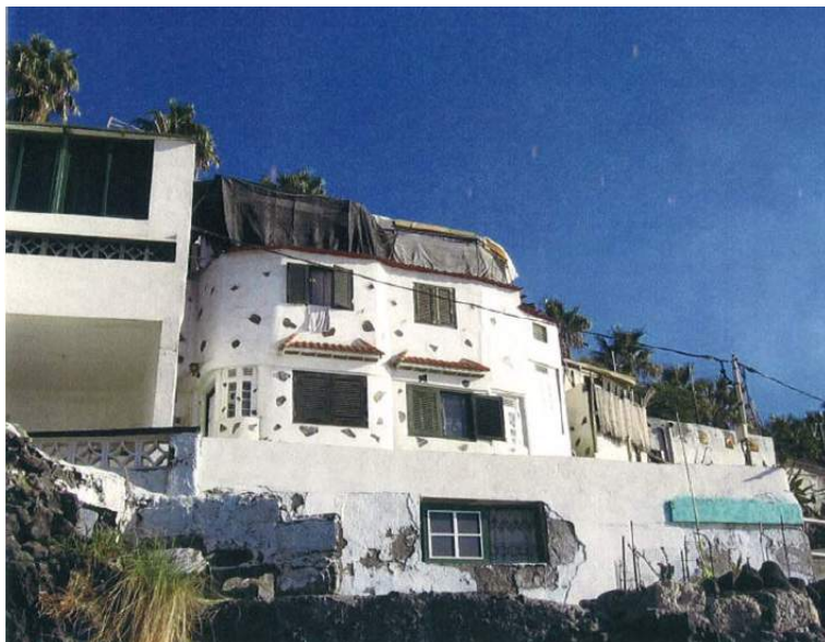
Figura 6.3: Fachadas de viviendas.
