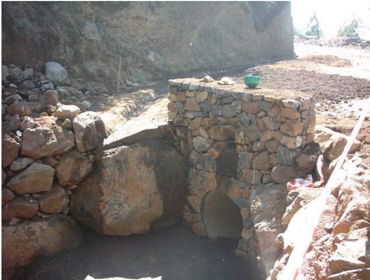
Figura 5.10:Paso de agua en el barranco.
