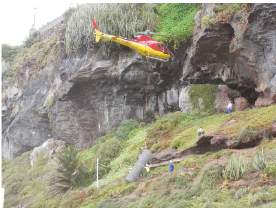
Figura 15.4: Colocación de la malla mediante helicóptero.
