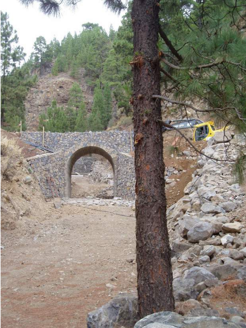
Figura 5.5: Vista parcial del pontón, tras actuación.
