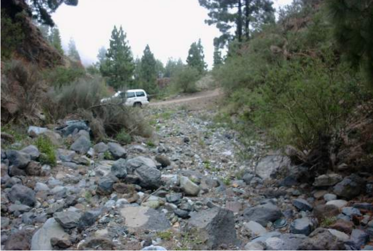
Figura 5.1: Cauce del barranco aguas arriba del pontón.
