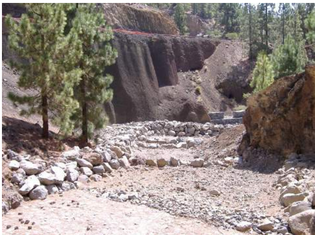
Figura 5.7: Protección de ladera mediante escollera y diques de gaviones
