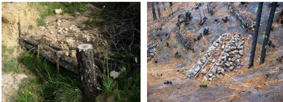
Figura 11.15: A la izquierda, albarrada convencional, hecha de troncos, y con la cuña de sedimentos ya formada (Foto: A. Hernández). A la derecha, "fajina armada" (albarrada de mampostería en seco con una matriz de restos vegetales) (Tardío y Caballero, 2008).
