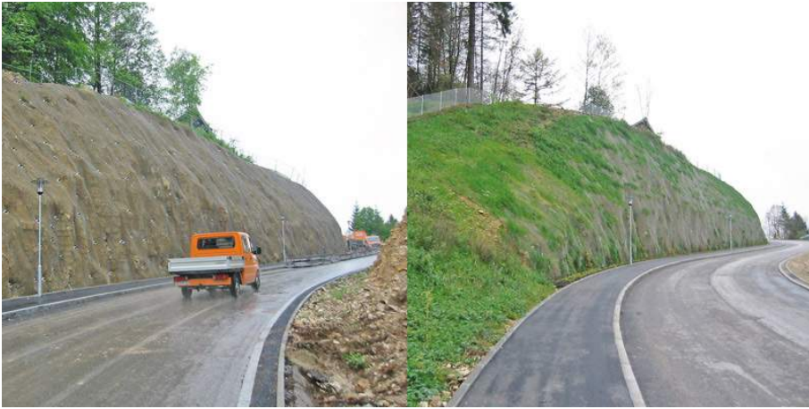
Figura 8.4: Estabilización de taludes mediante revegetación (Fuente: www.geobrugg.com ).
