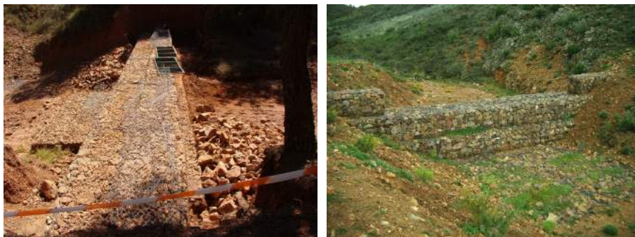
Figura 11.22: Diques de gaviones: a la izquierda, en construcción (se aprecian las jaulas vacías, y se ven los encofrados metálicos que servirán para su relleno); a la derecha, un dique concluido (Fotos: I. Pérez-Soba).
