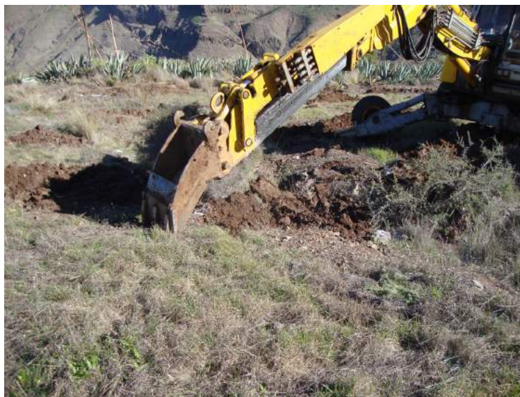
Imagen 3: Realización de banqueta con la retroaraña
