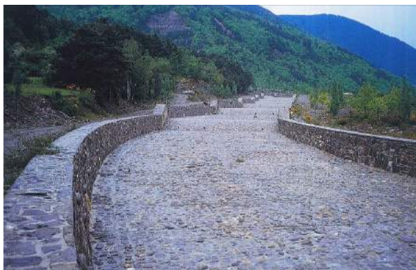
Figura 11.32: Torrente de Arás (Biescas, Huesca): encauzamiento con canal rápido y solera resistente (Nicolás, 2001: 184).
