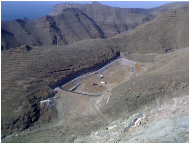
Figura 1.6: Ampliación del vertedero de La Gomera.
