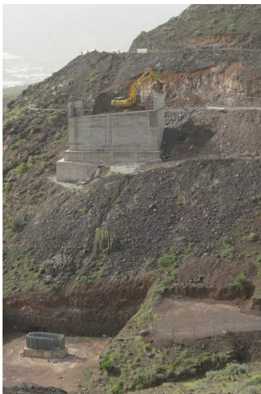
Figura 5.1: Construcción de un viaducto en nueva carretera.
