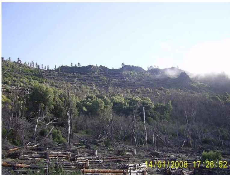
Figura 3.7: Disposición de las empalizadas 9 meses después de su construcción. Apréciase el cordón de monteverde central, con las líneas de empalizadas en la zona superior, y las dispuestas al tresbolillo en la inferior.
