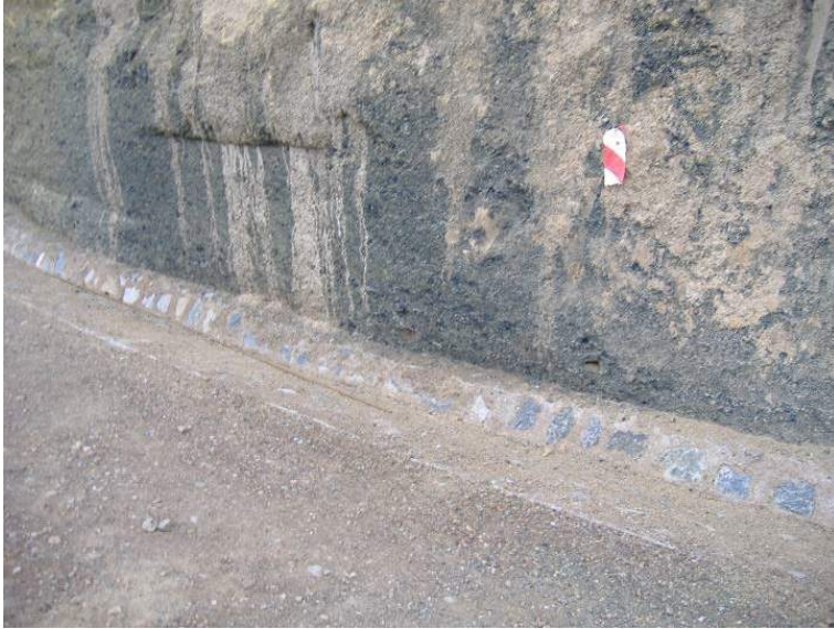
Figura 5.12: Detalle de cuneta acabada en piedra.
