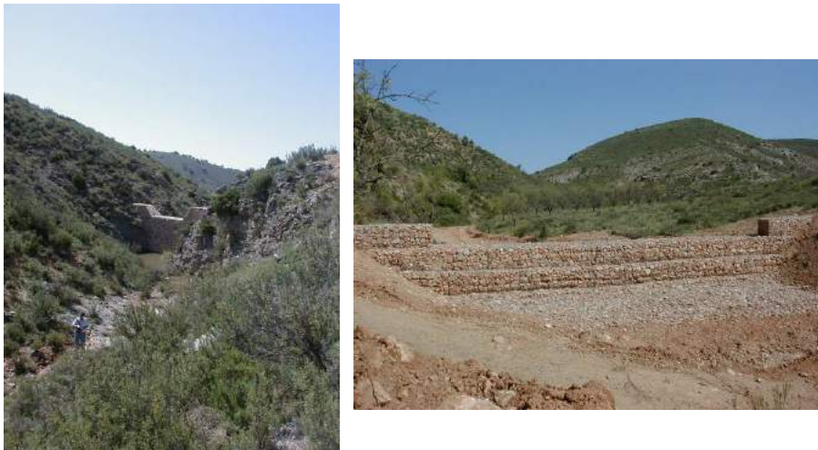
Figura 11.3: Zona alta (izquierda) y baja (derecha) de un típico torrente-rambla, el barranco de Bijuesca o de Carrabijuesca (Torrijo de la Cañada, Zaragoza). (Fotos: I. Pérez-Soba).
