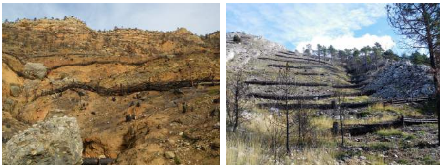
Figura 11.14: Obras de restauración de laderas afectadas por el incendio forestal de Aliaga y Ejulve (Teruel) . A la izquierda, fajinas. A la derecha, empalizadas. (Fotos: A. Hernández).
