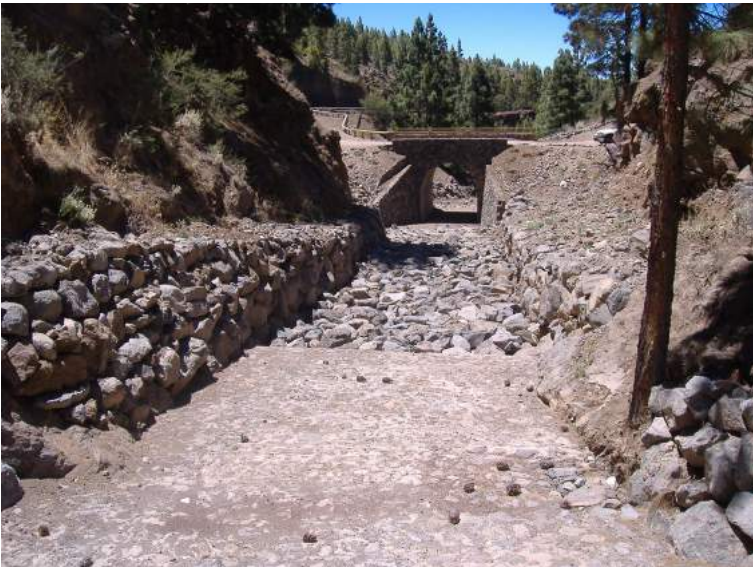
Figura 5.2: Cauce del barranco tras actuación, con pontón, muros cajeros en escollera y zampeados.
