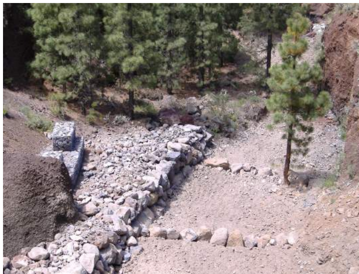
Figura 5.8:Detalle de escollera, umbrales de fondo y pequeño dique de gaviones
