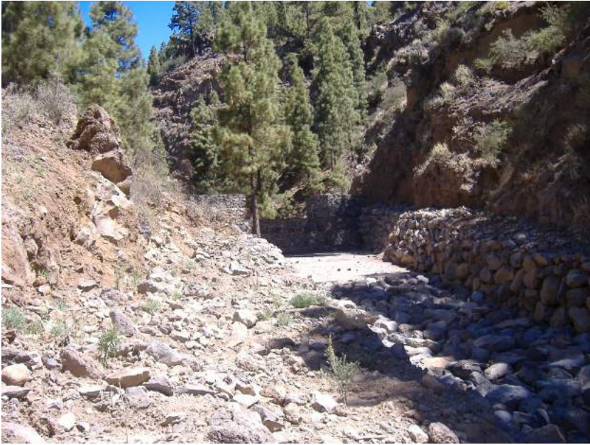
Figura 5.3: Vista parcial del cauce aguas arriba del pontón.
