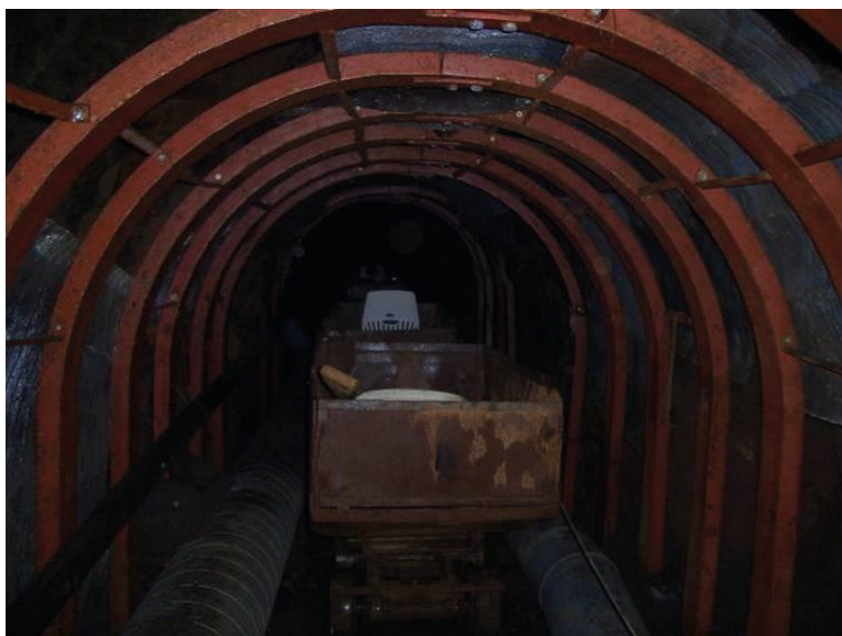
Figura 5. Fortificación mediante perfiles mecánicos arriostrados.
