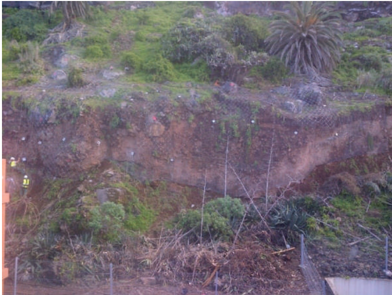
Figura 7. Aspecto general de la Zona A una vez finalizados los trabajos.
