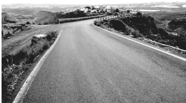
Figura 1. Tramo de la carretera GC-503 objeto de la actuación, sobre la coronación de la divisoria entre los Barrancos de Ayagaures y Lomo de La Data. (Isla de Gran Canaria).
