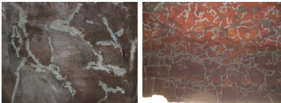
Figuras 26 y 27. Cordones de soldadura química una vez colocados.
