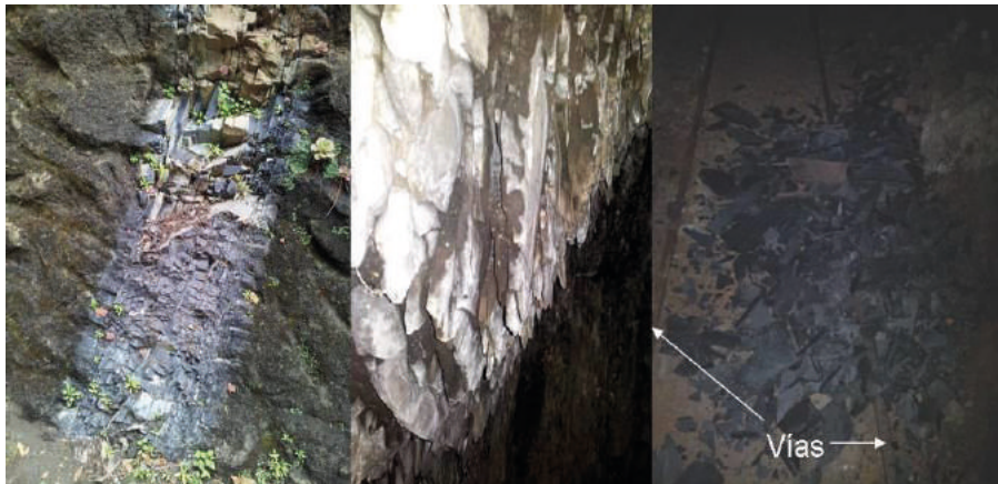
Figura 6. Microderrumbe de un dique basáltico – Galería Tenagua (La Palma)
