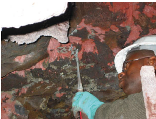
Figura 25. Instalación manual de la resina mediante cánula.
