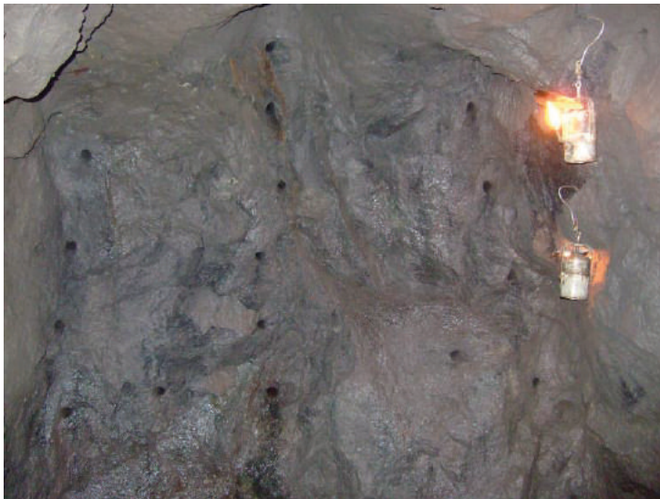
8. Perforación para voladura – Galería “Montaña Enmedio” (Tenerife)
