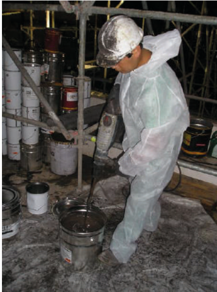
Figura 16. Fabricación de la resina epoxi de coloración predeterminada.
