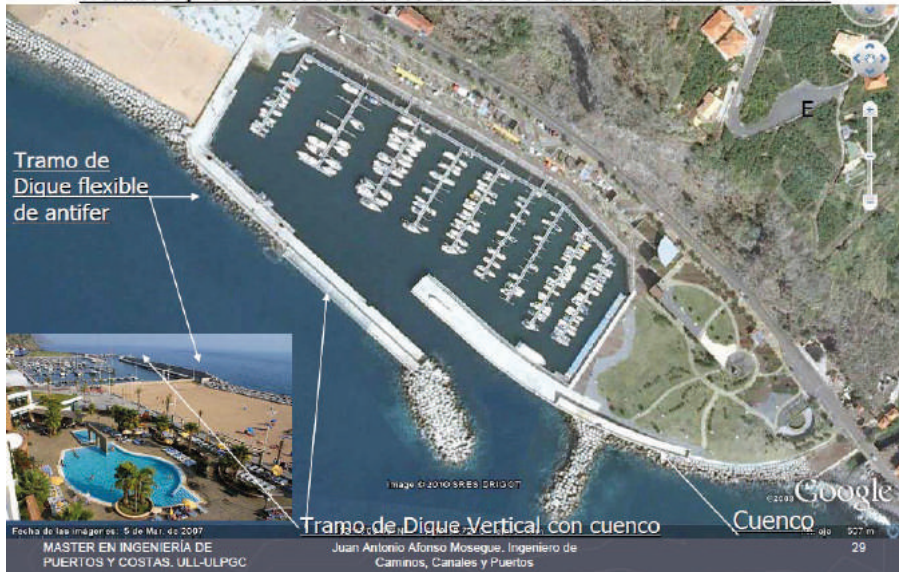
Figura 16. Dique de abrigo de un puerto deportivo en La Calheta (Madeira).
