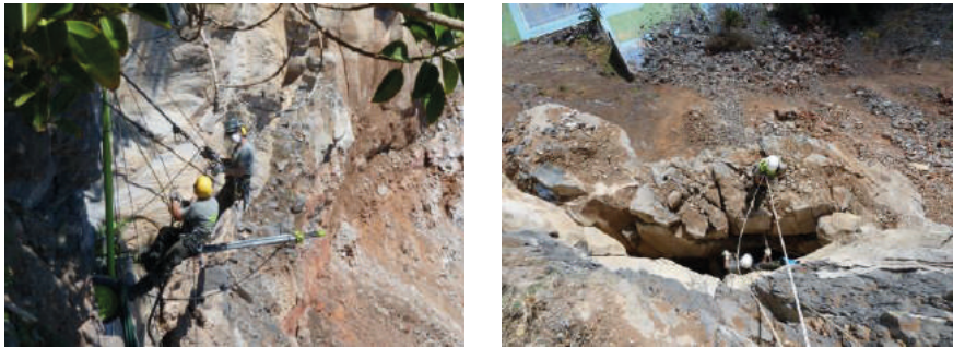
Figura 9. Perforaciones horizontales y demolición del macizo rocoso inestable.
