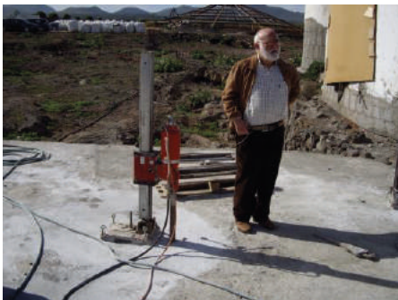
Figuras 22 y 23. Perforadora posicionada para la ejecución de taladros desde el exterior en el estrato mejorado. Vista panorámica del estrato mejorado una vez terminado.
