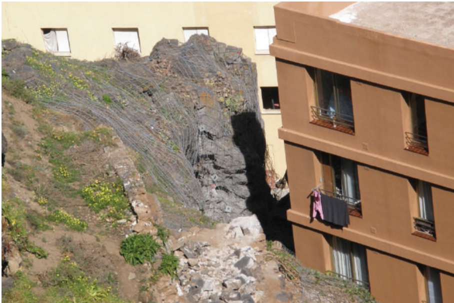
Figura 9. Bloques estabilizados con malla de triple torsión y red de cables.
