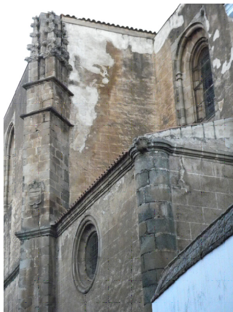
Fig. 11: imitación de cantería, Ntra. Sra. de la Candelaria de Zafra (Badajoz)
