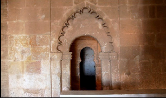
Fig.6: Entrada a la sala del machón central de la torre
