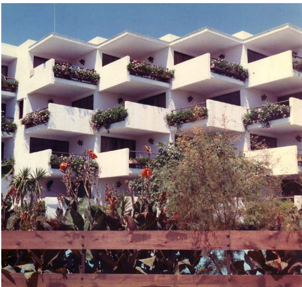
Fig. 1. Edificio Avenida, fachada Sur (cedida por D. Juan Pedro Capote).
