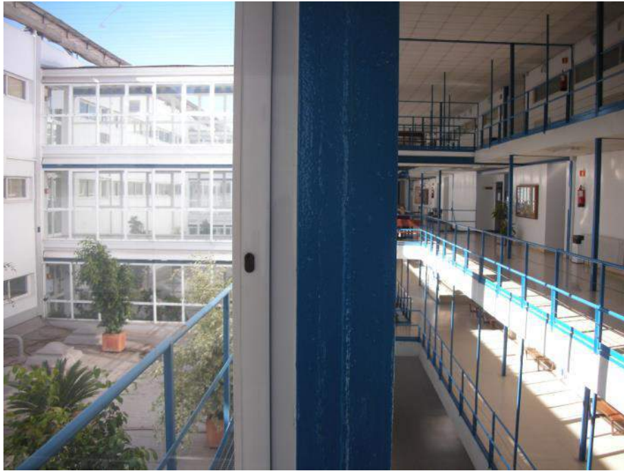
Fig. 9: Estado actual: Vista del patio y del espacio interior con las pasarelas colgadas.
