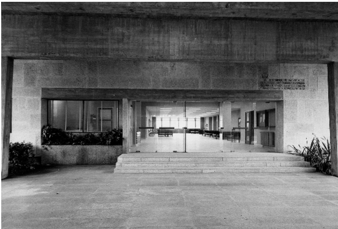
(Fig. 4). Escuela de Maestría Industrial, Santiago de Compostela: Atrio exterior y acceso al vestíbulo principal. © AP-CTAV
