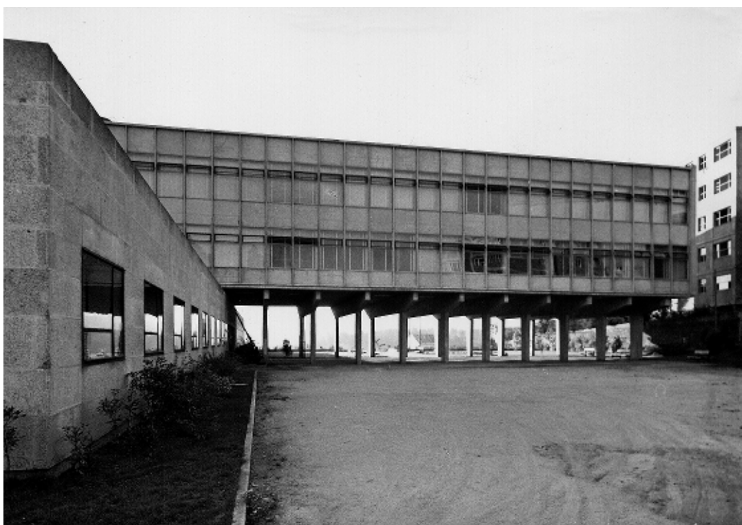
(Fig. 9). Escuela de Maestría Industrial , Santiago de Compostela: Espacio cubierto bajo el edificio docente. © AP-CTAV
