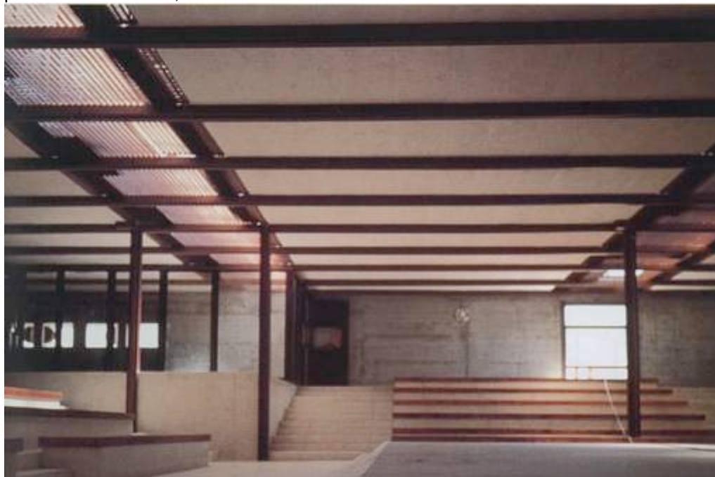
(Fig. 3) Interior del templo. Graderío desde el presbiterio. Fuente: Archivo Corrales. En: Construir arquitectura en España con Acero
