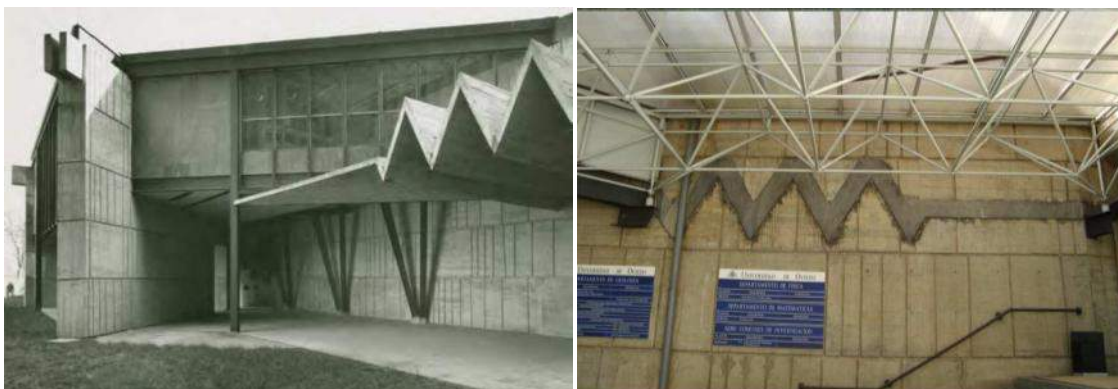
Fig.10. Marquesina de unión entre el aulario y el bloque de departamentos que ha sido sustituida por una estructura de acero. Estado original y fotografía actual. Fotografía del libro “50 años de Geología en la Universidad de Oviedo.”
