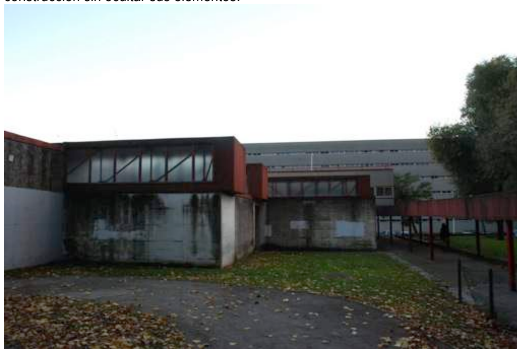
(Fig. 7) Secuencia de lucernarios sobre los muros de hormigón . Fuente: David García-Asenjo Llana. Fotografía del autor.
