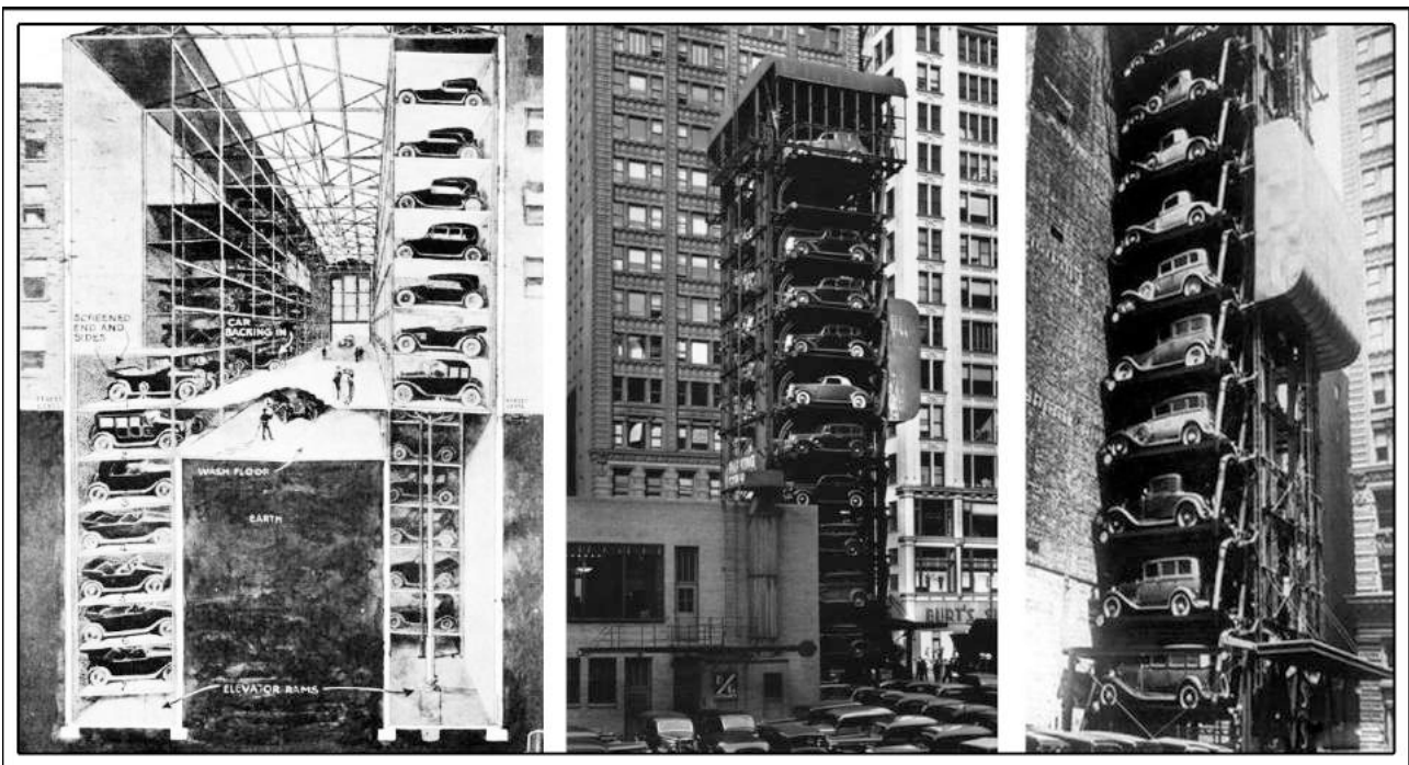
(Fig. 2). Un edificio de aparcamiento (Elevator-style car parks), 1920; una noria vertical (Paternoster), Chicago, 1925; un garaje elevado exento, Chicago, 1936, Fotografía John Gutmann. IPS Integral Park Systems. http://www.integralparksystems.com/aparcamientos_rob_1940.php
