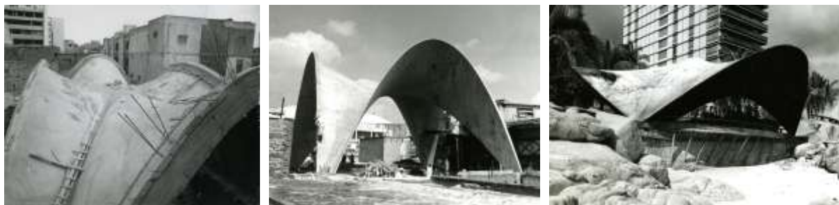
Fig. 3. Izq: Bóveda por arista con refuerzos de borde en la Bolsa Mexicana de Valores (DF, 1953). Centro: Bóveda por arista con borde libre en la iglesia de San Antonio de las Huertas (DF, 1956). Der: Bóveda por arista de tres gajos con borde libre en el Cabaret La Jacaranda (Hotel Presidente, Acapulco, 1957). Fotos: FDCA-PU
