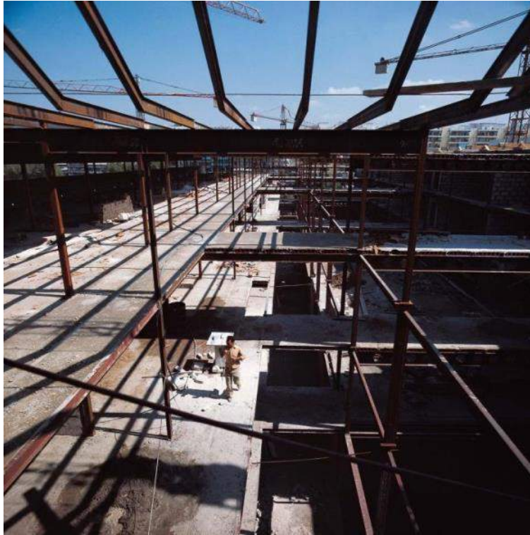
Fig. 5: Vista de la obra.
