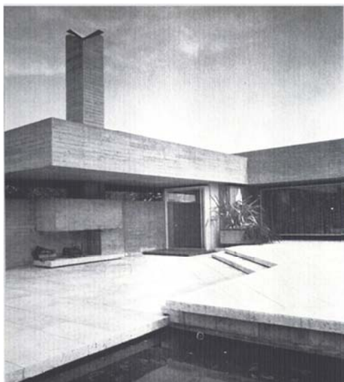
Fig3.: plataformas exteriores y estanque. (Arte y Hogar, 1972)
