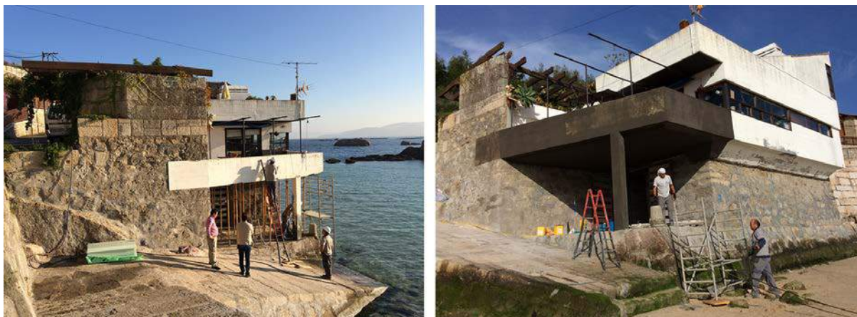
Figura 10. De izquierda a derecha: comienzo y final de la obra (antes de aplicar la capa de pintura)
