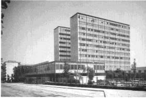
Vista desde la Avenida Diagonal de la Escuela de Ingenieros Industriales de Barcelona. (Archivo Terradas)
