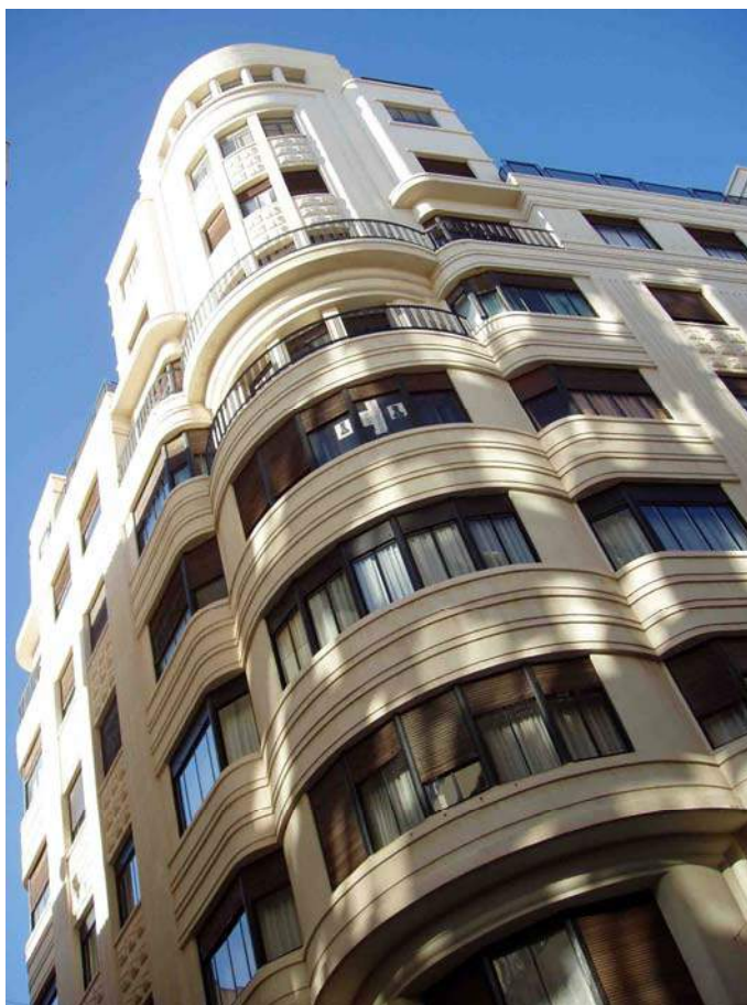
Figura 10: Edificio Legorburo. Torre de la esquina entre las calles Mayor y Marqués de Molíns. Foto de la autora.
