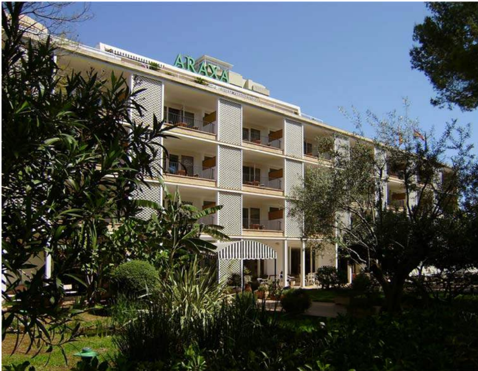
(Fig. I) Vista parcial de la fachada principal, María Sebastián, 2014.
