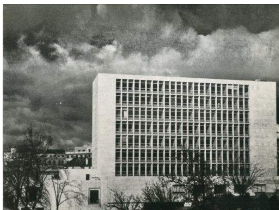
2. Embajada en construcción
