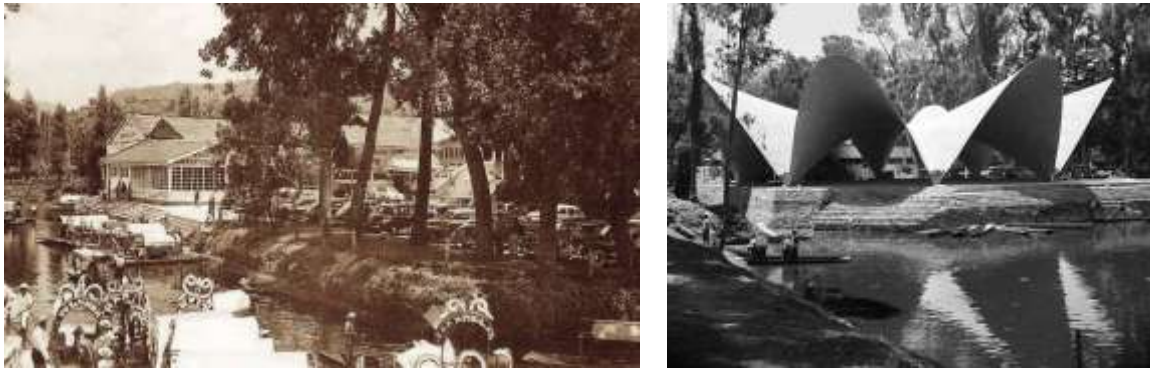
Fig. 1. Restaurante Los Manantiales, construido sobre una plataforma de tierra firme en la zona lacustre de Xochimilco, México. Izquierda: edificio original (1938), estructura de madera que fue devorada por las llamas en 1957 (foto: ARMX). Derecha: el nuevo restaurante, Joaquín Álvarez Ordóñez y Félix Candela, 1958 (foto: Juan Guzmán / ATM).
