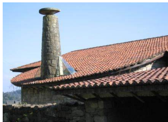
Detalle de la chimenea: encuentro con el faldón de cubierta
