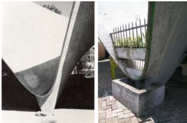
Fig. 10. Ayer y hoy del fino detalle del apoyo que se retranquea para dejar pasar libremente el borde sinuoso. Fotos: Faber, 1970, p. 219 y Juan Ignacio del Cieto
