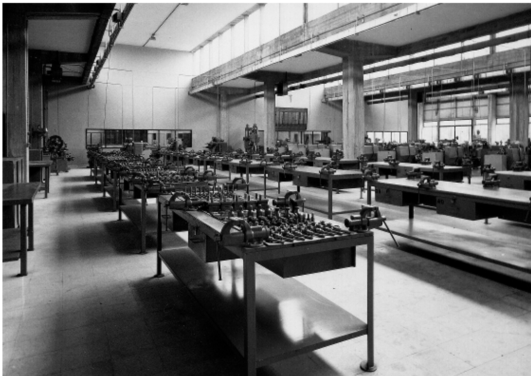
(Fig. 8). Escuela de Maestría Industrial , Santiago de Compostela: Nave de talleres industriales. © AP-CTAV
