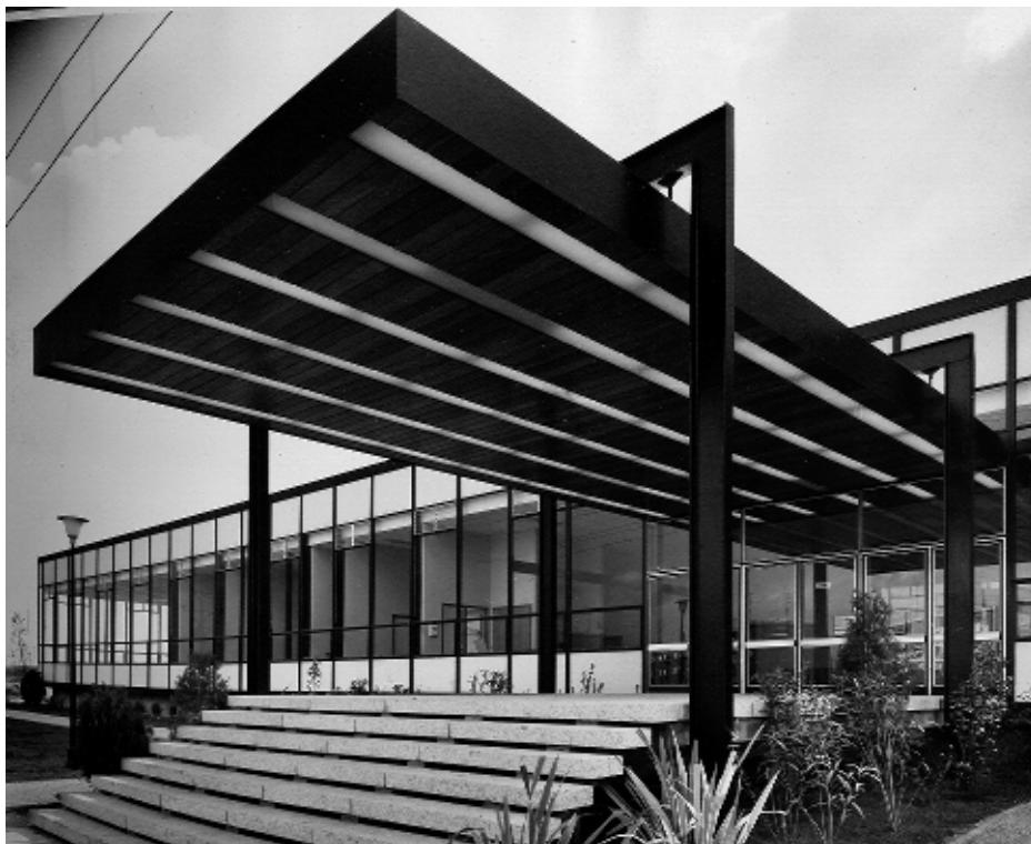
(Fig. 3) Escuela de Formación Profesional Industrial . Marquesina sobre el acceso principal. © AP-CTAV
