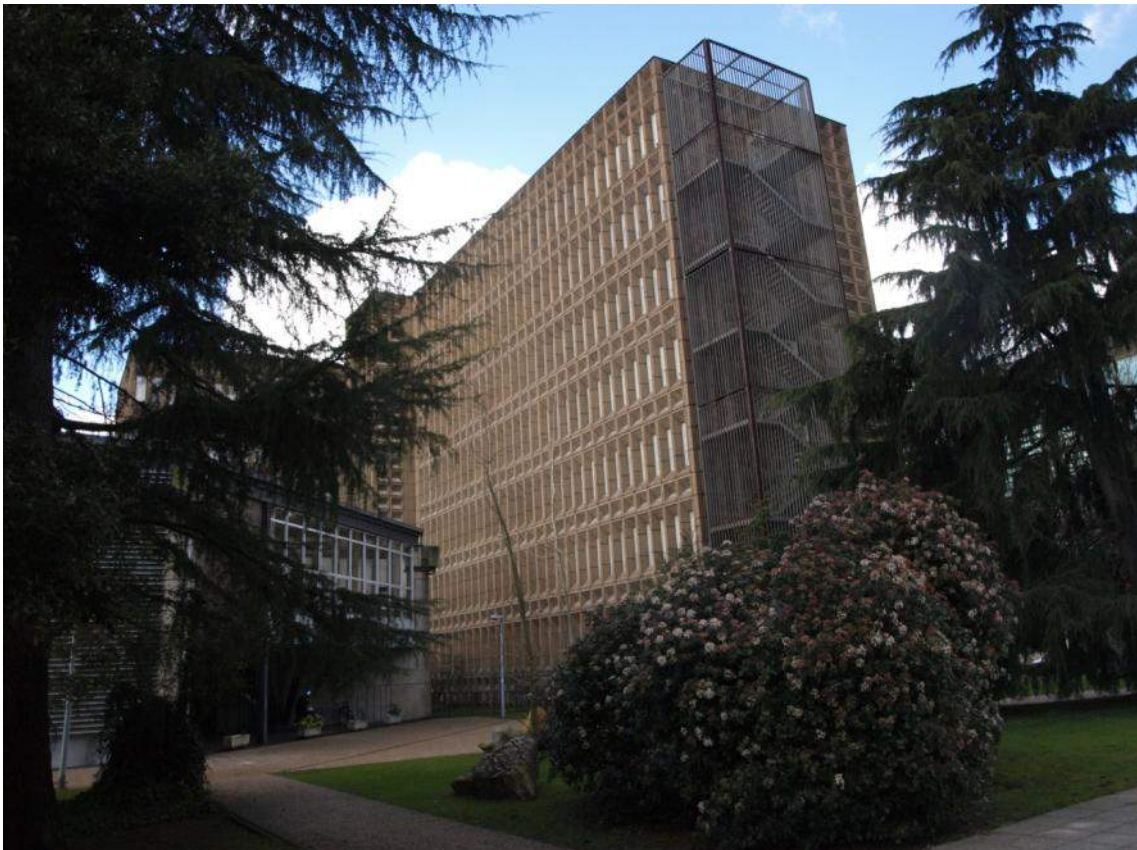
Fig.1. Exterior del Edificio de la facultad de Ciencias Geológicas y Biológicas de Oviedo. Fotografía de los autores.
