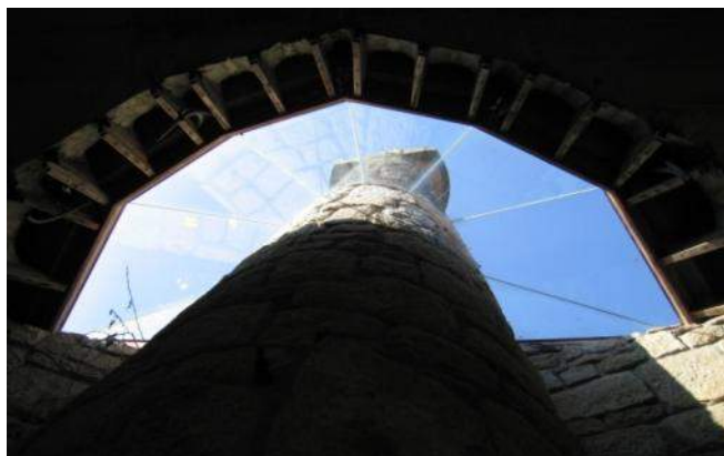
Detalle de la chimenea: encuentro con el faldón de cubierta
