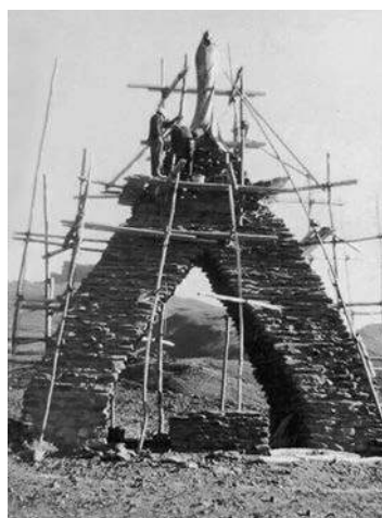
Obras en las cercanías de la Hoya de la Mora para realizar la base de la escultura de la Virgen de las Nieves.
