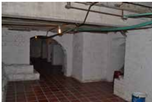
Fig. 13. Cimentación ciclópea en espacios aledaños a la cripta. Arq. Gonzalo Chocontá 2015.
