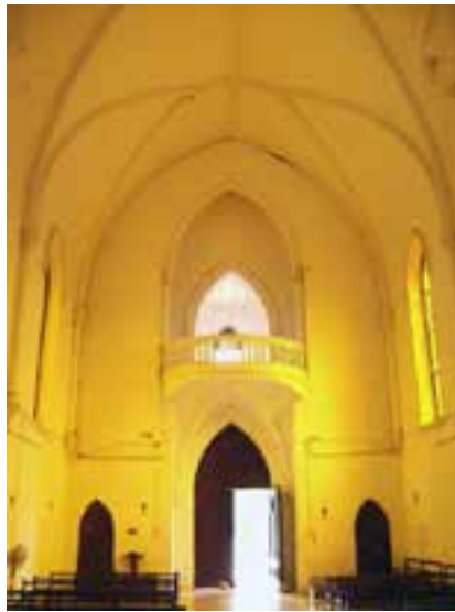
Fig. 17. Interior de la nave de la capilla de Eknakán. Autores.
