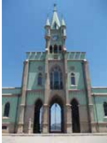
Fig.2. Repartição Fiscal da Alfândega, Ilha Fiscal, Rio de Janeiro (RJ), Brasil. Projeto de Antonio Del Vecchio. Foto de M. Rufinoni, 2015 [Acervo da autora]
