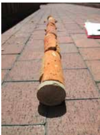
Fig. 20. Muestra de mampostería tomada en exploración. Muro longitudinal del costado sur. Arq. Gonzalo Chocontá 2015.
