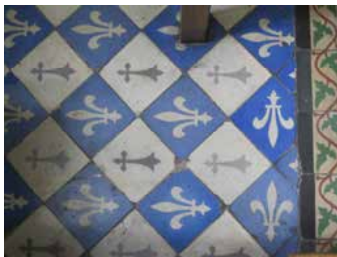
Fig. 17. Piso original en baldosín de cemento, primer nivel de la torre sur. Arq. Germán Téllez García 2014.
