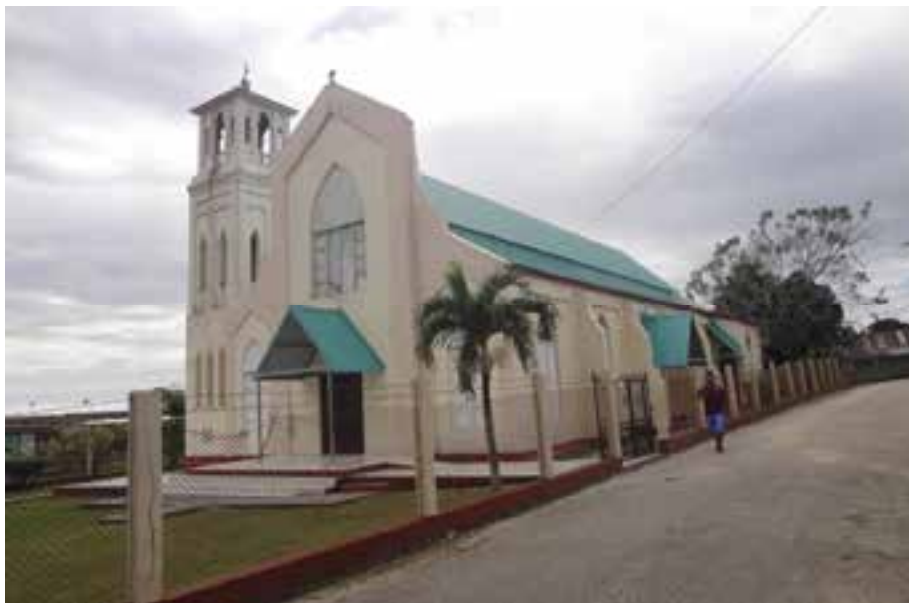
Fig. 2. Vista general desde la calle Muffles del templo parroquial de la Inmaculada Concepción, Orange Walk Town, Belice. Fotografía del autor, 2015.
