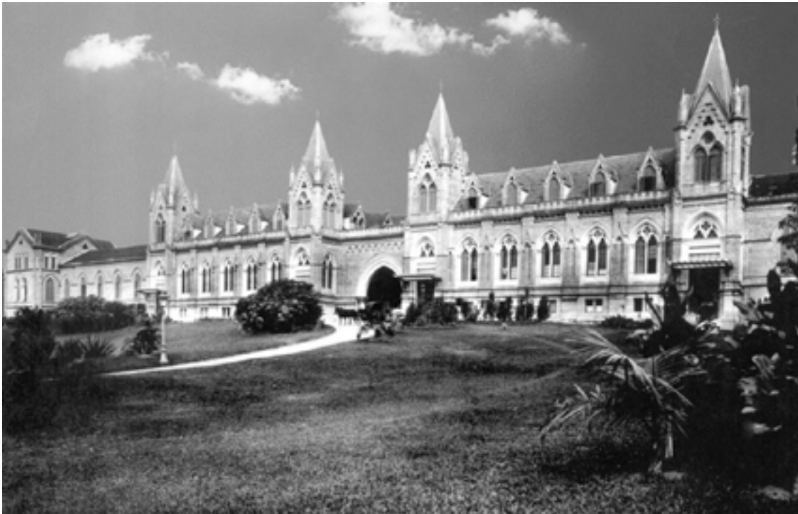
Fig. 7. Top: Entrance Pavilion of the Hospital of the Holy Mercy. In Toledo, M. T. 1984. A Santa Casa de Misericórdia de São Paulo . São Paulo: Banco Mercantil de São Paulo, p. 20.
