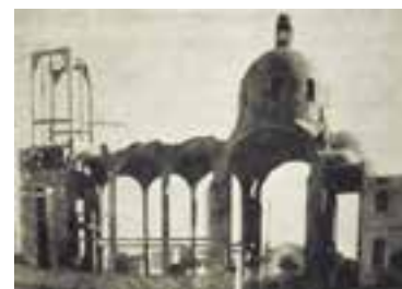
Fig. 3. Proceso de edificación del templo de la Sagrada Familia a base de concreto armado. (Celis, 2010, pág. 52)
