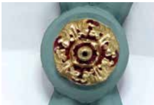
Fig. 19. Pinjante en yeso ubicado en el punto de cruce de las nervaduras de las bóvedas de crucería. Arq. Carlos Niño Murcia 2015.
