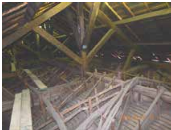
Fig. 14. Cercha rey en madera. Arq. Angela Cely 2015.
