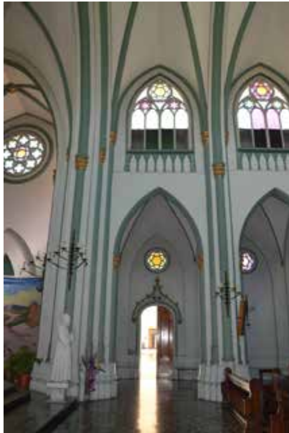
Fig. 12. Pilares compuestos y arcos apuntados construidos empleando mampostería cerámica. Arq. Jaumer Blanco -2014.
