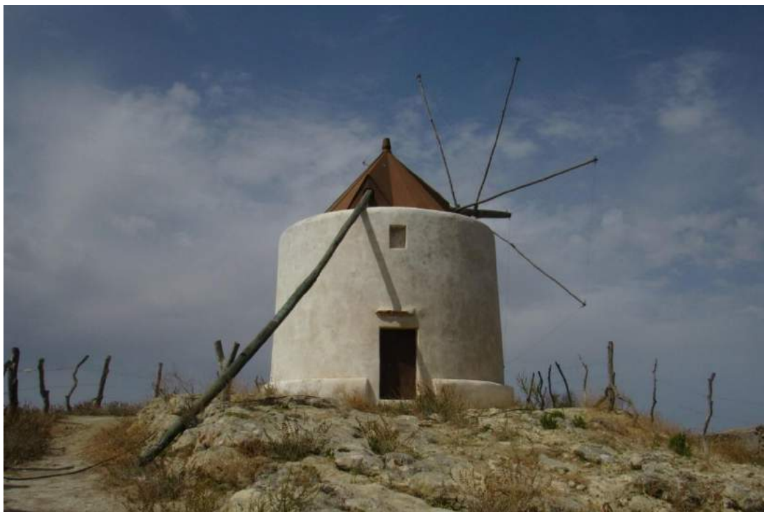
Figura 2. Molino Cruz de Conil de Vejer de la Frontera (Cádiz) de tipología mediterránea-atlántica. Se trata de un molino de mástiles y velas triangulares de una sola planta superior y con el cuerpo del molino mucho menos esbelto que el de los molinos manchegos. [Fotografía del autor]
