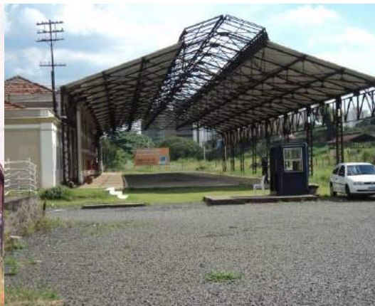
Figura 3: Estação Guanabara após o processo de restauro. Campinas – SP 2014. Fonte: acervo fotográfico da autores.
