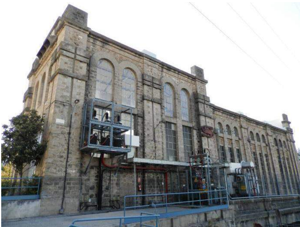
Figura 1. Central Hidroeléctrica de Mengibar, Jaén. Vista aguas abajo sobre el Guadalquivir.
