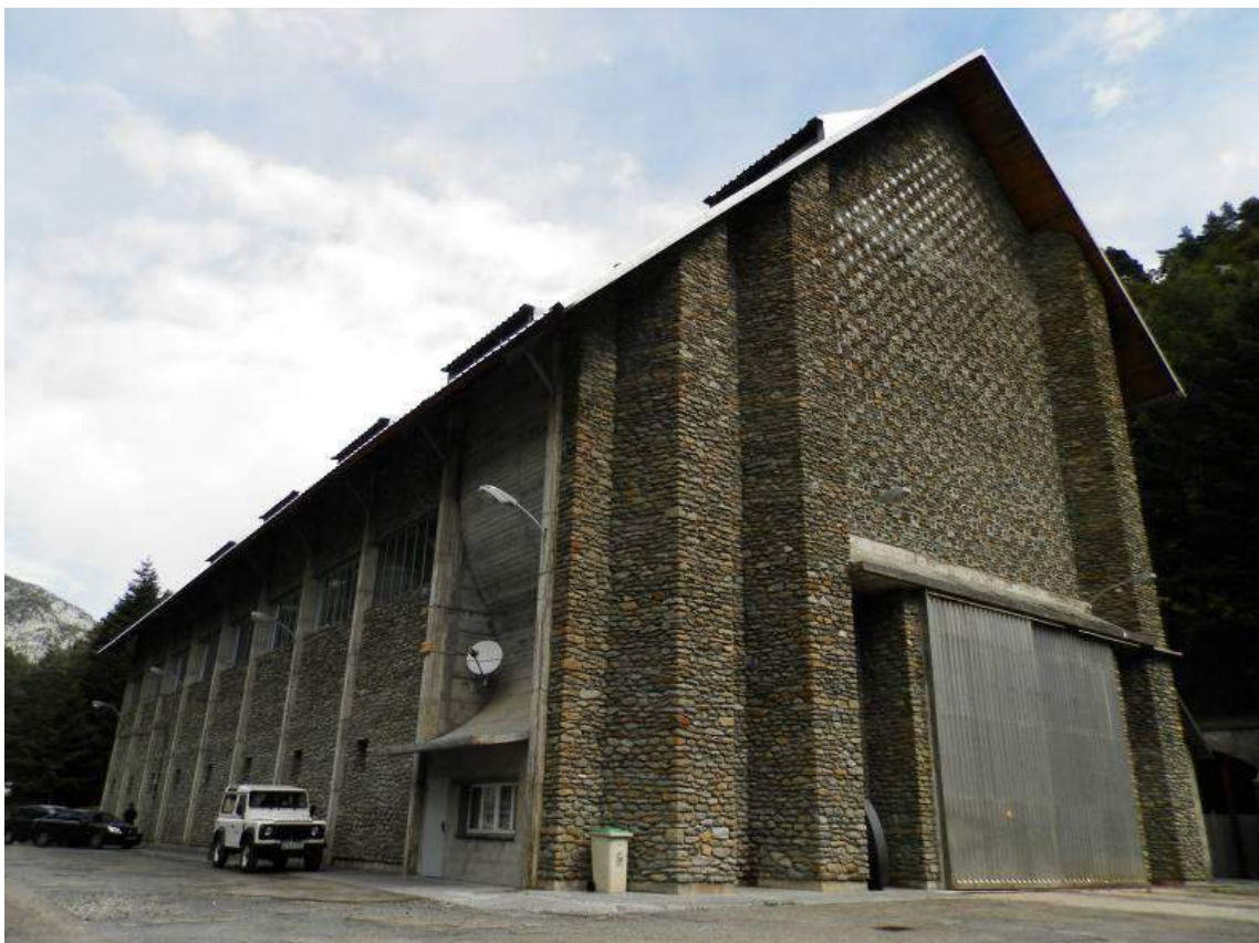
Figura 2: Central hidroeléctrica de Ip, vista alzado sur.
