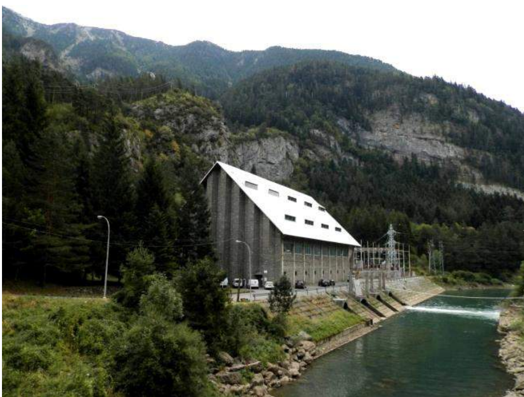
Figura 6: Central de Ip, vista general desde la carretera al otro lado del río.
