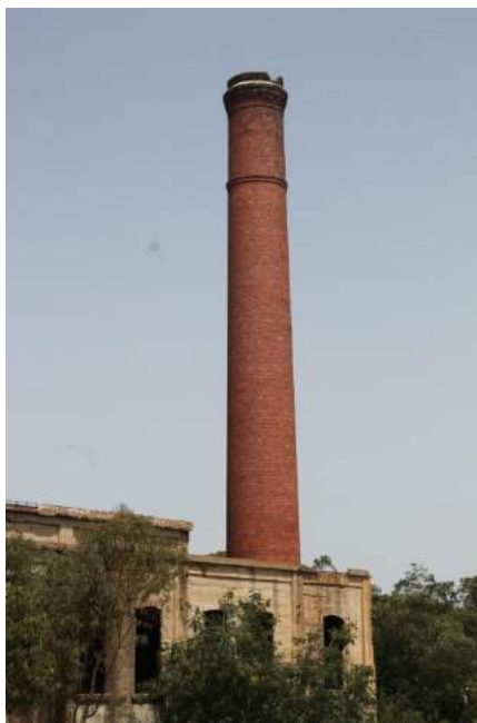
Figura 3. Chimenea de fábrica de ladrillo
