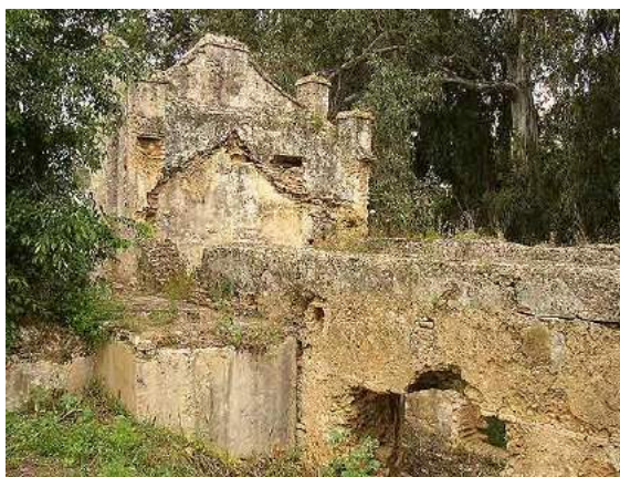
Figura 1. Molino de La Tapada antes de su intervención.
