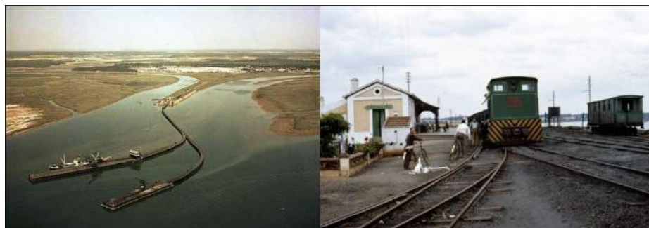
Figura 1. A) Muelle de Tharsis antes de la demolición del primer ramal en 1980. F.O.A.T. Fotografía Aérea y Terrestre S.L.; B) Estación del Puntal de la Cruz. Colección particular.
