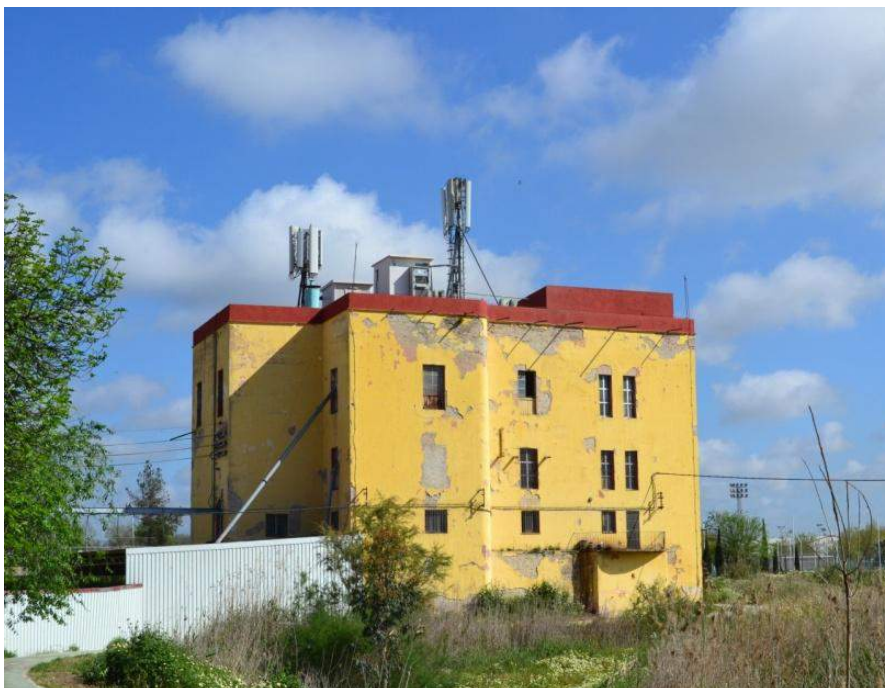
Figura 6: Vista de la fábrica “La Giralda” en la actualidad (fachada sur). Fotografía de los autores.
