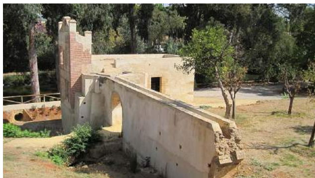
Figura 2. Molino de La Tapada tras la intervención.
