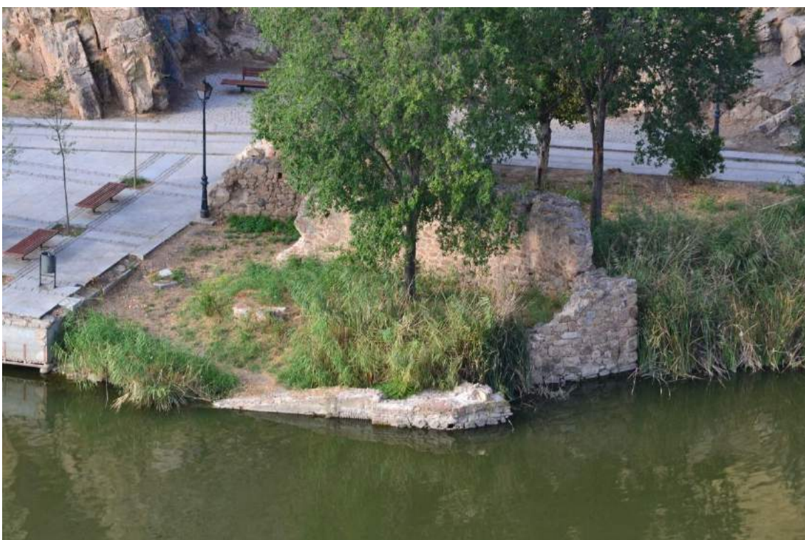
Figura 4. Restos del Batán de los herederos de Eugenio Alada en la ribera derecha del río Tajo a su paso por Toledo. Se encuentra situado en una de las partes de esa ribera más alejada de las zonas habitadas. [Fotografía del autor]
