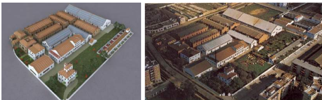
Figura 22. Vista aérea. Comparación modelado 3D y foto previa a la demolición de los edificios.
