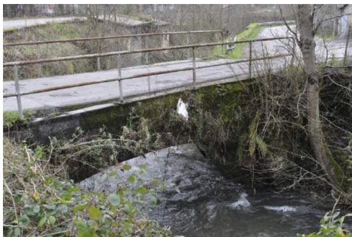
Fig. 3. Puente sobre el Candín. Bóveda de hormigón en masa construida por Ribera bajo el tablero añadido posteriormente. Fotografía de la autora
