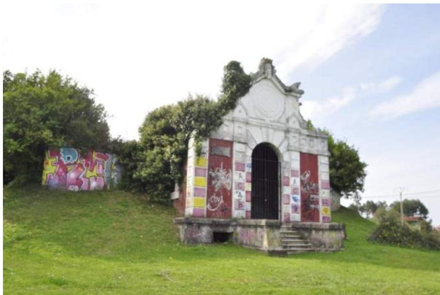
Fig.6. Fachada de la cámara de llaves del depósito de aguas de Llanes. Fotografía de la autora
