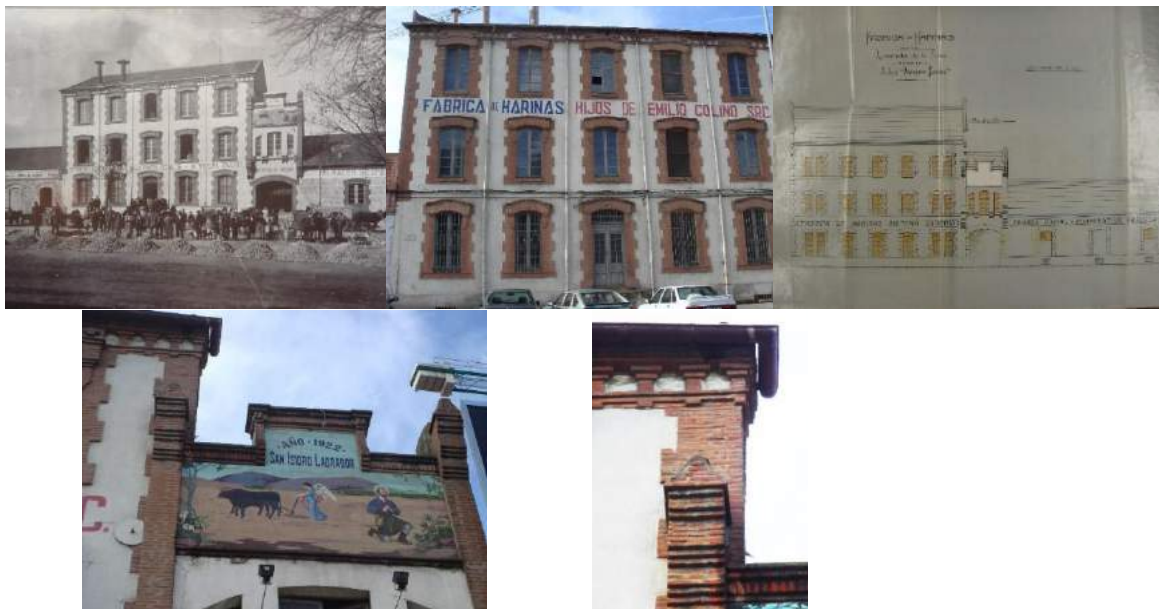
Figura 6. Fábrica de harinas de la Sociedad “La Panera Social”. Imagen de 1930 [15], estado actual y plano del alzado del proyecto original [11]. Detalle de las cornisas. Fotos autoras.
