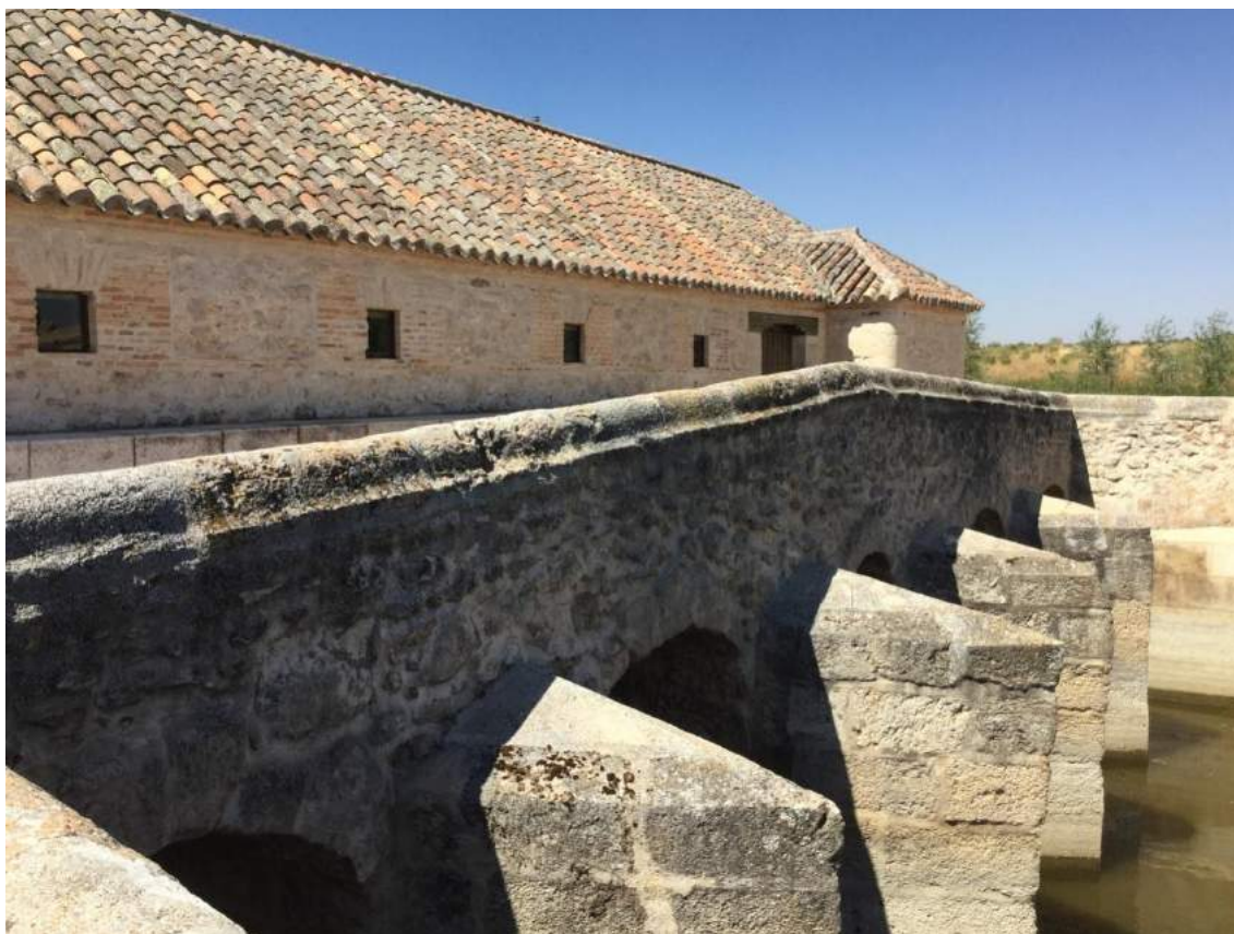
Figura 6. Aceña de Molemocho sobre el río Guadiana, en el término municipal de Daimiel (Ciudad Real), vista desde aguas arriba y se aprecian los tajamares los cárcavos, el puente sobre cárcavos y el edificio del molino harinero [Fotografía cedida por D. Jesús Muñoz Miguel]
