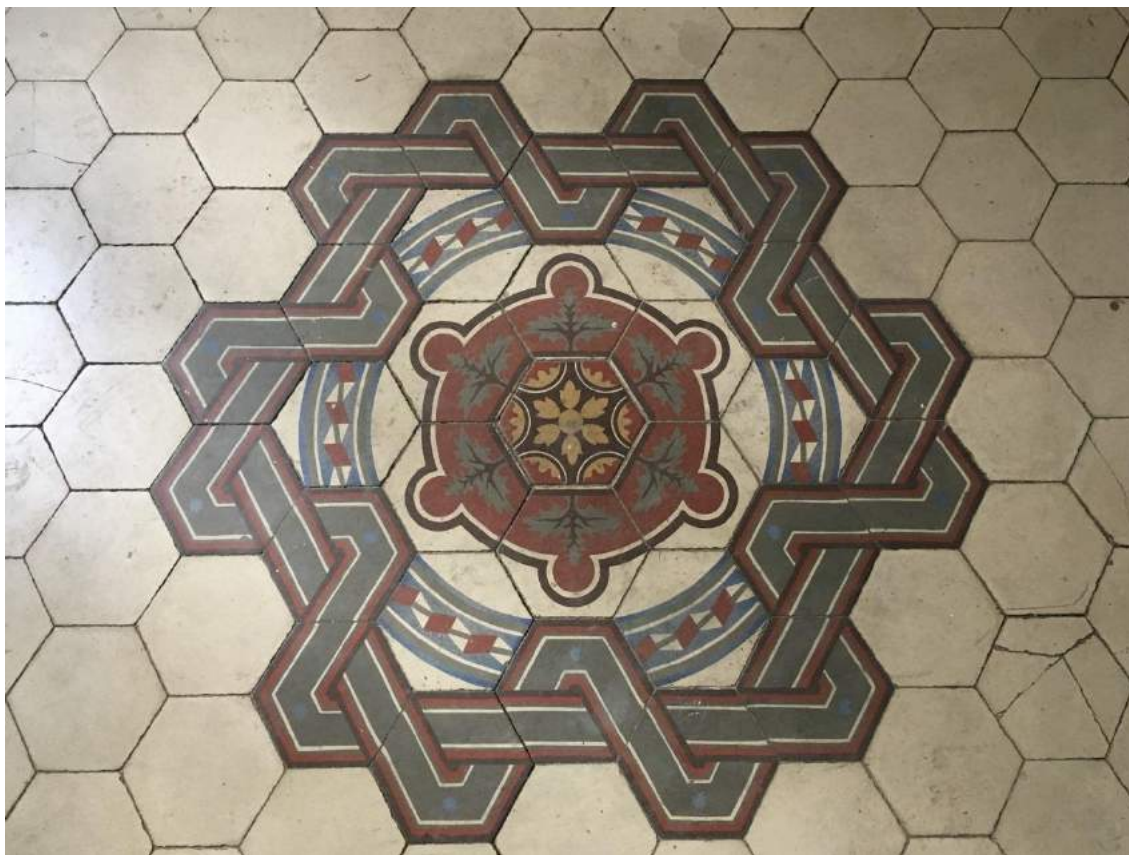
Figura 6. Solería de mosaico hidráulico de la fábrica de los hermanos Torres y López en vivienda sita en Gran Vía de Colón, 27. Fuente: Elaboración propia.
