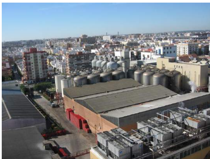
Figura 4. Silos de la fábrica ya completamente desarrollada. (Cortesía de Antonio García Caraballo)
