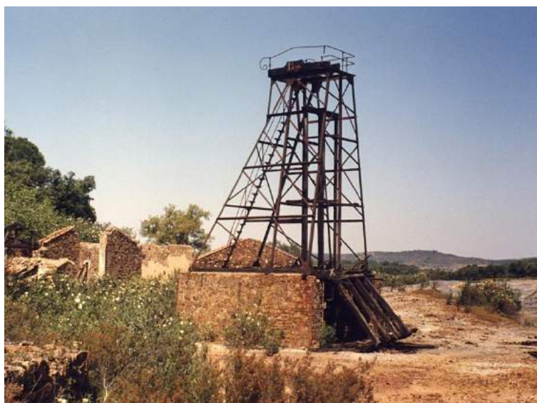
Malacate del Pozo Maestro de Cabezas del Pasto en su posición original y sin las ruedas guías de la parte superior. Foto 3
