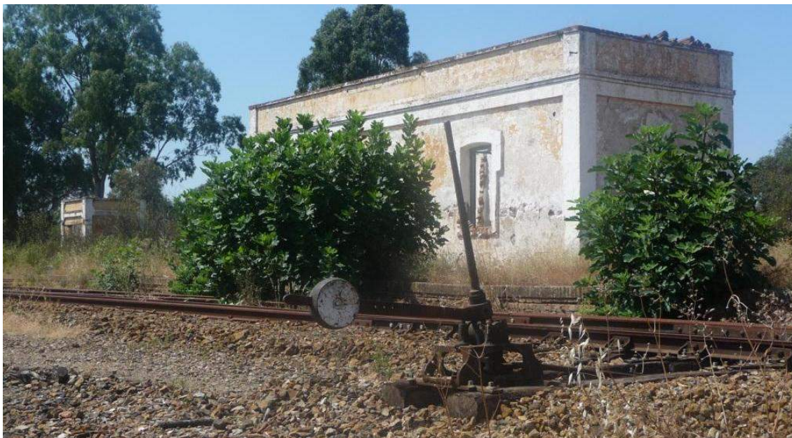
Figura 28. Imagen de la estación de Alosno.
