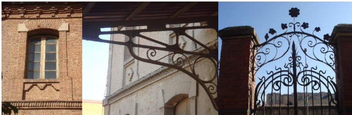
Figura 3. Fábrica de harinas de Gabino Bobo. Detalles de vano, marquesina y reja de fachada principal. Fotos autoras.
