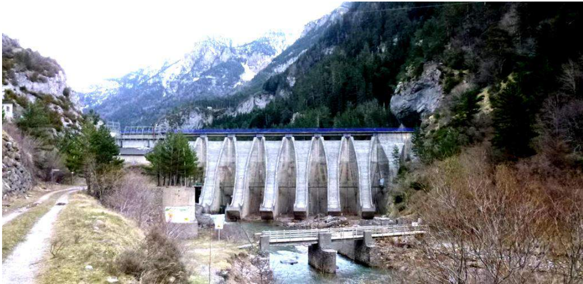
Figura 1: Presa de la Espelunga, vista aguas abajo.
