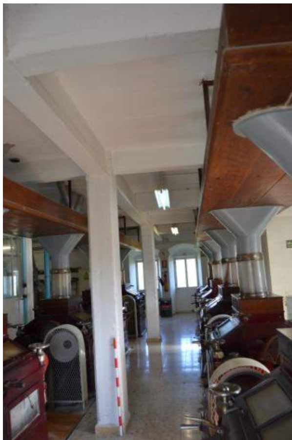
Figura 5: vista de la estructura de hormigón armado en la planta primera, donde se ubica la maquinaria original de molienda y clasificación de la harina. Fotografía de los autores.
