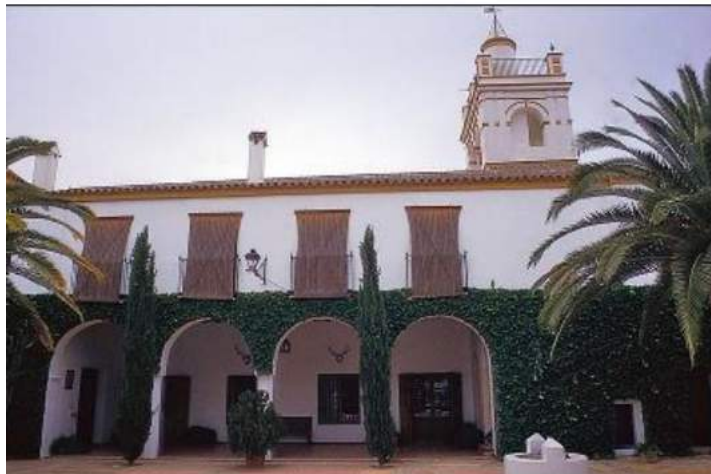
Figura 2. Exterior señorío y torre de contrapeso de la Hacienda de Seixa, Alcalá de Guadaíra (Sevilla)
