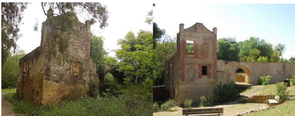
Figura 3. Molino de La Tapada antes y después de la intervención.
