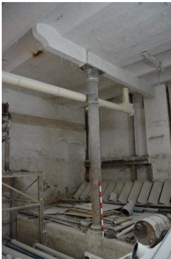
Figura 3: elementos estructurales de distinta naturaleza en el cuerpo occidental del edificio. Fotografía tomada por los autores
