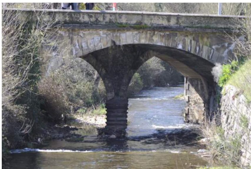
Fig. 4. Bóvedas y apoyo intermedio de hormigón en masa de la obra original de Ribera bajo el tablero actual. Fotografía Sara González García
