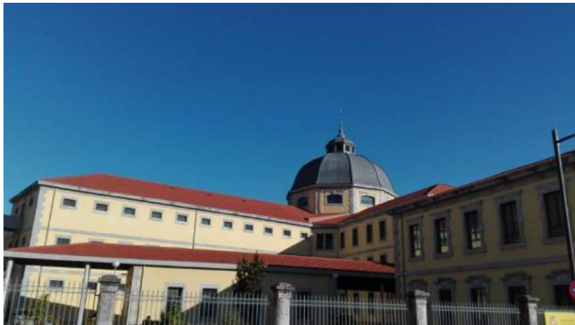
Fig. 1. Edificio de la antigua Cárcel Modelo de Oviedo. Fotografía de la autora
