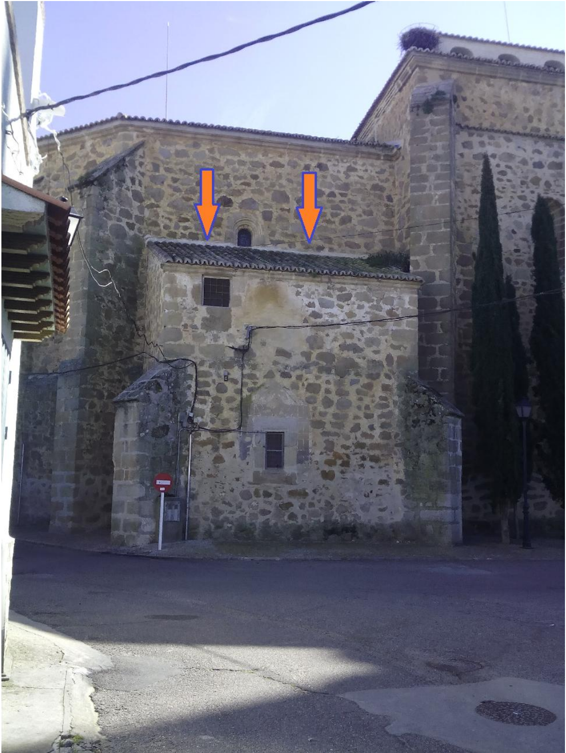
Figura 11. Vista exterior de la sacristía del templo alcaudetano. Con flechas se indica la zona de unión con el muro norte del ábside.
