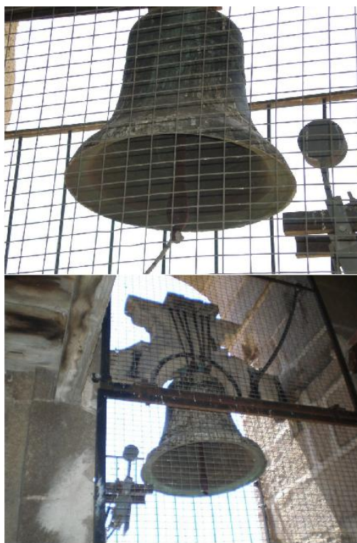
Figura 33. Campanas ubicadas en interior del último cuerpo de la torre
