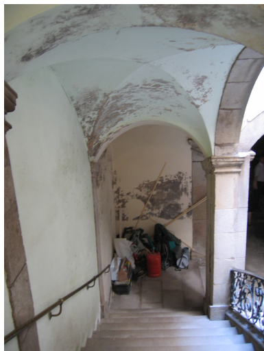
FIGURA 2. Mal estat de conservació de l'escala principal a planta noble de Ca l'Erasme. (Fotografia de R.M. Subirana)
