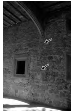
Fig. 26 Martitegui. Corredor del claustro. Crujía norte (al este). Detalle de arranques de arco diafragma de la primera fase conventual. Foto Matesanz.
