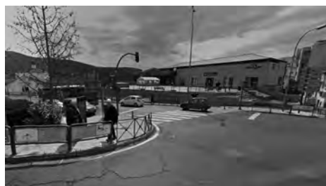
Fig. 54 Hospital de la Merced vista general del estado actual desde la zona de la puerta de Talavera. Foto Matesanz.
