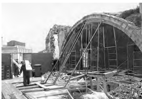
Fig. 52 Hospital de la Merced durante el proceso de demolición y desmontaje parcial del ábside. Foto Hoy.
