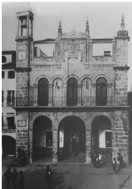
Fig. 41 Fachada Ayuntamiento. Francisco Mirón. Fachada realizada en 1935.
