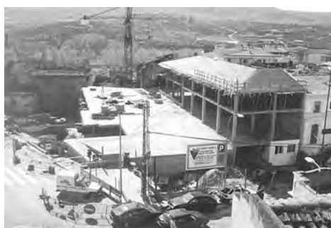
Fig. 53 Hospital de la Merced, ya demolido y durante el proceso de construcción del aparcamiento. Foto Hoy
