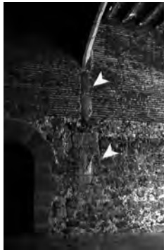
Fig. 25 Martitegui. Corredor del claustro. Crujía norte. Detalle de arranques de arco diafragma de la primera fase conventual. Foto Matesanz.
