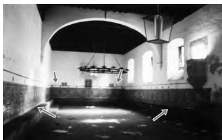
Fig. 23 Martitegui. Refectorio antes de la intervención. Foto Matesanz.
