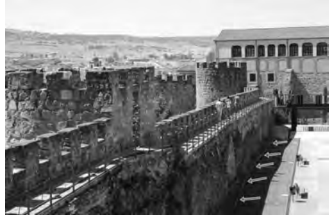
Fig. 8 Feduchi y Temprano. Torre Lucía. Estado final. El grosor real de la muralla en planta.
