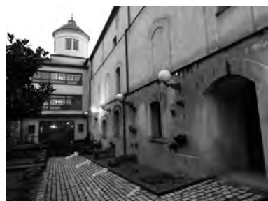
Fig. 28 Martitegui. Patio al oeste. Después de la intervención. Contrafuertes. Foto Matesanz.
