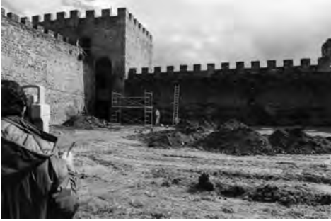
Fig. 7 Feduchi y Temprano. Torre Lucía. Toma de datos para fotogrametría (Matesanz y Sánchez). Foto Matesanz.
