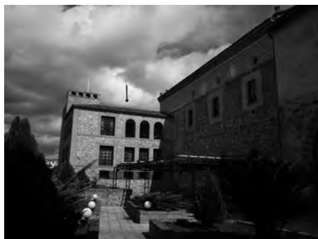
Fig. 21 Martitegui. Realizada la intervención. Nuevo edificio en la esquina NO. Falso histórico. Foto Matesanz.
