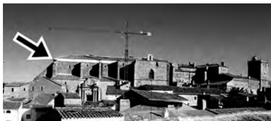
Fig. 19 Hernández Gil, Hernández de León y Casas. Vista general desde el sur realizada la intervención. Foto Matesanz.
