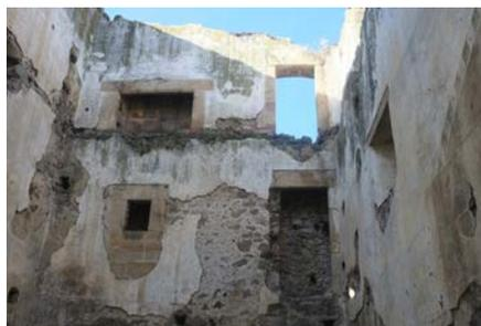
Muros de mampostería de granito, originariamente estuvo recubierto de cal y argamasa
