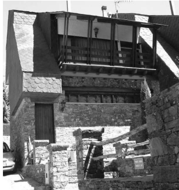
Edifici nou a Nevà (Toses, Ripollès)
