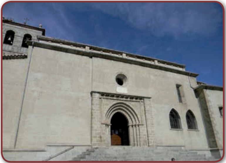
Fachada principal de la iglesia de El Salvador
