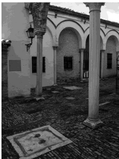
Patio de los naranjos, del que aún se conservan una parte del claustro porticado de arcos de medio punto sobre columnas.
