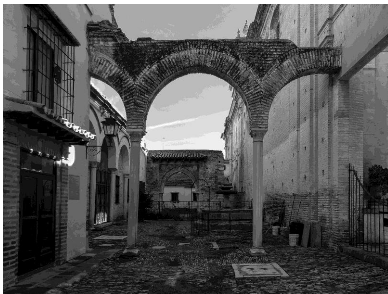
Detalle del patio de los naranjos con las bóvedas de fábrica para los enterramientos, la fuente y el arco mudéjar al fondo.
