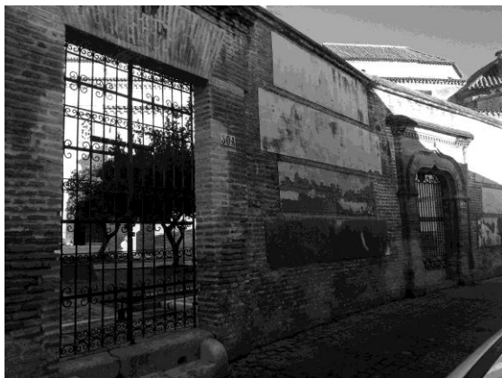
Acceso al antiguo cementerio de la iglesia parroquial de Santiago desde la Calle Coronado.
