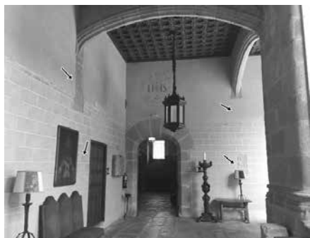
Fig. 3. Esquina SO del claustro. Arcos diafragma 2ª F. C. y restos de arranques de la 1ª F. C.
