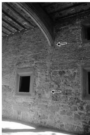
Fig. 8. Claustro. Lateral NE. Arco diafragma de la 2ª F. C. y ménsula repicada de la 1ª F. C.
