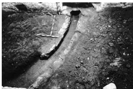
Fig. 34. Atarjea sobre relleno en la planta baja de la 1ª F. C.
