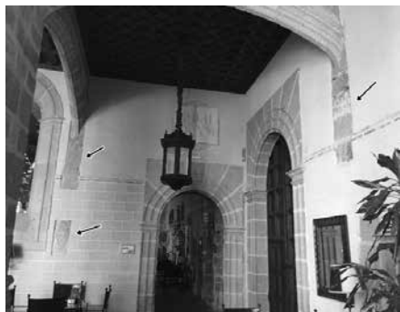
Fig. 2. Esquina SE del claustro. Arcos diafragma 2ª F. C. y restos de arranques de la 1ª F. C.
