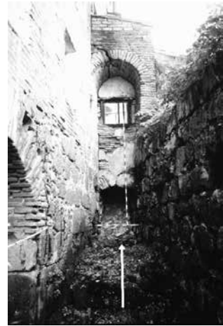
Fig. 20. Arco apuntado en el inferior que podría estar situando el exiguo paso que existiría en la conexión del edificio conventual con la muralla hasta el cierre definitivo.
