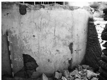
Fig. 36. Vano en el muro O de la crujía O.
