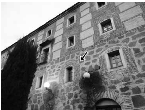
Fig. 30. Vista parcial de la fachada N del ala de celdas. 2ª F. C. (Foto Paqui Díaz)
