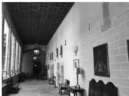
Fig. 4. Lateral sur del corredor sur del claustro.
