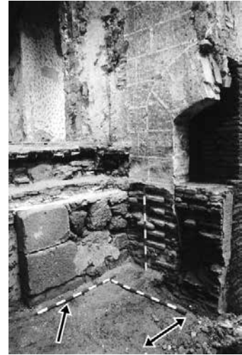
Fig. 12. Restos de contrafuertes al N.
