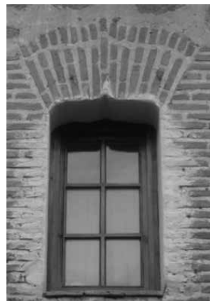
Fig. 31. Detalle de una de las ventanas.
