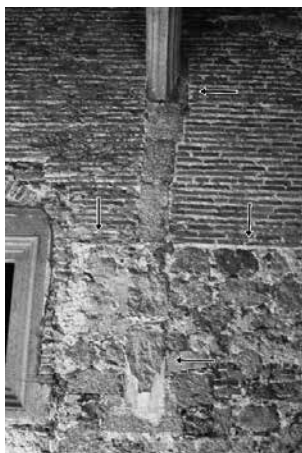
Fig. 9. Claustro. Lateral NE. Detalle de las ménsulas de la 1ª y 2ª fases.
