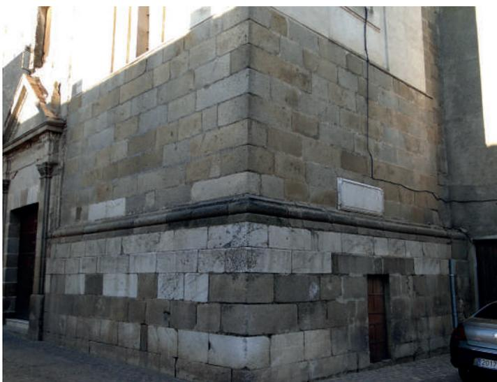
Fig. 5: Sillares del zócalo y primer cuerpo de la torre nueva
