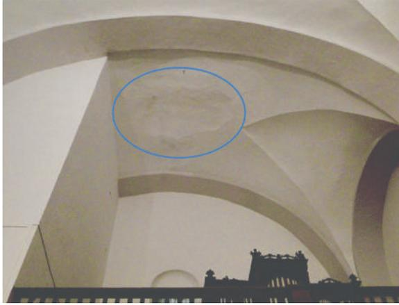
Fig. 2: Iglesia parroquial de Fuente de Cantos. Bóveda del coro con señales de los daños causados por la caída del reloj de la torre
