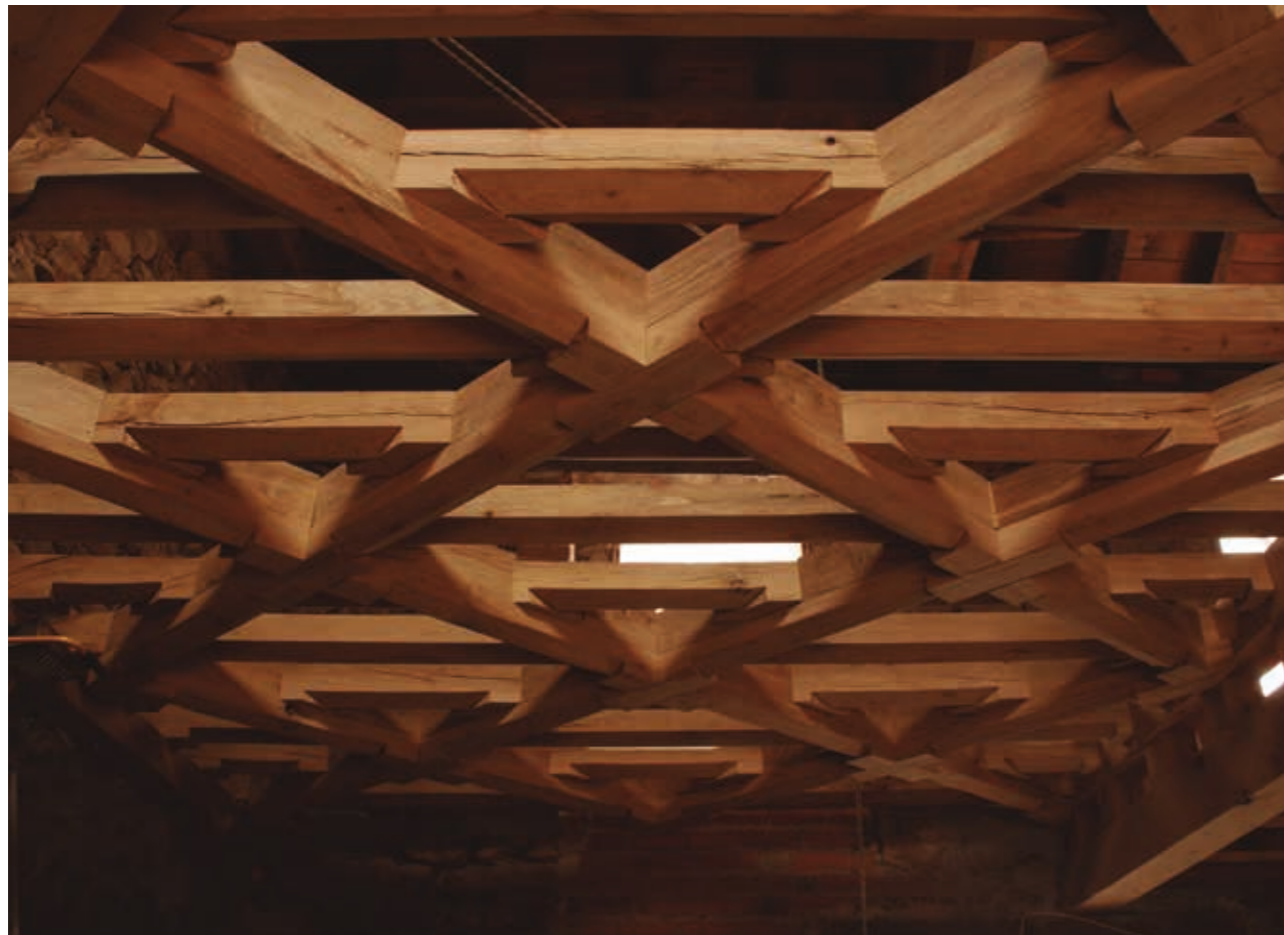
Vista del proceso de construcción de forjado
