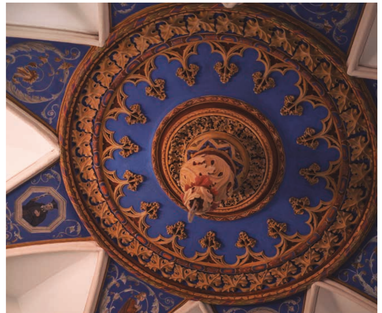
Vista de la parte central de la bóveda encamonada
