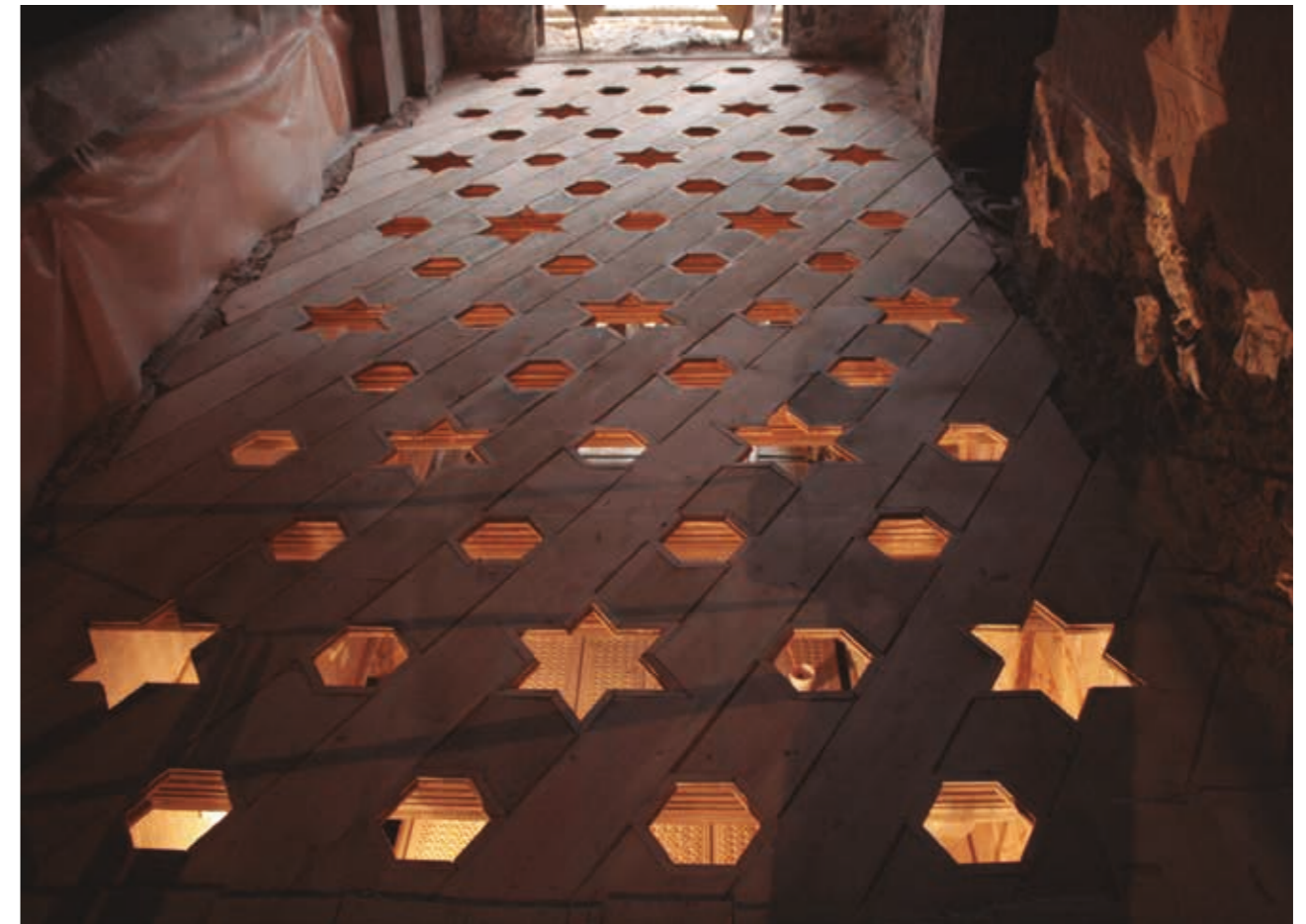
Proceso de restauración del artesonado
