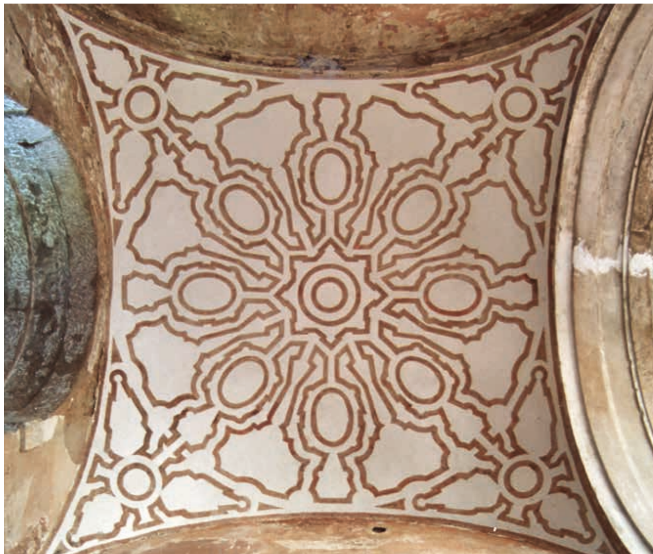
Vista de una bóveda con esgrafiados
