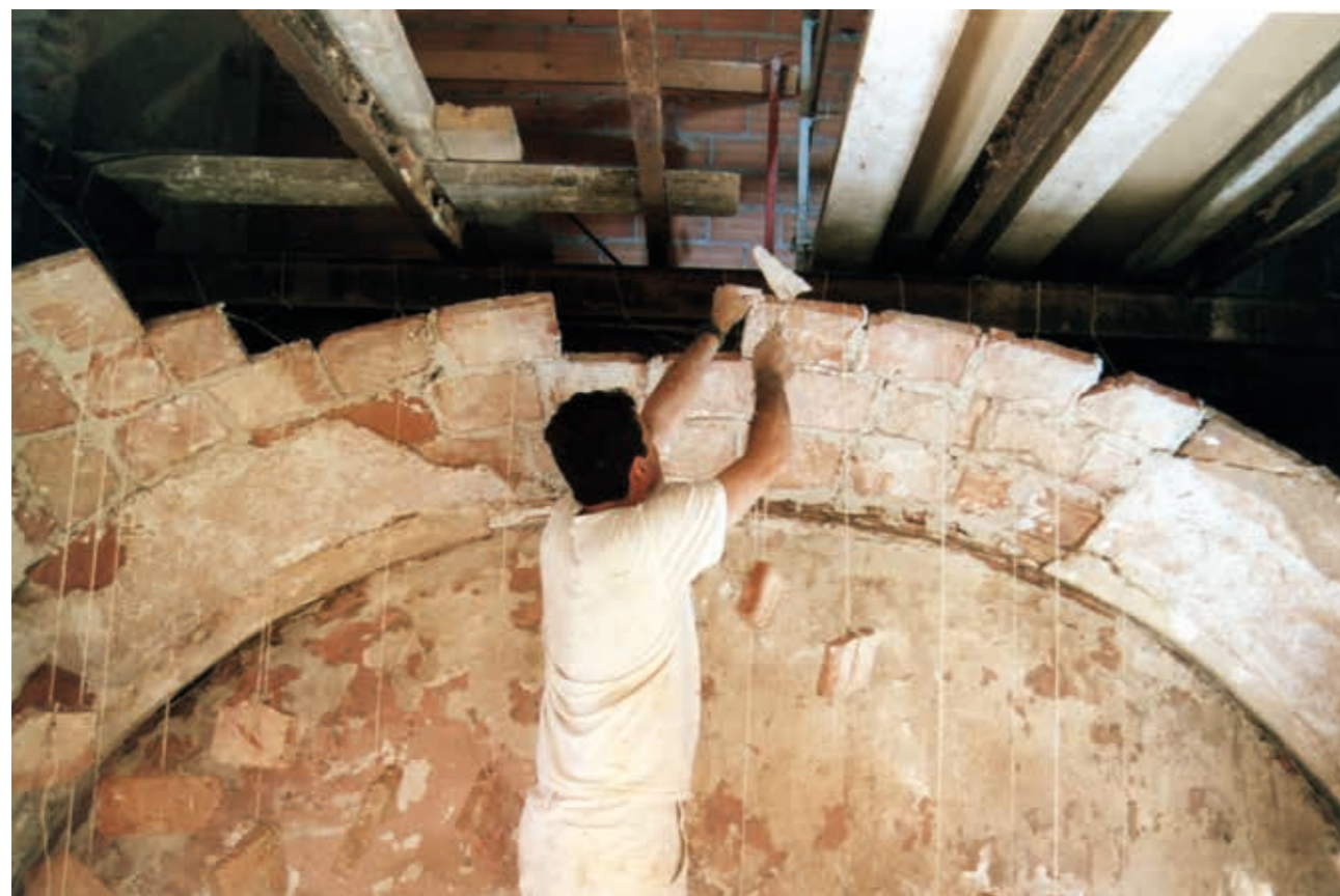
Construcción de una bóveda en el Colegio San Basilio Magno, Alcalá de Henares, Madrid
