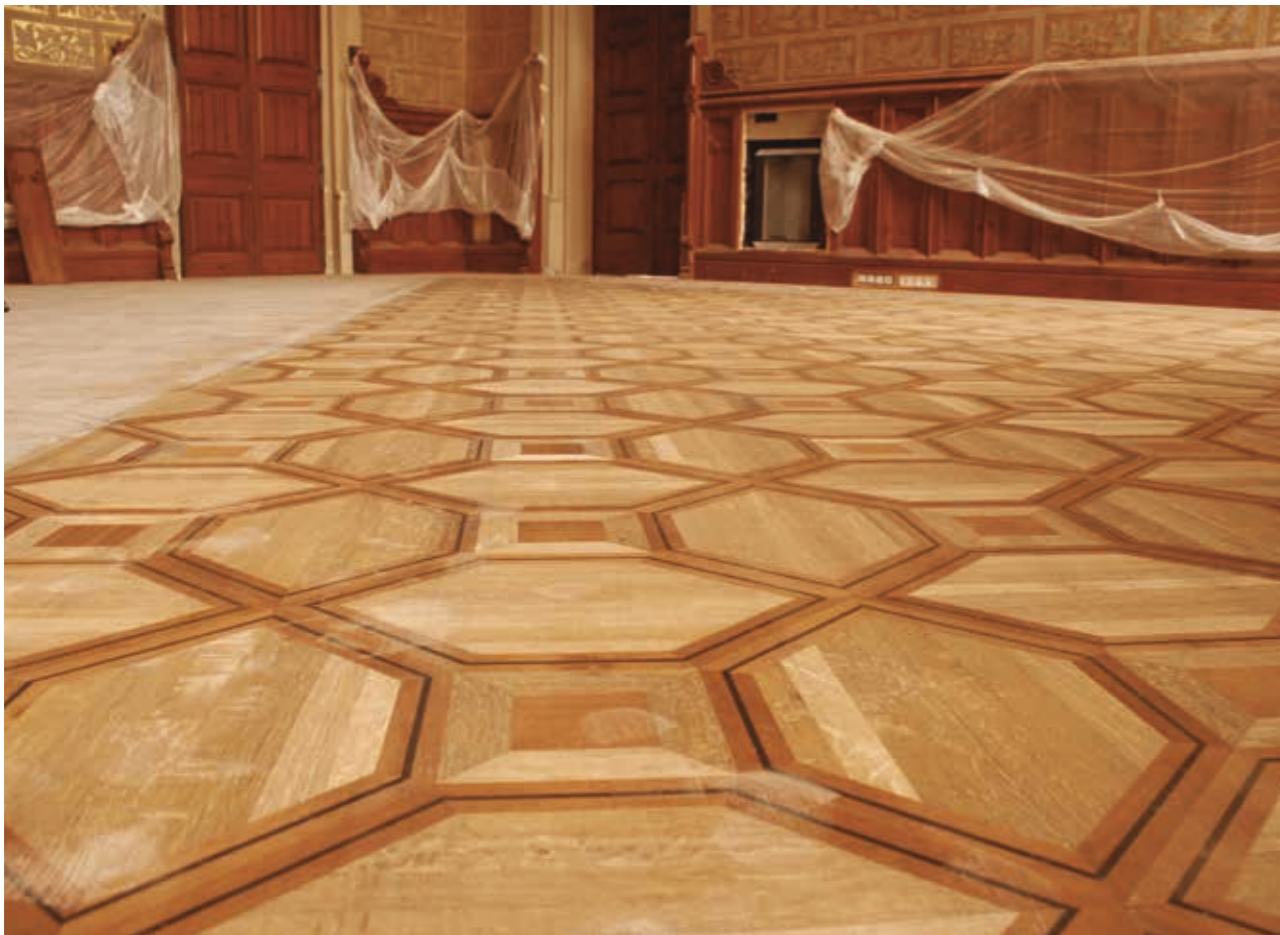
Proceso de restauración del pavimento histórico
